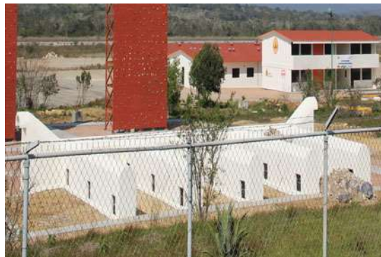
Deslizamiento de Laderas
