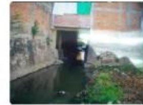
Asentamientos humanos irregulares en zonas de riesgo
