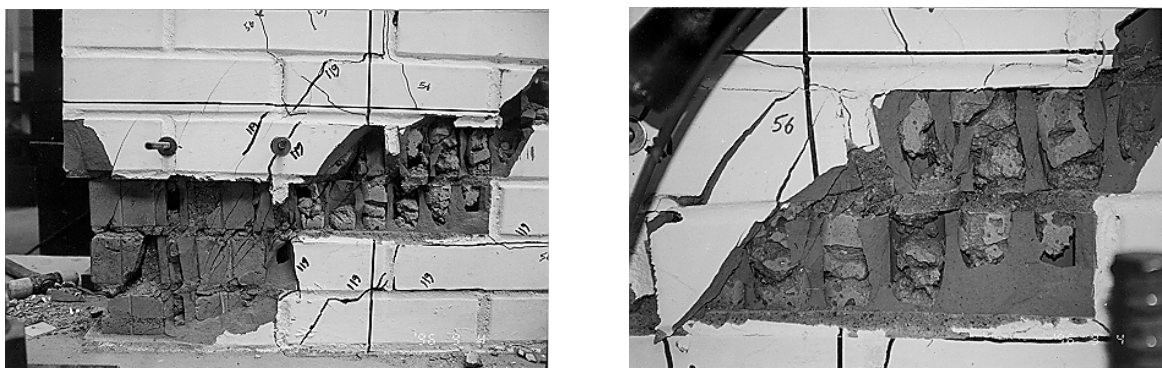
Figura 3.6 - Condición final de daño (castillo Este)
