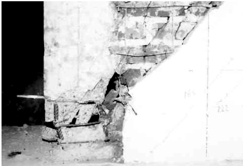
Figura 3.28 Modelo M-072: detalle del flexionamiento del refuerzo longitudinal en la base del castillo Oeste
