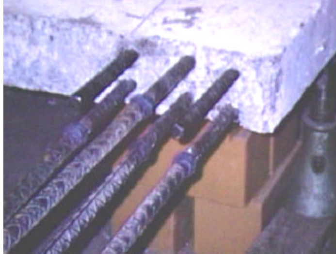
Figura C.1 Extensión de barras con soldadura a gas y presión (nótese los bulbos de conexión)
