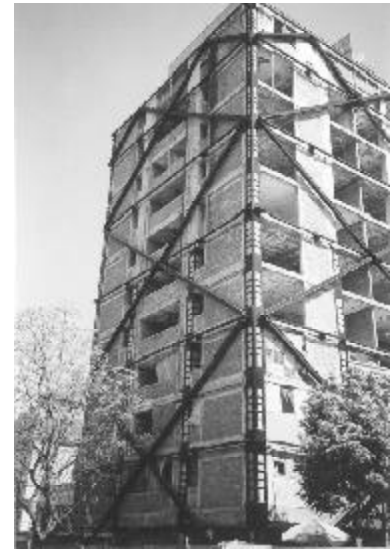
Figura 50. Rehabilitación sísmica en un edificio de la Ciudad de México. Para estudiar su comportamiento se instalaron acelerógrafos en sus diferentes niveles (CENAPRED)
