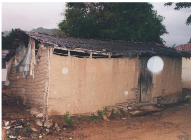
Figura 4.5 Vivienda típica de bajareque (nótese el enramado en el muro cabecero)
