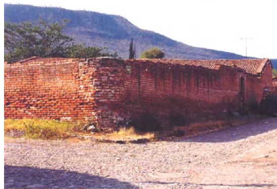
Figura 7.76 Tendencia a construir bardas de gran longitud de mampostería simple (sin refuerzo de elementos para resistir momento fuera del plano)
