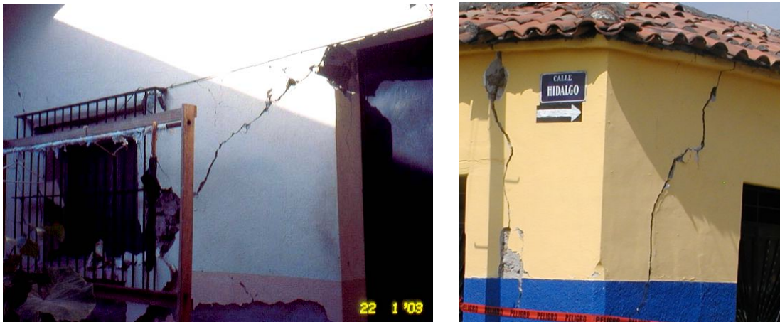
Figura 7.6 Agrietamiento inclinado
