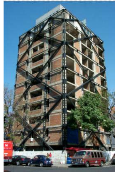
Figura 4.2 Arreglo del sistema de contraventeo y su instrumentación
