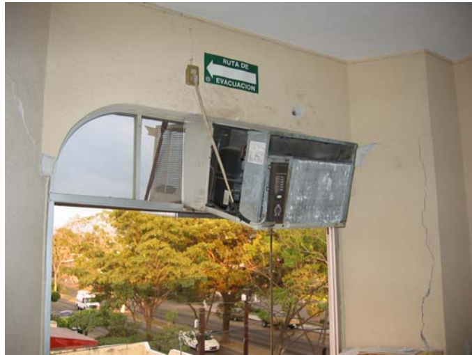
Figura 11.7 Ejemplo del daño en los ventanales de la fachada
