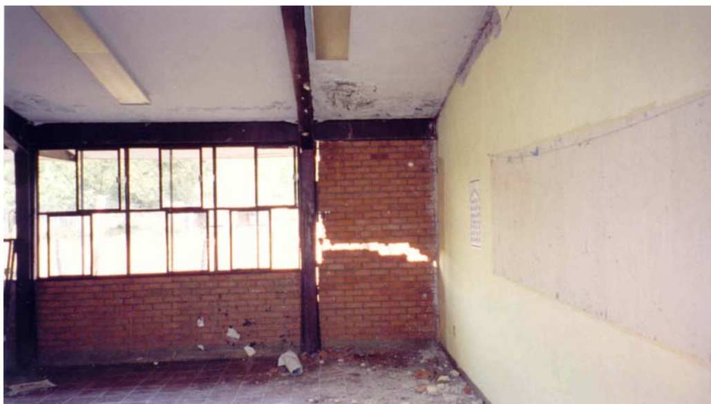
Figura 8.15 Daño en muros de relleno en una escuela secundaria en el poblado de El Chante, municipio de Autlán de Navarro
