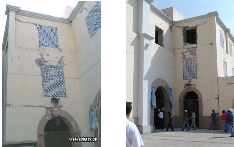
Figura 10.18 Patrones de daño en los muros de mampostería en el crucero, lado Norte y Sur
