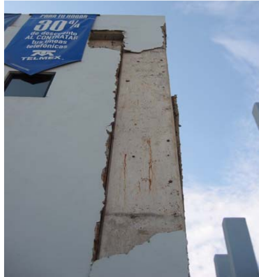
Figura 12.4 Caída del aplanado en un elemento estructural por defectos constructivos
