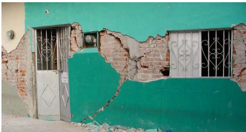
Figura 7.62 Daño severo representativo de vivienda de mampostería de tabique (el castillo está al centro del muro y no en sus bordes), Villa de Álvarez, Col.
