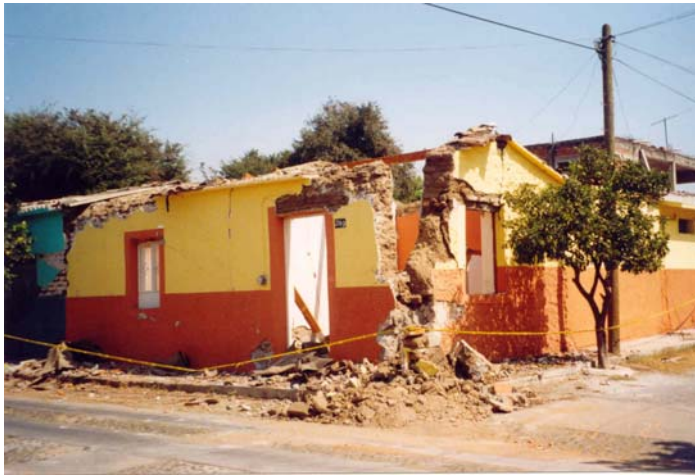
Figura 7.33 Daño en edificaciones de adobe sin liga entre muros ortogonales
