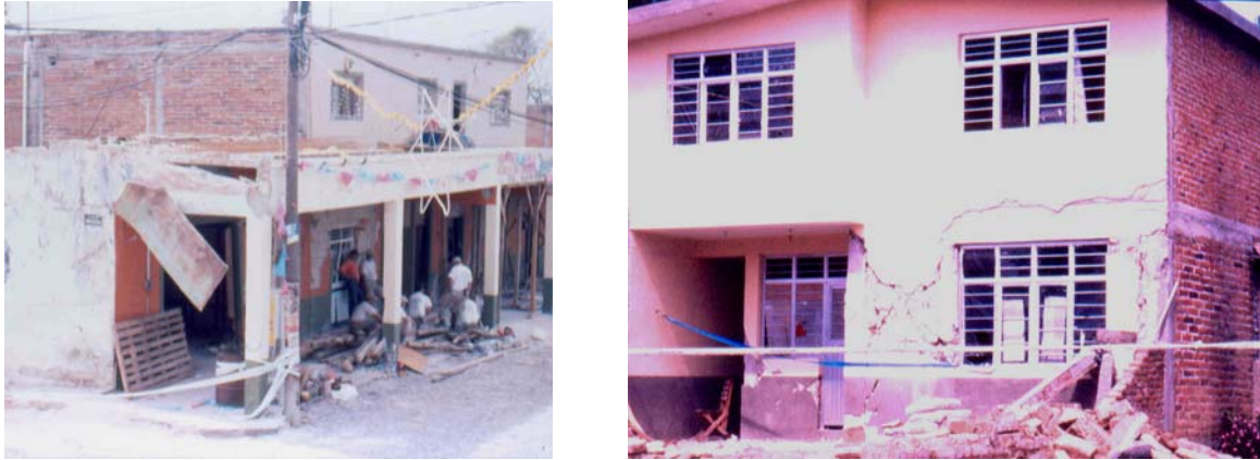
Figura 7.102 Agrietamiento diagonal en muros de primer nivel (piso débil)
