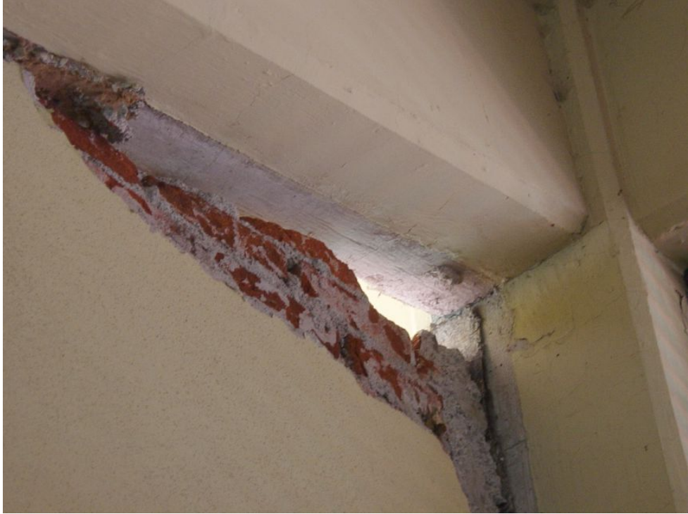
Figura 9.17 Daño en muro divisorio del Hospital del IMSS en Coalcomán
