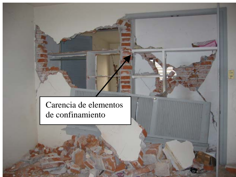
Figura 7.21 Daño severo en un muro de la dirección longitudinal de la planta baja del edificio
