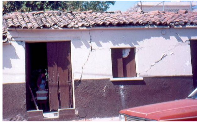
Figura 7.7 Agrietamiento inclinado
