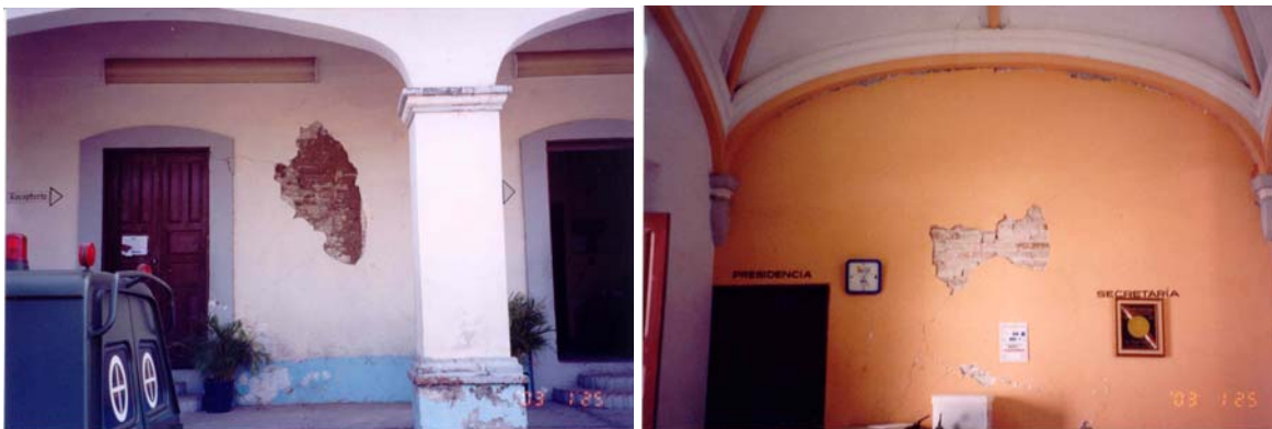
Figura 8.10 Daños observados en la Presidencia Municipal de Coquimatlán
