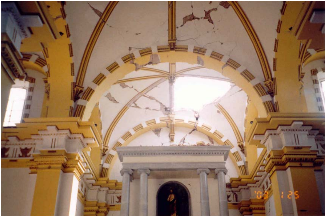
Figura 10.12 Caída parcial de la cúpula del crucero
