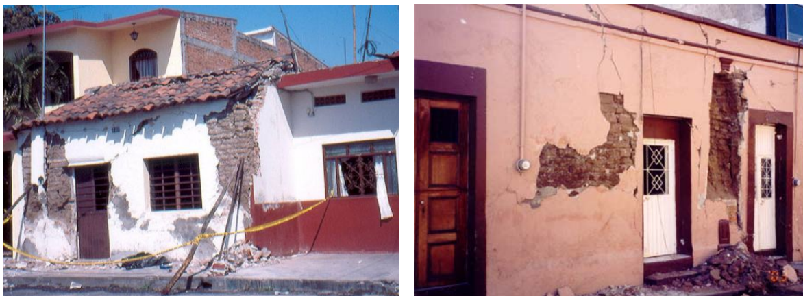
Figura 7.15 Caída de acabado y agrietamiento de los muros
