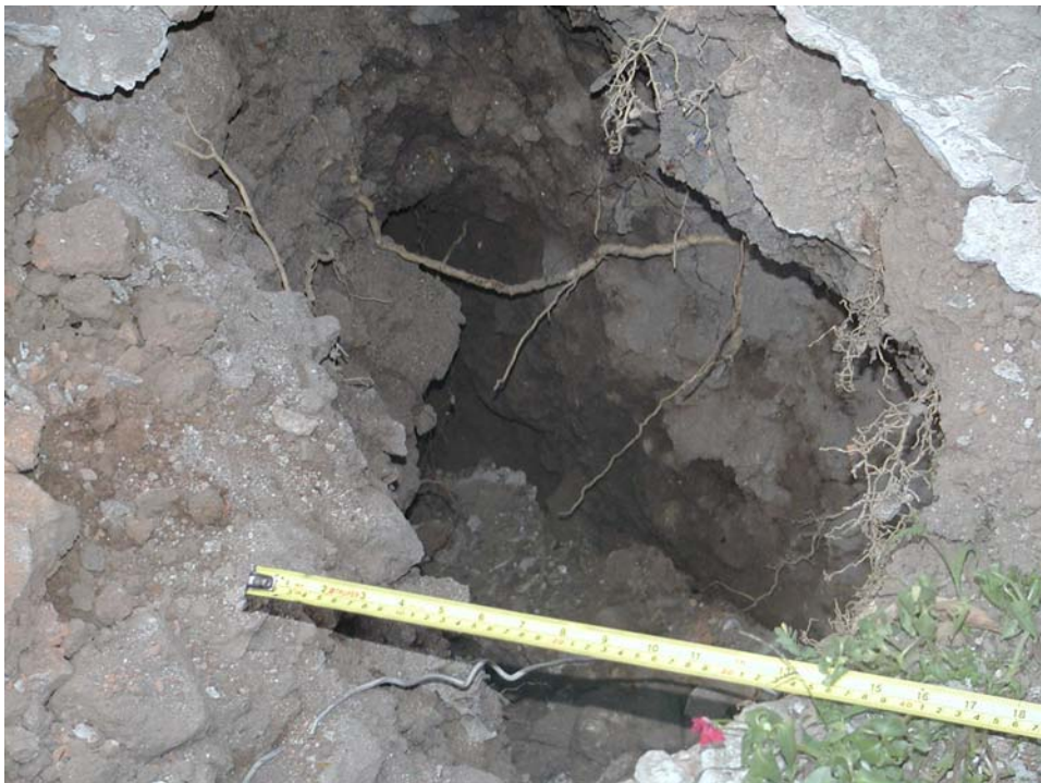
Figura 5.8 Asentamiento brusco del terreno en los patios de algunas casas ubicadas en el municipio de Villa de Álvarez
