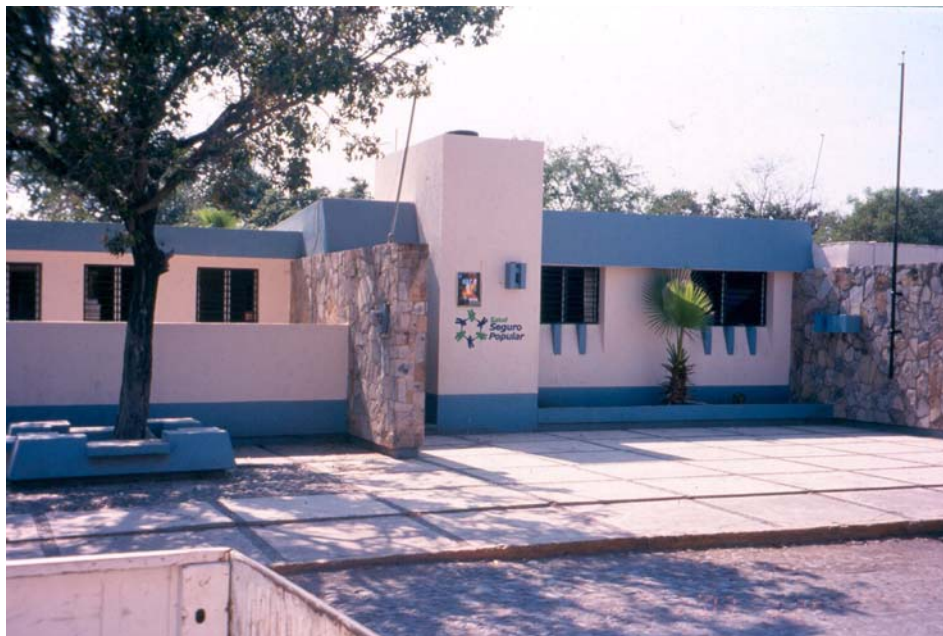
Figura 9.16 Edificio del Sector Salud (Seguro Popular)
