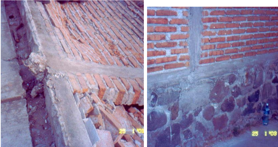
Figura 7.131 a) Detalle de la falta de anclaje del castillo a la cimentación; b) Otro tramo de la misma barda que no falló, y donde se aprecia un mejor anclaje del castillo
