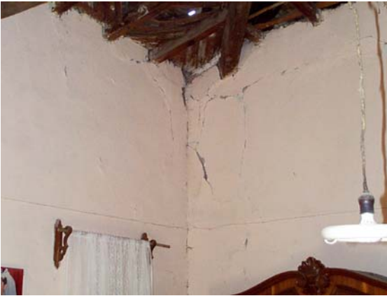
Figura 7.89 Agrietamiento en la intersección de muros
