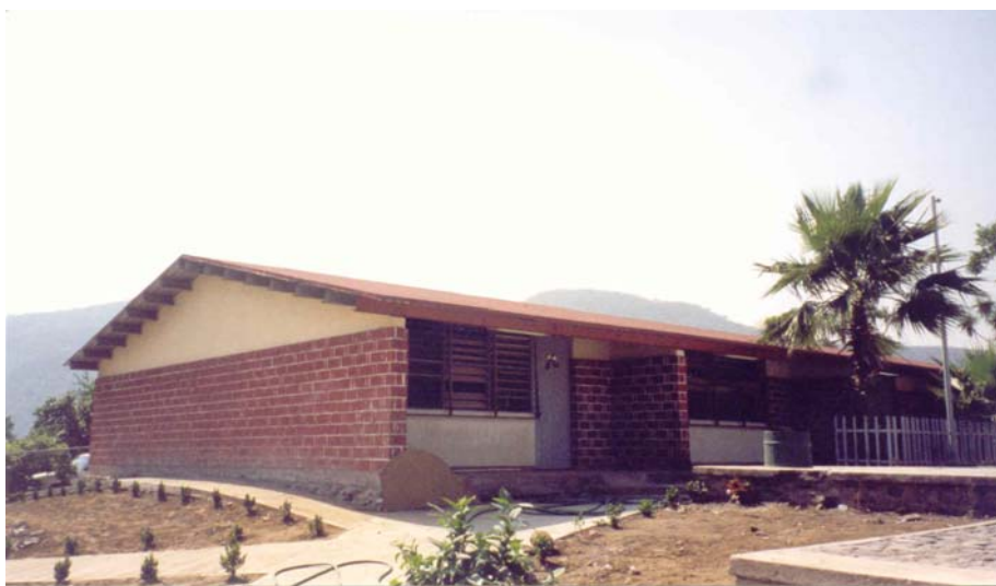
Figura 8.12 Vista exterior de un edificio de una escuela primaria si daño
