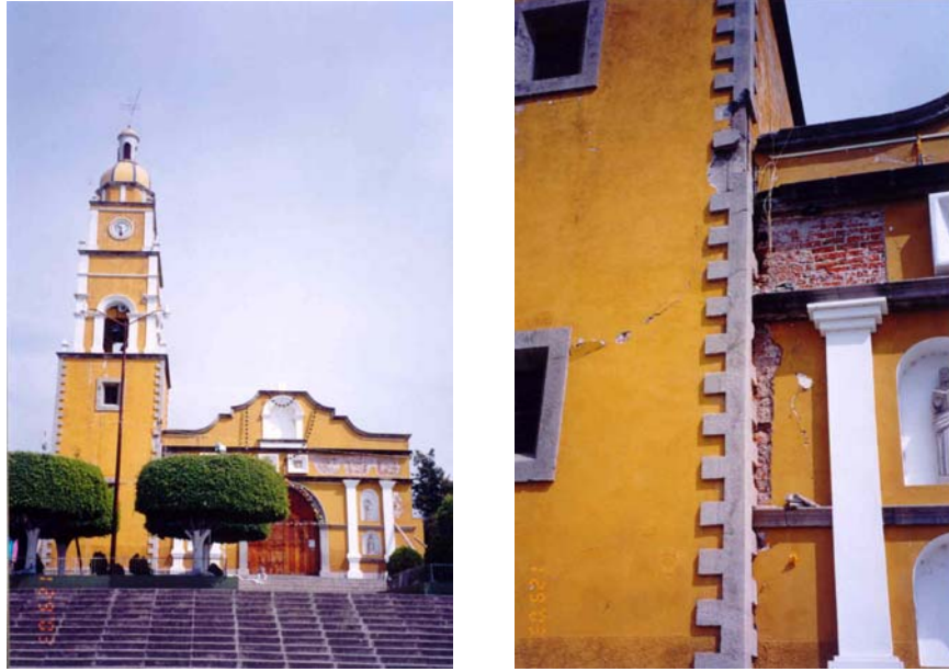
Figura 10.24 Daños medios entre los cuerpos que componen la estructura de la fachada de iglesias
