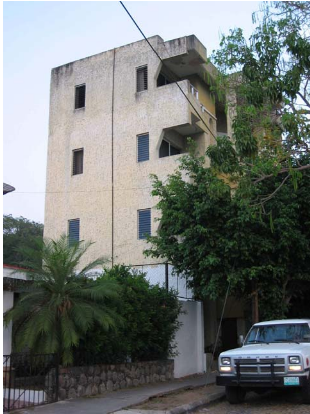
Figura 7.28 Fachadas lateral y frontal
