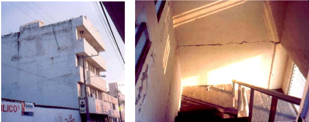
Figura 8.2 Vista general del edificio y muros del cubo de escaleras
