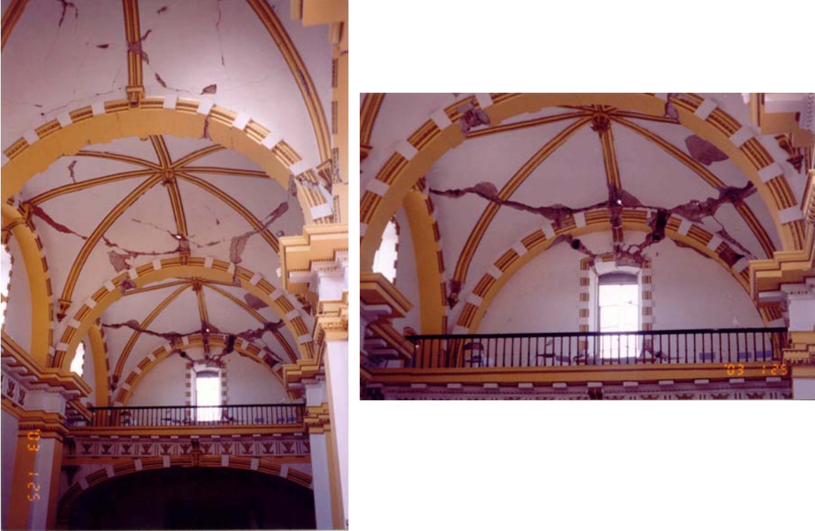
Figura 10.11 Daño observado en las cúpulas de la iglesia
