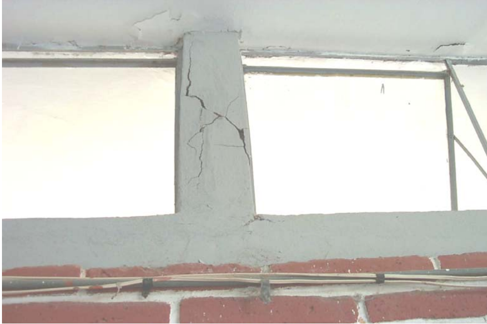
Figura 8.19 Daño por esfuerzo cortante en un elemento corto de concreto reforzado
