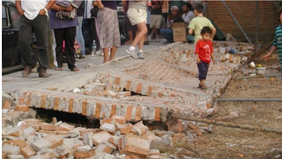
Figura 7.130 Caída de barda de mampostería confinada con defectos
