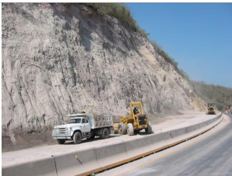
Figura 13.9 Derrumbes en la Autopista 110 entre Manzanillo y Colima
