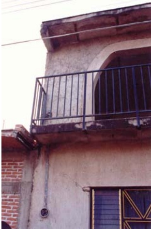
Figura 7.74 Agrietamiento en mampostería confinada con elementos de concreto reforzado de segundos niveles sobre un primer nivel con muros de adobe sin refuerzo
