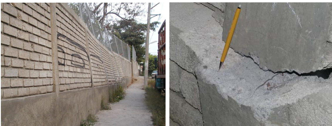
Figura 7.128 a) Desplomo de una barda que quedó "colgando" de la cadena superior. b) Detalle de la fractura del refuerzo (electrosoldado con cuantía evidentemente insuficiente)
