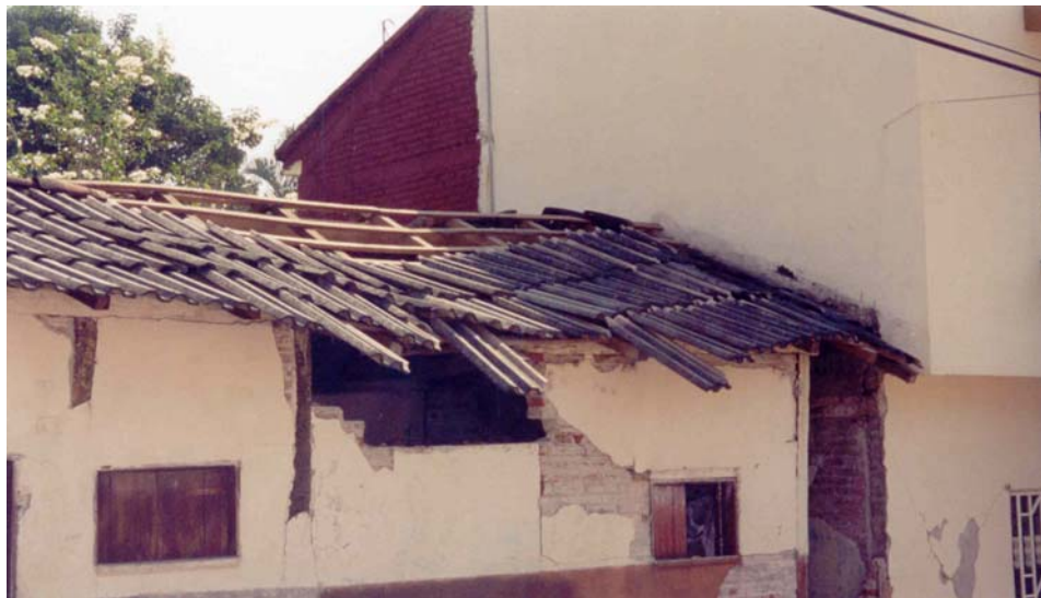
Figura 7.52 Vivienda número 3 con daño tipo III
