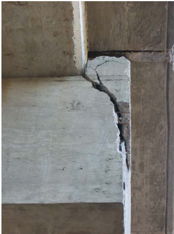
Figura 6.6 Daño en tope del puente “Manzanillo”
