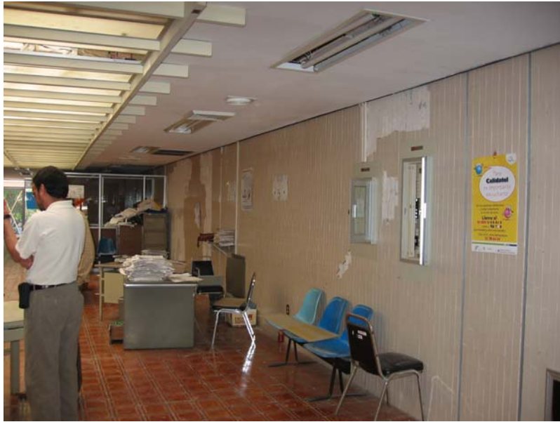
Figura 9.11 Caída de acabados en muros del edificio de Consulta Externa
