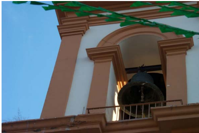
Figura 10.21 Daños ligeros observados en las columnas de los campanarios en iglesias del estado de Jalisco, ubicadas en la vecindad del municipio de Guadalajara
