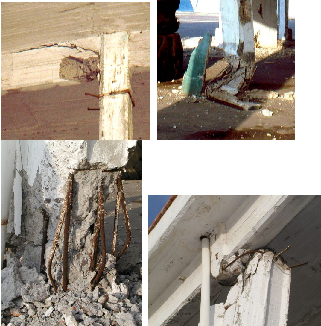
Figura 6.4 Detalles de daño en la estructura
