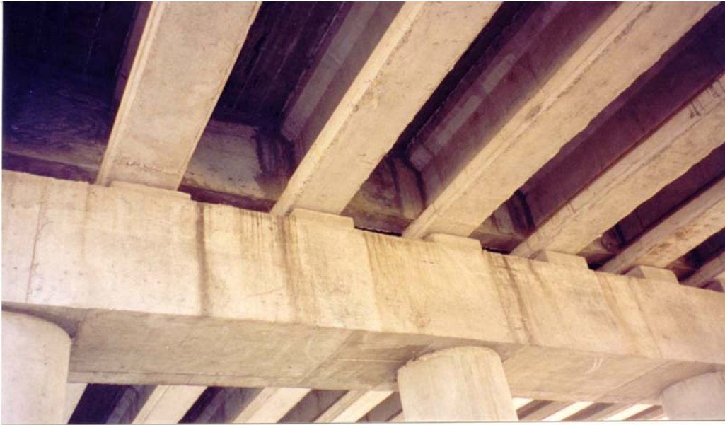
Figura 6.7 Desfase de su posición original de las vigas precoladas del puente “Manzanillo”
