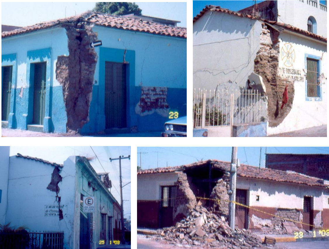
Figura 7.8 Grietas verticales y colapso de esquinas
