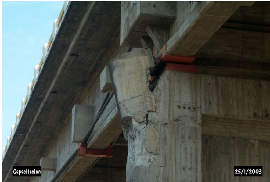
Figura 6.9 Daño severo en tope del puente Coahuayana (foto: Dirección Estatal de Protección Civil del estado de Michoacán)
