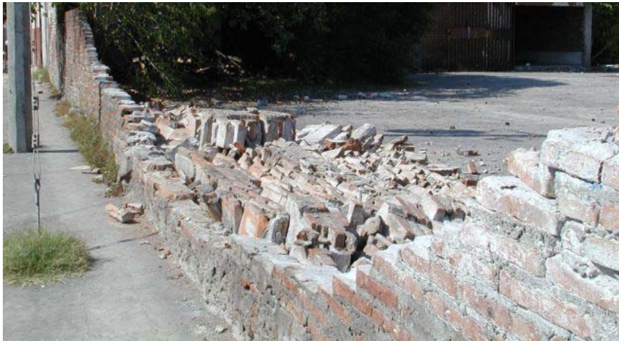
Figura 7.124 Colapso de una barda de mampostería no reforzada
