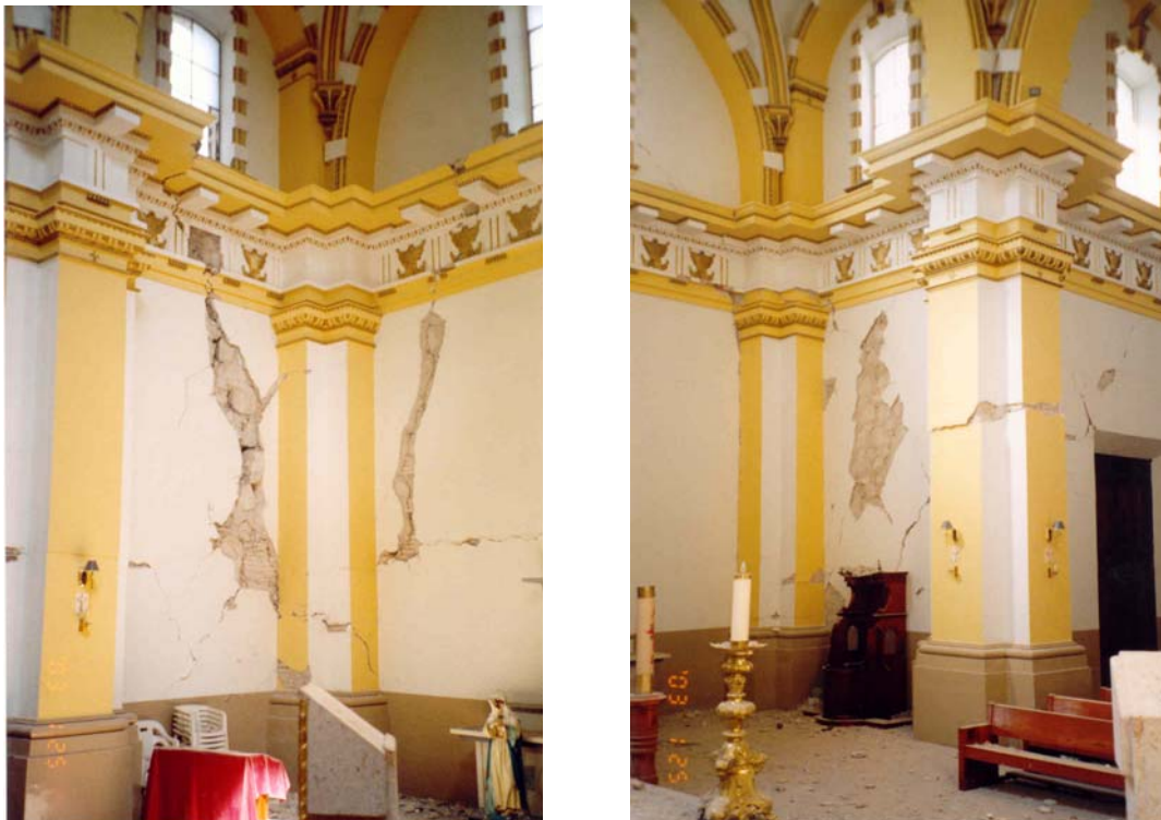
Figura 10.10 Daño observado en algunos de los muros de la iglesia
