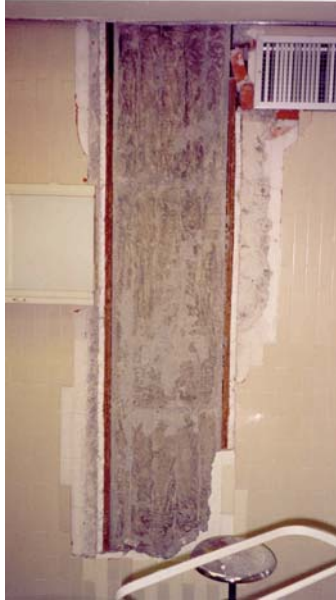
Figura 9.5 Deficiente separación entre los muros divisorios y los elementos estructurales
