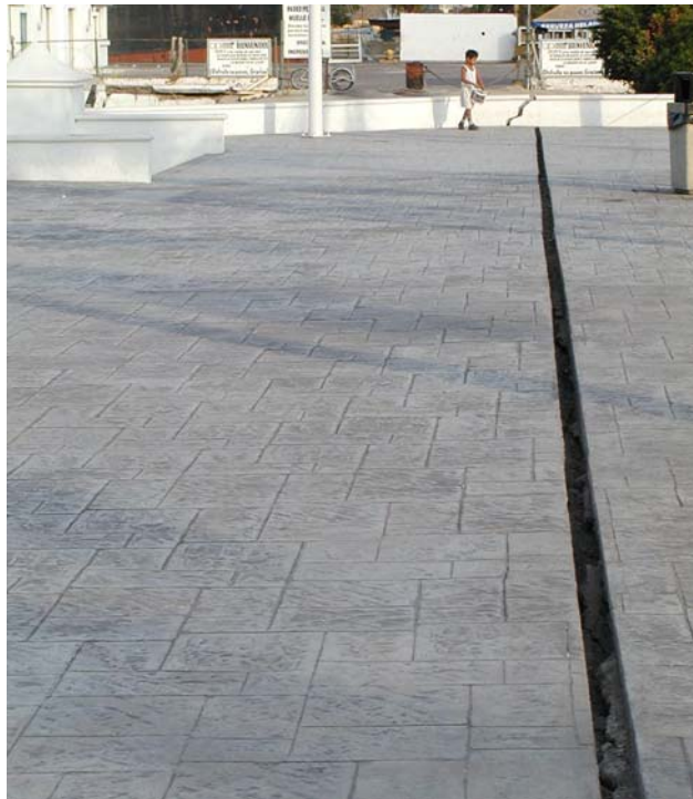
Figura 5.1 Desplazamiento del piso en el muelle fiscal de Manzanillo por efecto de licuación de suelos
