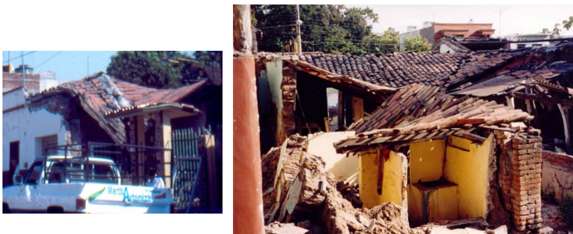
Figura 7.12 Colapso de techos por la caída de muros de soporte
