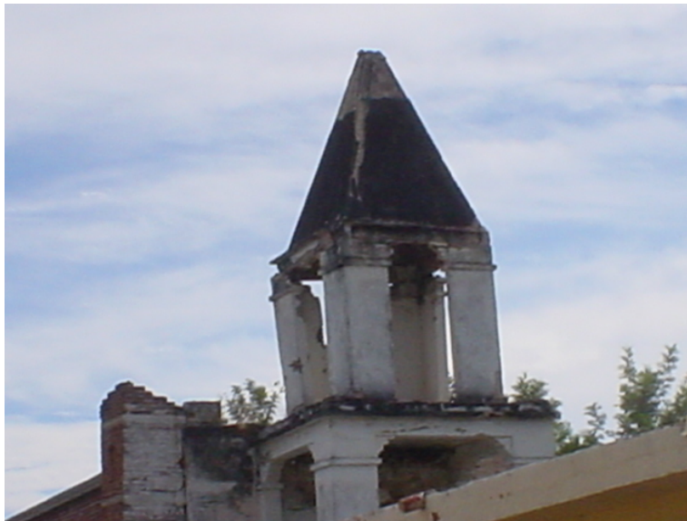
Figura 10.25 Daños severos en los extremos de las columnas de la estructura de campanario
