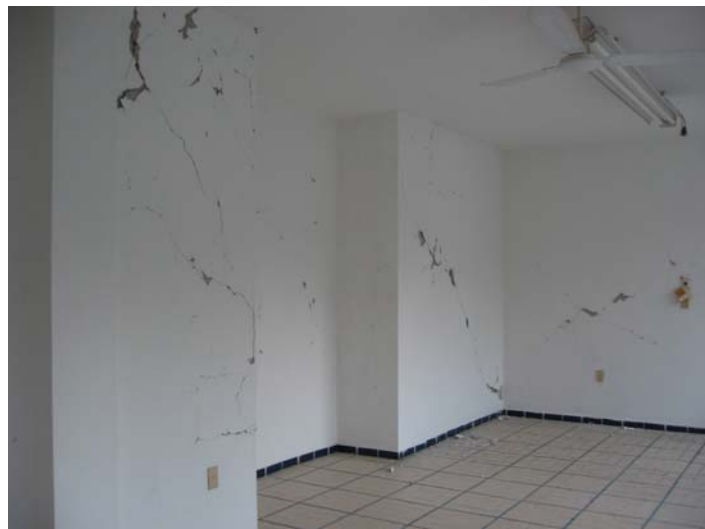
Figura 7.29 Daño observado en la planta baja
