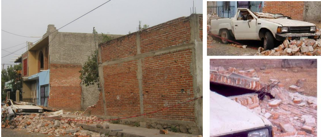
Figura 7.127 Colapso de barda de mampostería confinada que aplastó al vehículo estacionado en la calle
