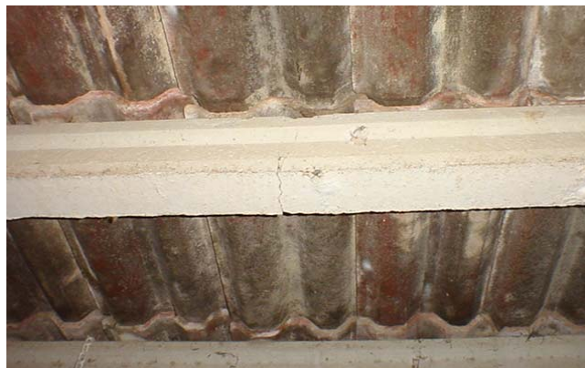
Figura 7.68 Agrietamiento por flexión en viguetas de concreto reforzado que soportan la tejas de barro
