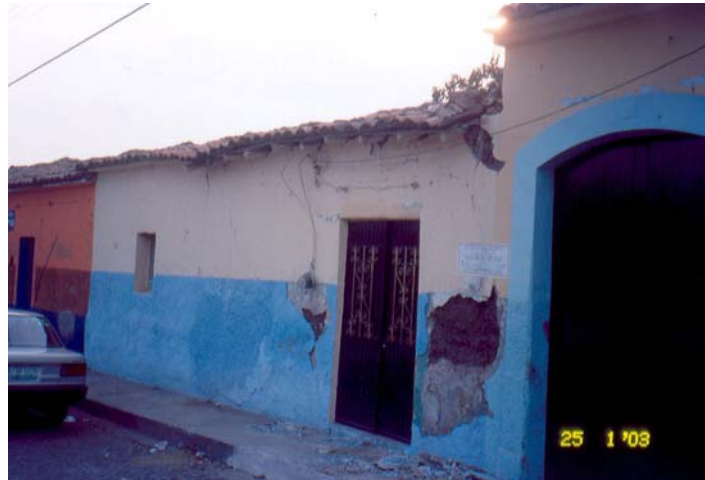
Figura 7.57 Daño ligero en vivienda de adobe
