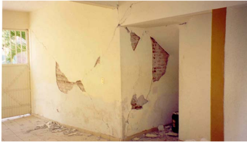
Figura 7.49 Muros dañados en el interior de la vivienda no. 11
