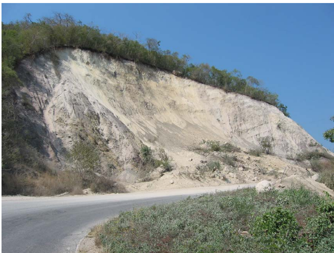
Figura 5.9 Deslizamiento ocurrido en un corte de la carretera Colima-Tecomán
