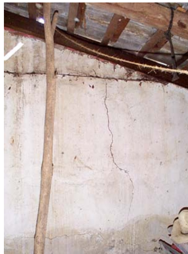
Figura 7.79 Agrietamiento vertical en muros cabeceros
