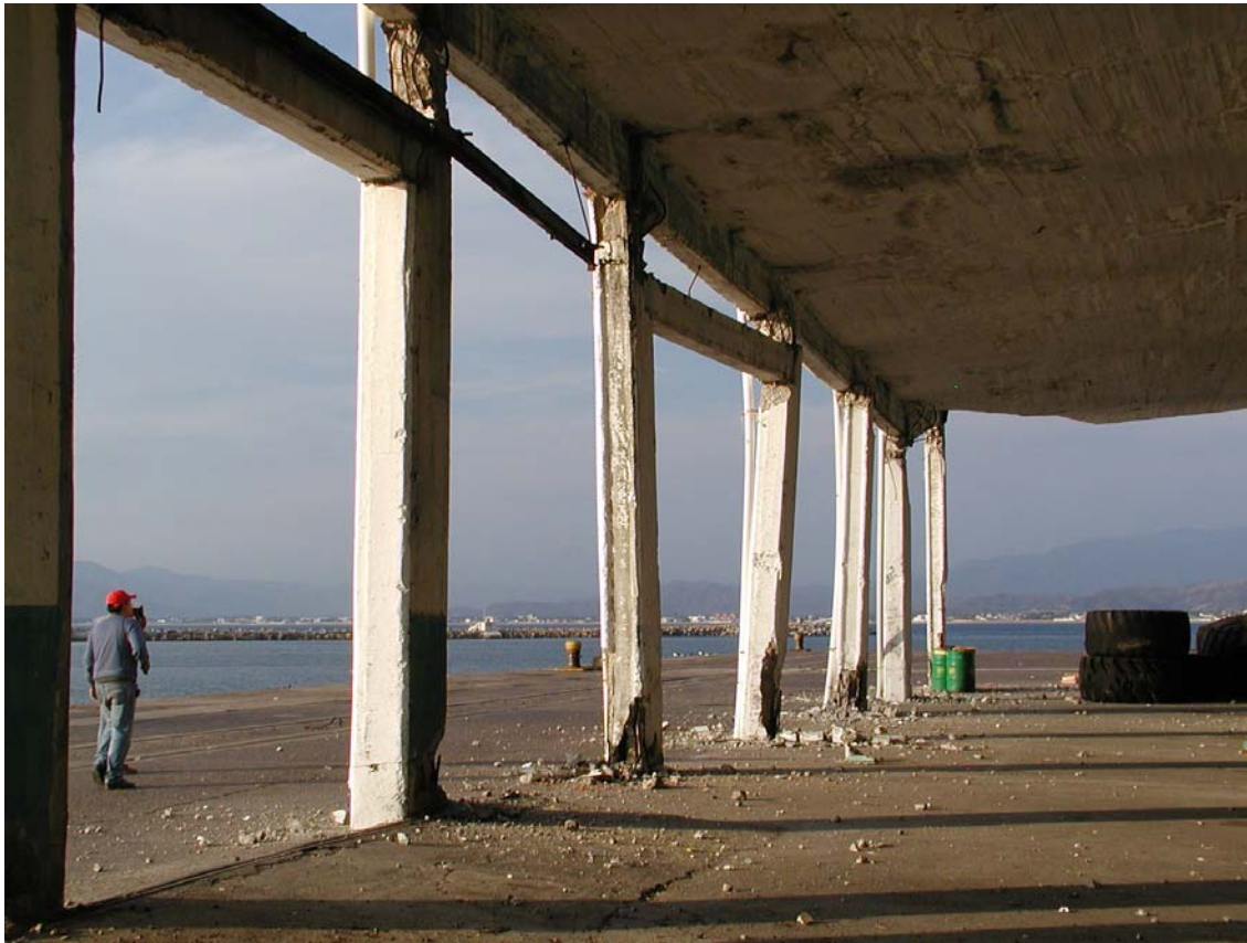
Figura 5.2 Daños ocurridos en las instalaciones del muelle fiscal de Manzanillo
