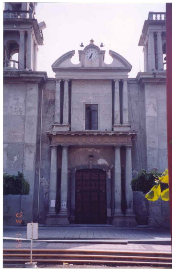
Figura 10.15 Grietas en cuerpo de torre y muros
