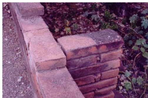
Figura 7.95 Construcción de muros sin liga con muros transversales
