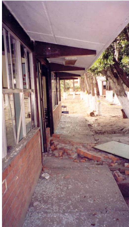
Figura 8.14 Rotura de vidrios y daño en muros de relleno en una escuela secundaria en el poblado de El Chante, municipio de Autlán de Navarro
