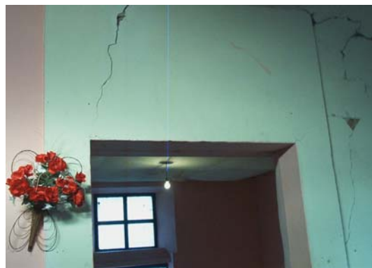
Figura 7.88 Agrietamiento en aberturas de muros de mampostería simple
