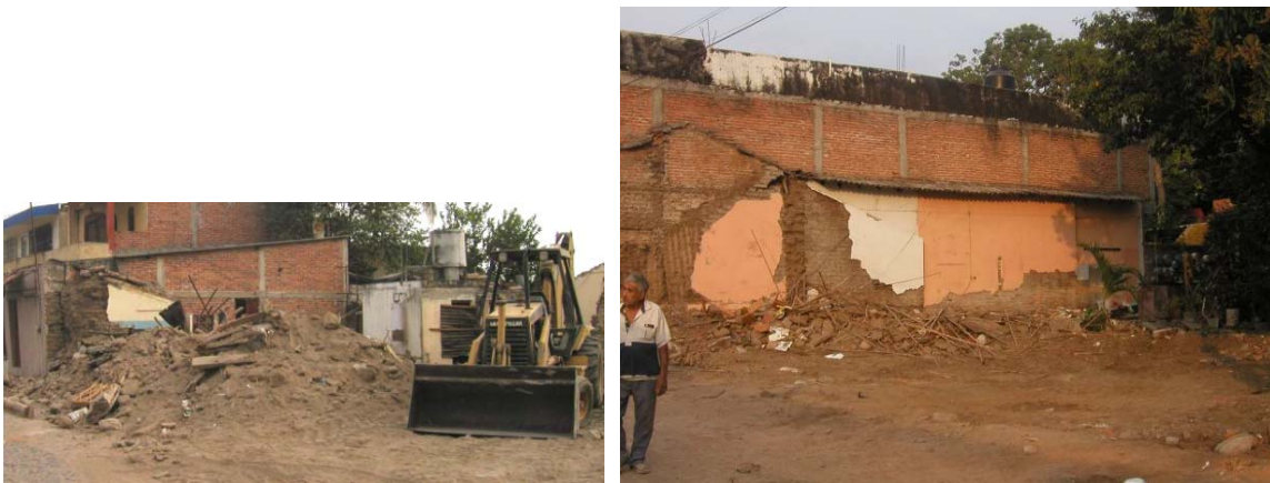
Figura 7.56 Retiro de escombros de viviendas dejando predios vacíos, Villa de Álvarez, Col.
