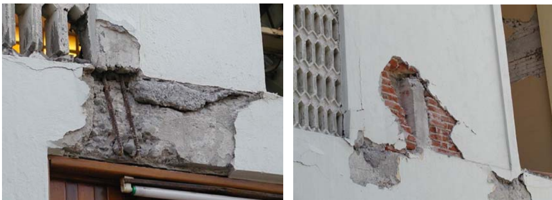
Figura 10.4 Articulaciones plásticas en las vigas y daño en las conexiones deficientes de los muros de mampostería
