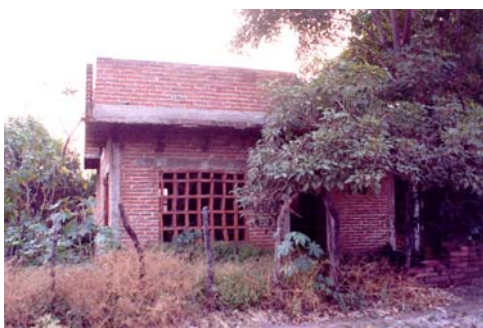
Figura 7.94 Aberturas en muros de mampostería sin confinamiento de elementos de concreto reforzado (castillos y dalas)
