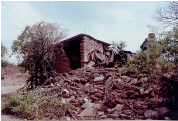
Figura 7.107 Colapso total y parcial de viviendas de adobe y teja de barro
