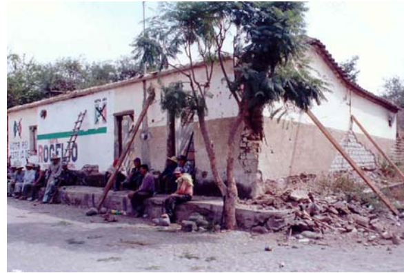
Figura 7.106 Agrietamiento vertical en la intersección muros e inclinación de estos respecto a su eje vertical
