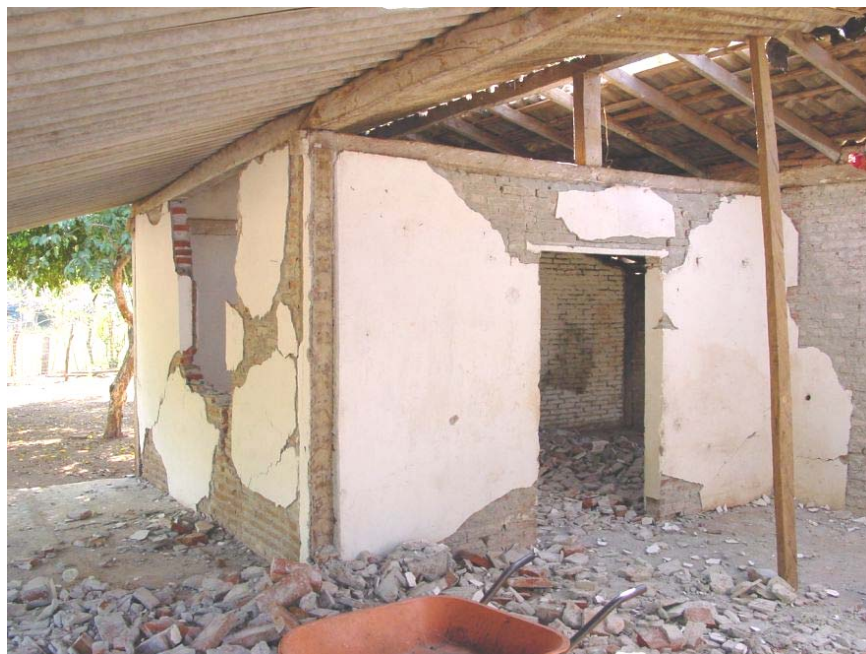
Figura 7.117 Daños en viviendas de mampostería simple
