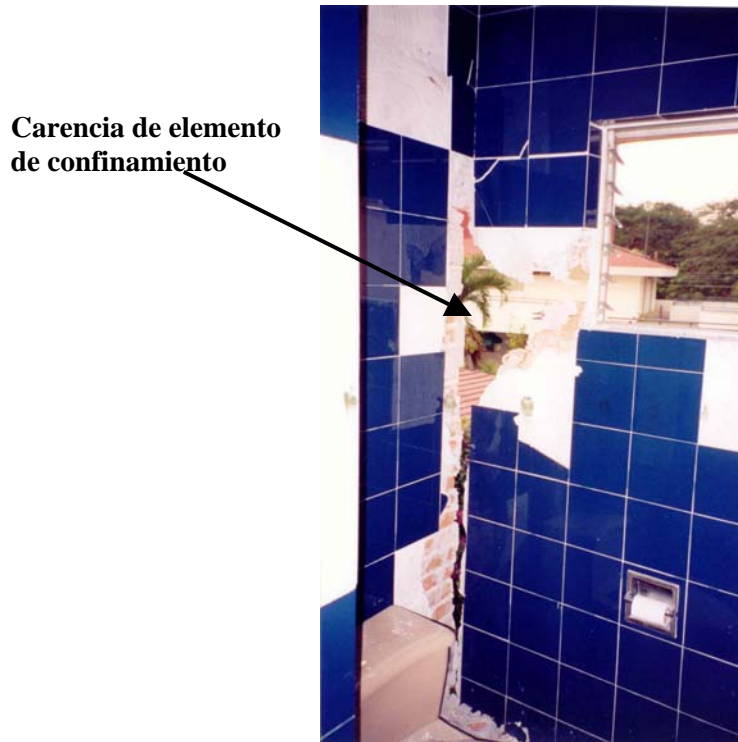
Figura 7.30 Vista interior del daño observado en un muro de fachada en el primer nivel
