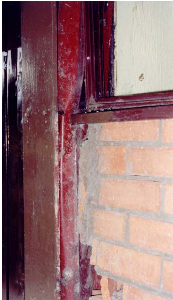
Figura 8.16 Deficiente separación de los muros de relleno en una escuela secundaria en el poblado de El Chante, municipio de Autlán de Navarro
