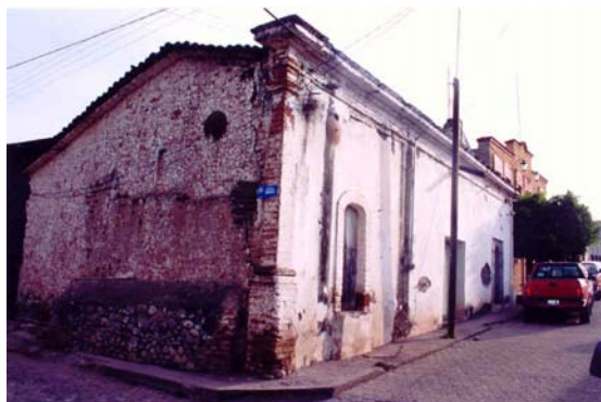
Figura 7.86 Agrietamiento en construcciones relativamente antiguas con muros de abobe, tabique de barro y piedra sin refuerzo
