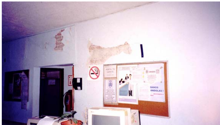
Figura 11.5 Ejemplo del daño en muros divisorios
