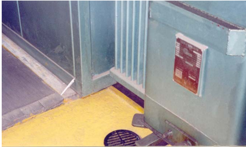
Figura 9.13 Movimiento horizontal de la subestación eléctrica provocado por el sismo
