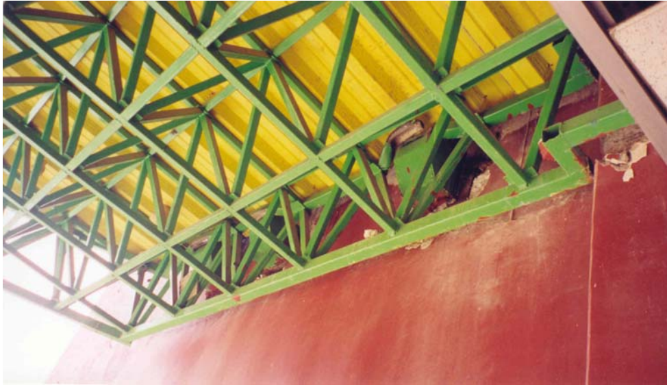
Figura 8.9 Daño en la armadura tridimensional del acceso a la Biblioteca de Ciencias de la Universidad Autónoma de Colima
