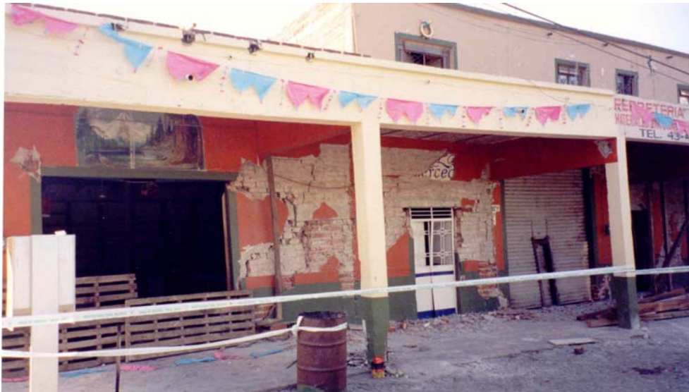
Figura 12.11 Daños en muros de carga en construcciones de uso comercial en Zapotitlán de Vadillo
