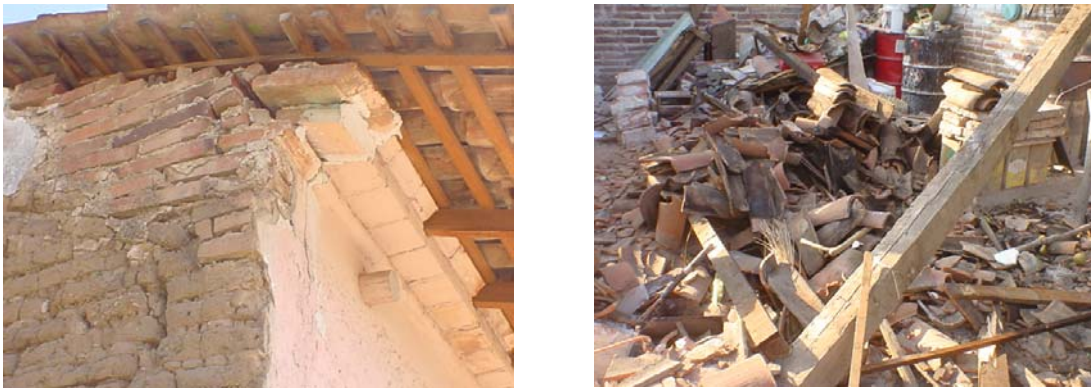
Figura 7.66 Corrimiento de los rollizos de madera que soportaban el sistema de techo y colapso total de la techumbre
