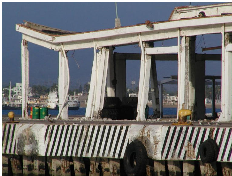
Figura 6.1 Estructura sobre el muelle fiscal
