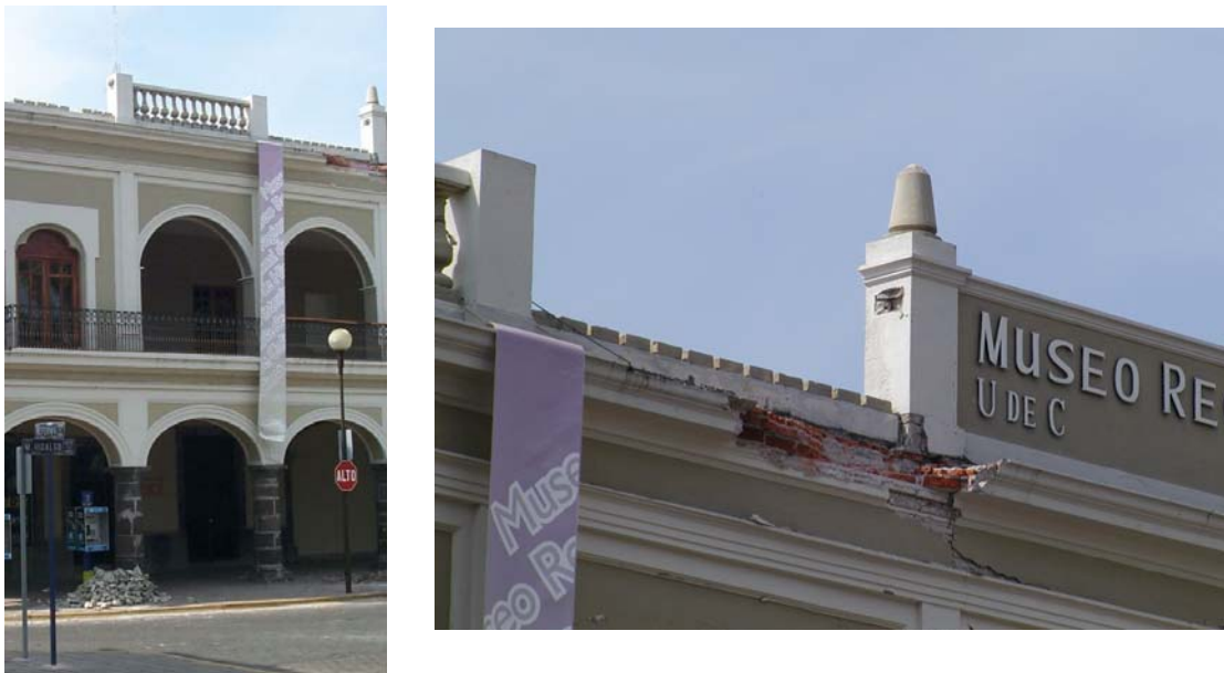
Figura 7.135 Caída de la balastrada del Museo Regional de Historio de Colima
