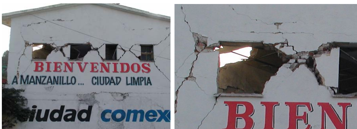
Figura 11.17 Daño en muros de mampostería sin confinamiento en Manzanillo, Col.
