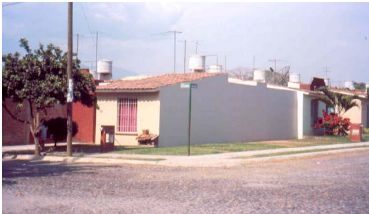
Figura 7.40 Fraccionamiento habitacional con detalle ingenieril
