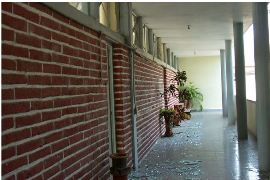
Figura 8.18 Rotura de vidrios en un edificio escolar
