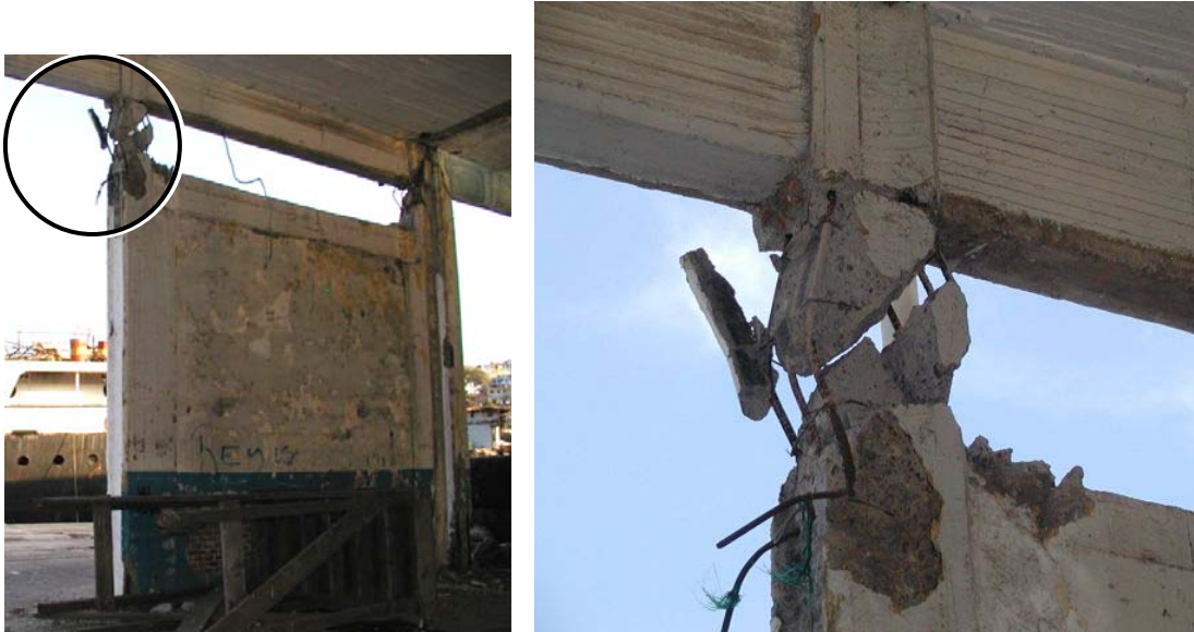
Figura 6.2 Marco con muro generando la falla de columna corta y detalle
