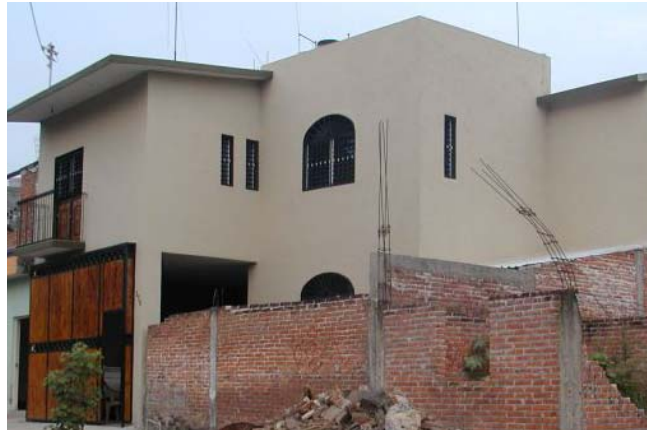
Figura 7.63 Junto a una construcción con daño, una vivienda intacta
