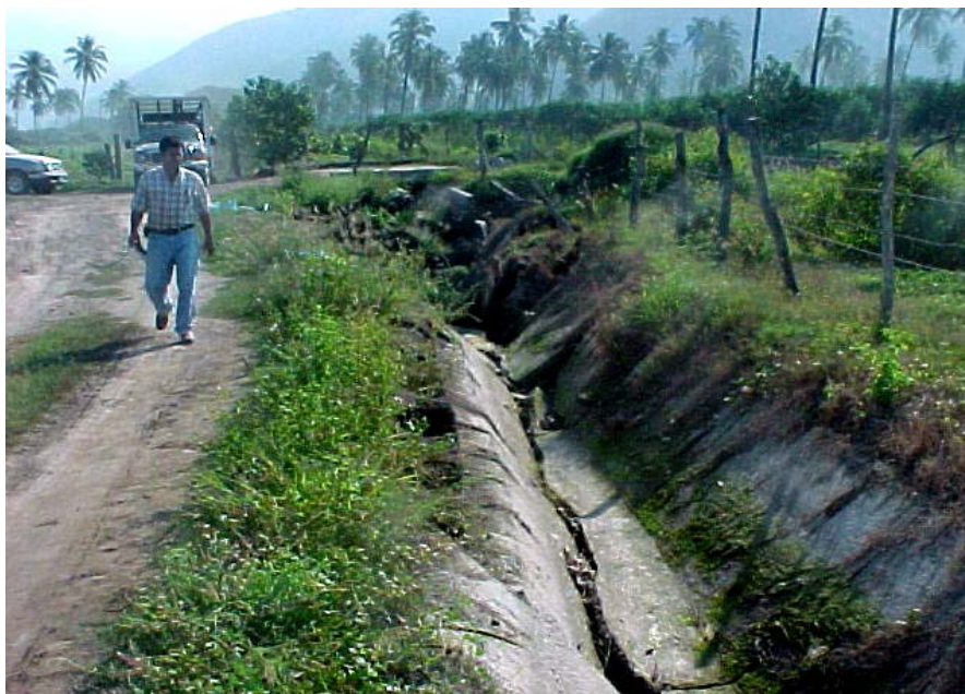
Figura 13.6 Daños en el módulo Tecuanillo en el distrito de riego núm. 58
