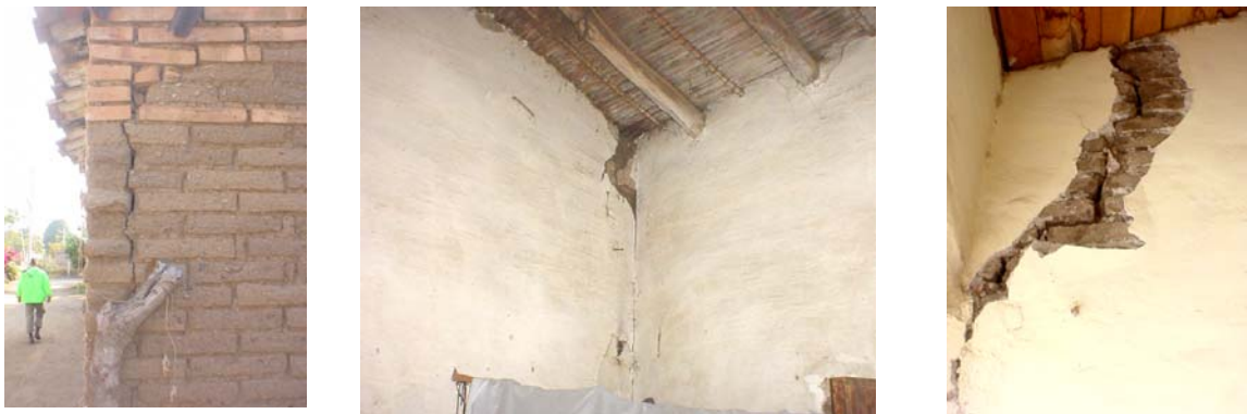
Figura 7.67 Agrietamiento vertical en esquinas de muros de mampostería por ausencia de elementos que los ligan a muros transversales
