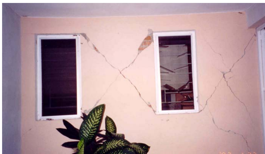
Figura 7.16 Daño típico en muros de mampostería confinada
