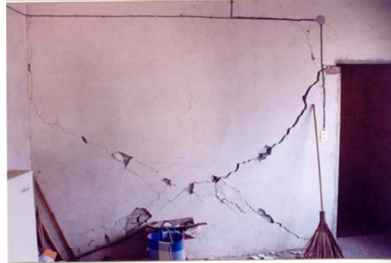
Figura 7.83 Agrietamiento diagonal de muros de mampostería no reforzada ni confinada
