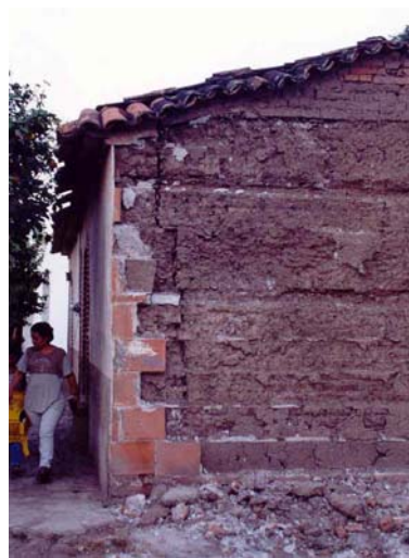
Figura 7.73 Agrietamiento de vertical en muros de esquina
