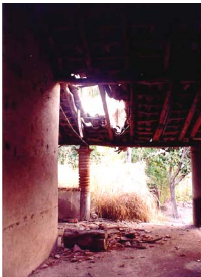
Figura 7.100 Pérdida de apoyo de las vigas de madera que soportan el sistema de techo a base de teja
