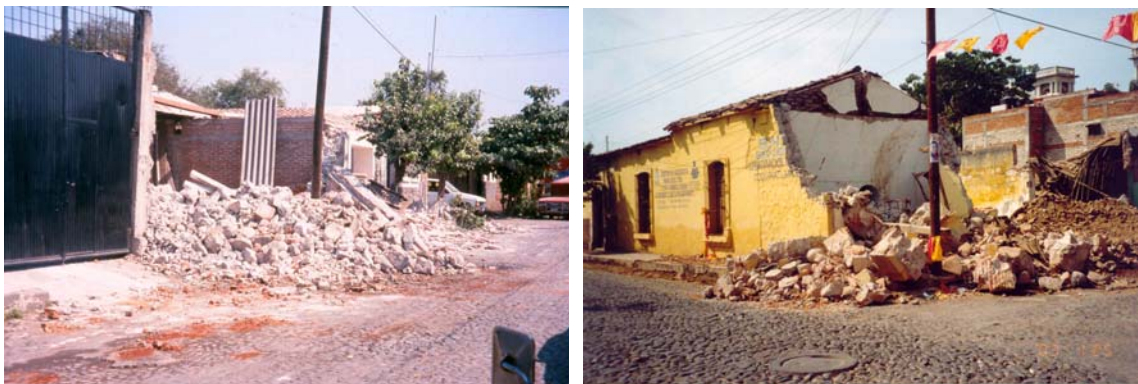
Figura 7.41 Construcciones con materiales combinados y falla de los muros
