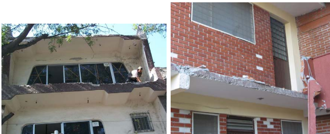
Figura 7.133 Pretilos como barandal en balcones y pasillos. En la foto de la derecha el pretil tenía cadena horizontal, pero el castillo estaba mal anclado en su base
