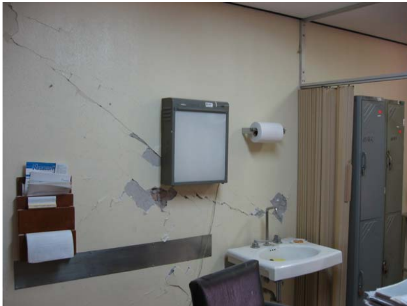
Figura 9.10 Ejemplo del daño en muros divisorios del edificio de Consulta Externa
