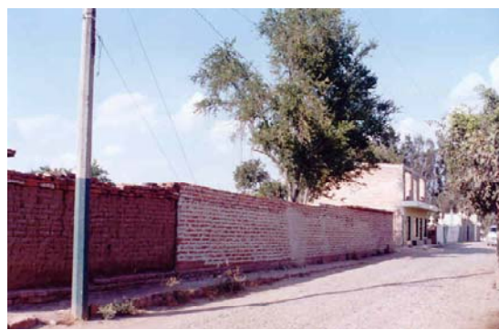
Figura 7.92 Bardas de gran longitud sin elementos de refuerzo (castillos y dalas)
