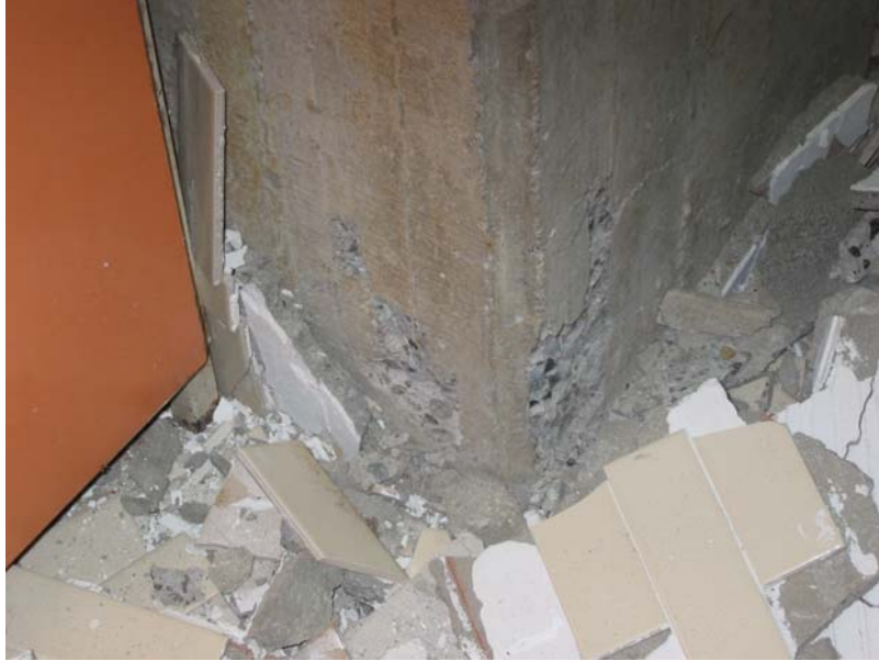
Figura 9.9 Daño ligero por aplastamiento del concreto en algunas de las columnas del área de hospitalización
