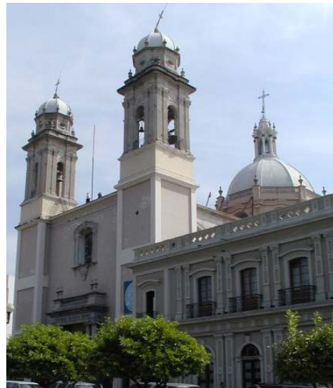
Figura 10.7 Daño en la base de la cruz y vista de la Catedral
