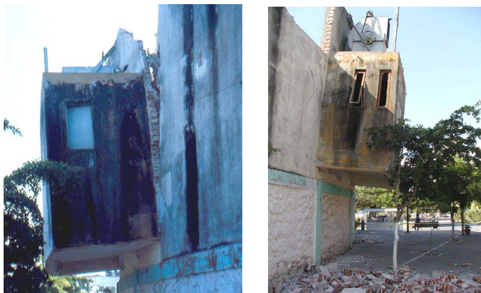
Figura 12.5 Daño e inclinación de la cabina de proyección
