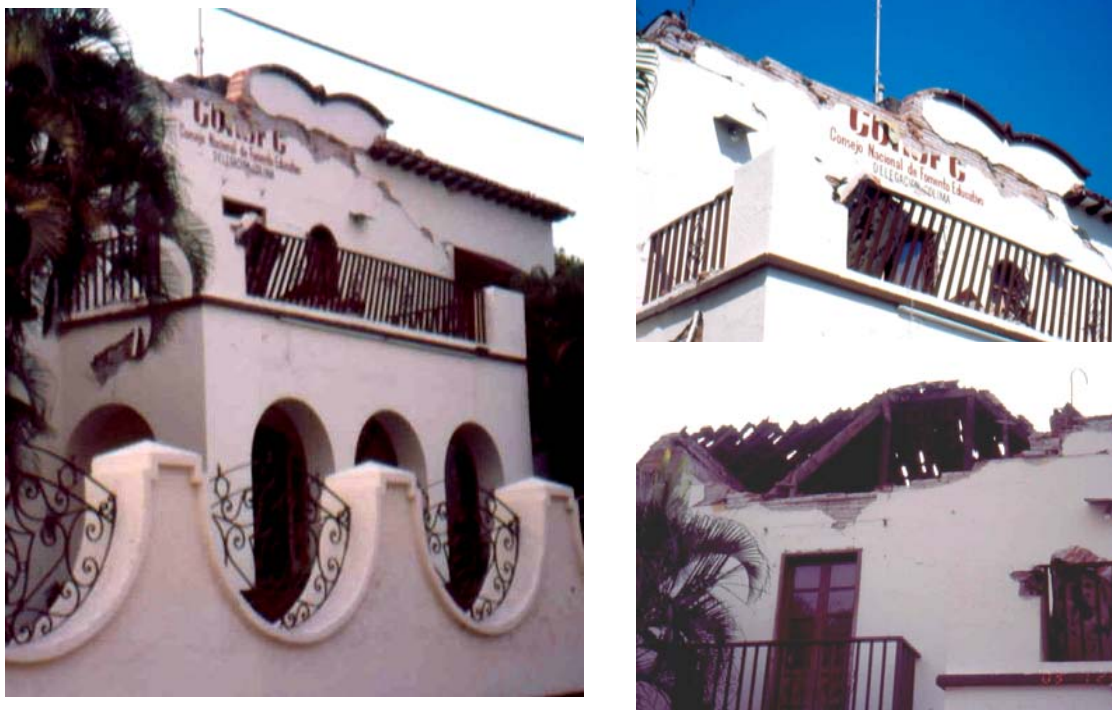
Figura 8.5 Daños en el edificio del CONAFE
