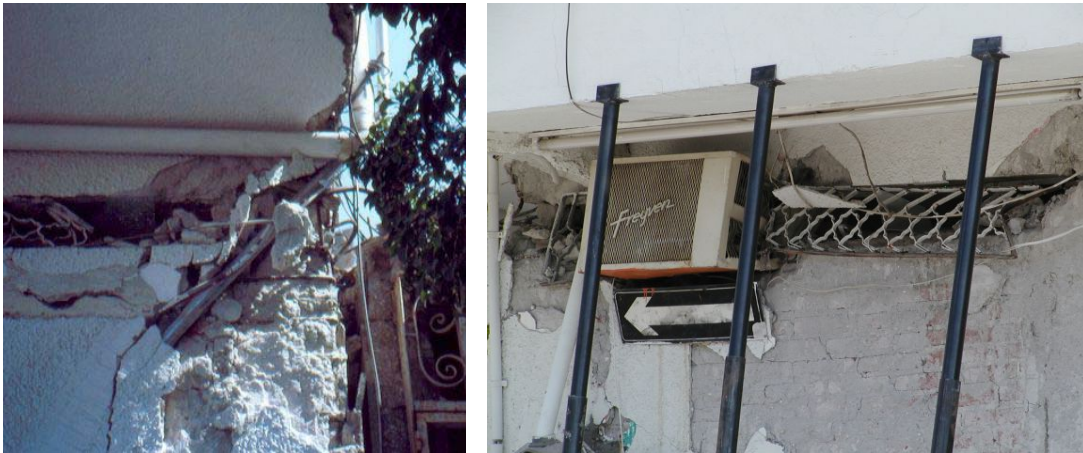
Figura 12.7 Destrucción de las columnas cortas, nótese por la rejilla el descenso de la estructura en más de 25 cm en la abertura para ventilación
