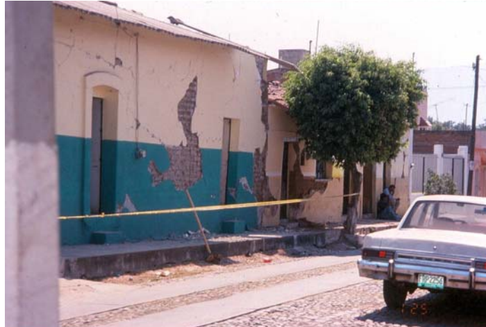
Figura 7.37 Desprendimiento del acabado en fachadas
