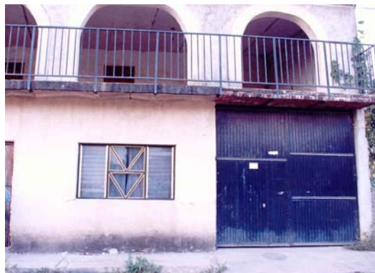
Figura 7.72 Tendencia a construir sobre muros de carga de adobe o mampostería simple (no confinada ni reforzada)
