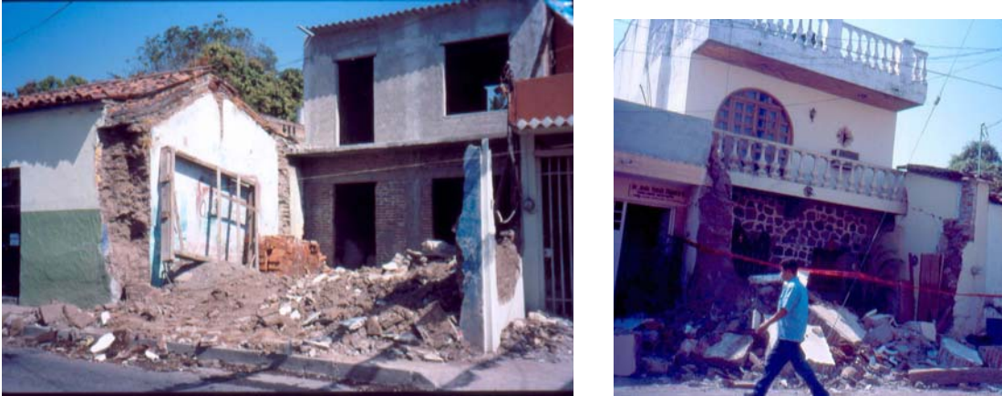
Figura 7.13 Ejemplo de la nueva construcción mediante mampostería confinada en el interior del predio en contraste con el colapso de otra casa o barda de adobe al frente
