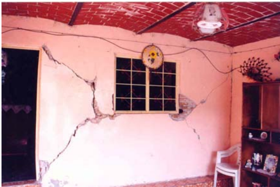
Figura 7.84 Agrietamiento severo de muros de mampostería simple
