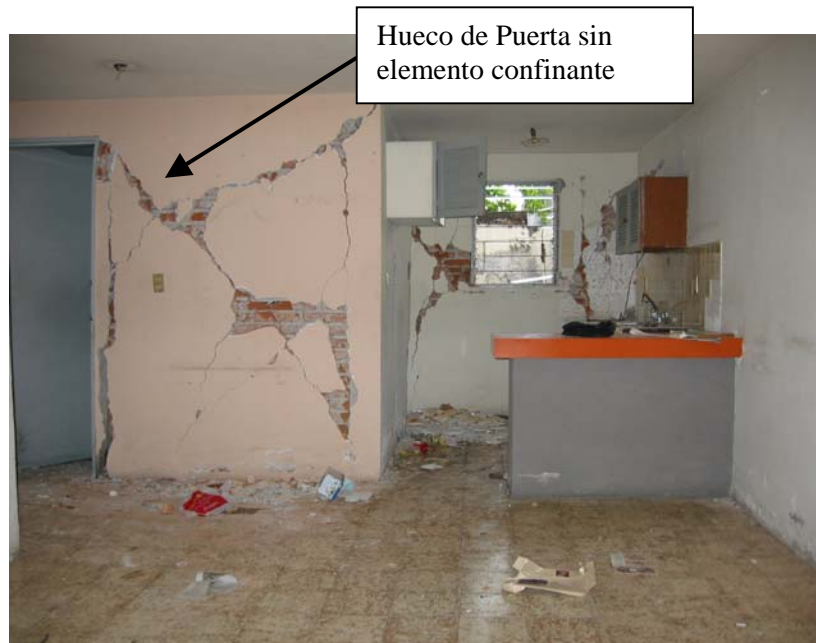
Figura 7.22 Falta de confinamiento en un muro interior de planta baja
