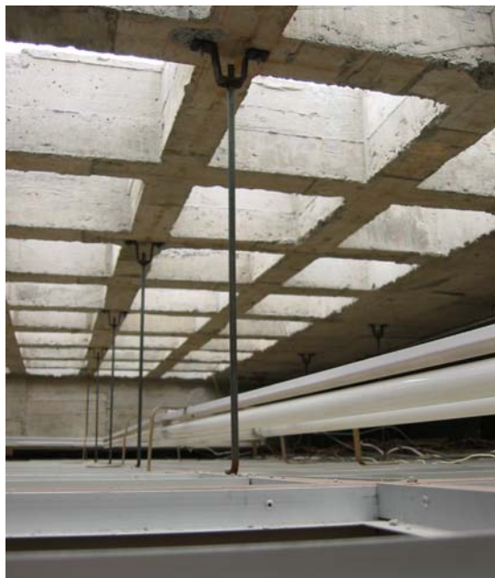
Figura 9.6 Daño en plafones debido a un deficiente sistema de sujeción
