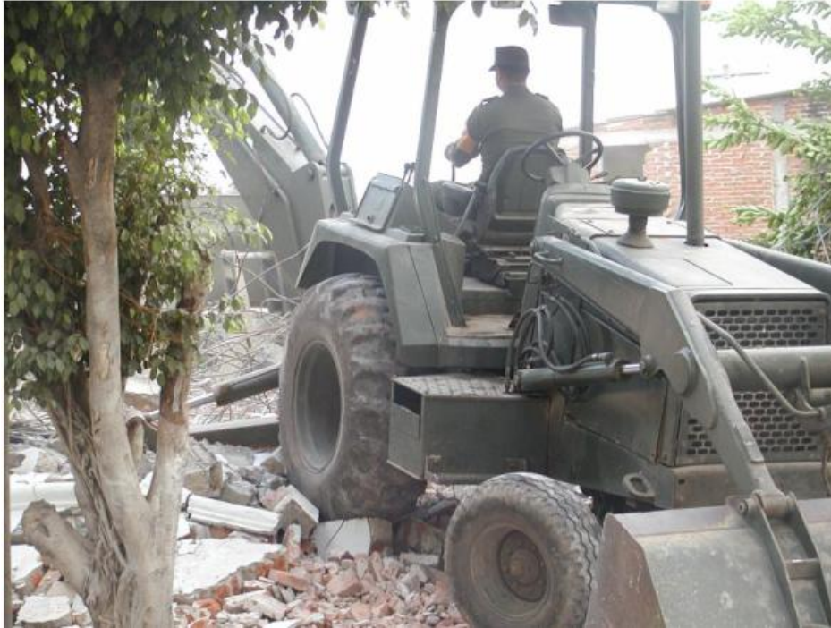
Figura 13.4 Personal militar en operaciones de demolición
