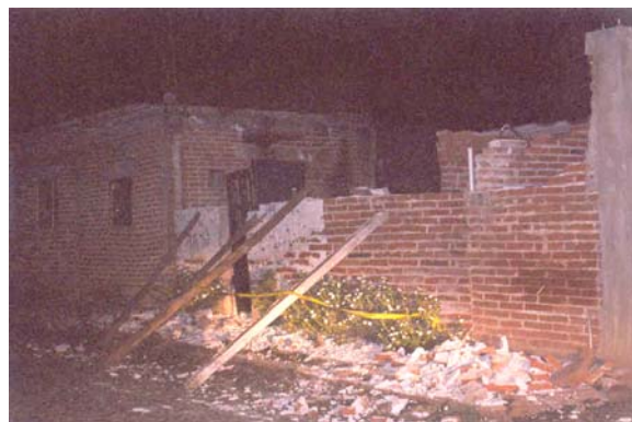
Figura 7.99 Caída de bardas de mampostería simple
