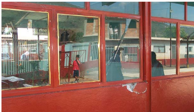
Figura 8.22 Daño en vidrios y muros divisorios en una escuela del poblado de Cotija, Michoacán (foto: Dirección Estatal de Protección Civil del estado de Michoacán)
