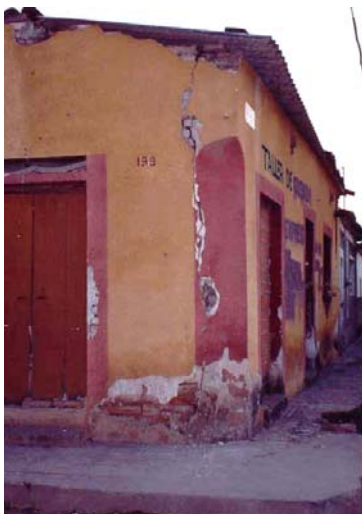
Figura 7.73 Agrietamiento de vertical en muros de esquina
