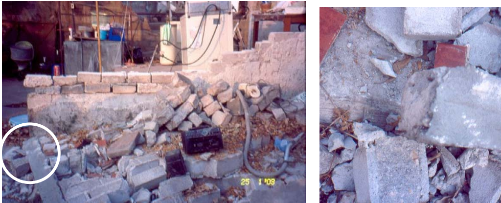
Figura 7.129 a) Caída de barda de tabicón de concreto pobre. b) Detalle de la fractura del refuerzo longitudinal en la base del castillo caído
