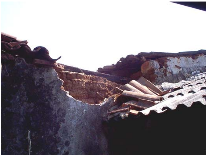
Figura 7.78 Colapso de sistema de techo por pérdida de apoyo
