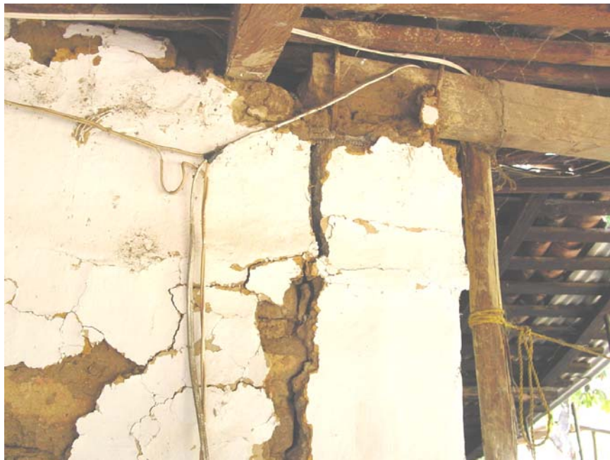
Figura 7.115 Daño en un muro de adobe a causa de una mala liga del castillo y la dala de cerramiento
