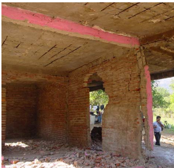
Figura 7.119 Daño severo en viviendas construidas con materiales de mala calidad y el cero de refuerzo expuesto
