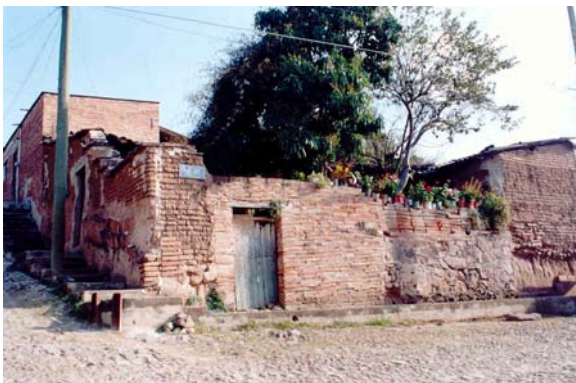
Figura 7.71 Muros de adobe, piezas de arcilla recocida, piedras o una combinación de estas
