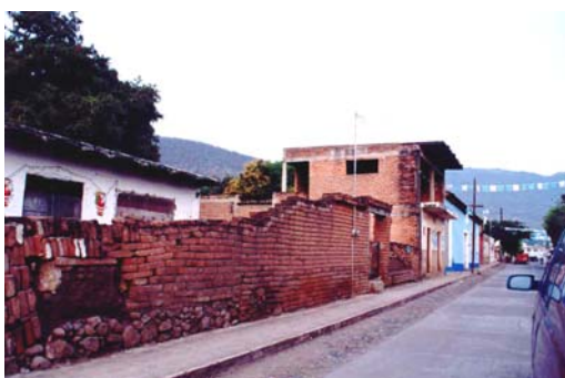
Figura 7.96 Bardas de gran longitud de mampostería sin refuerzo
