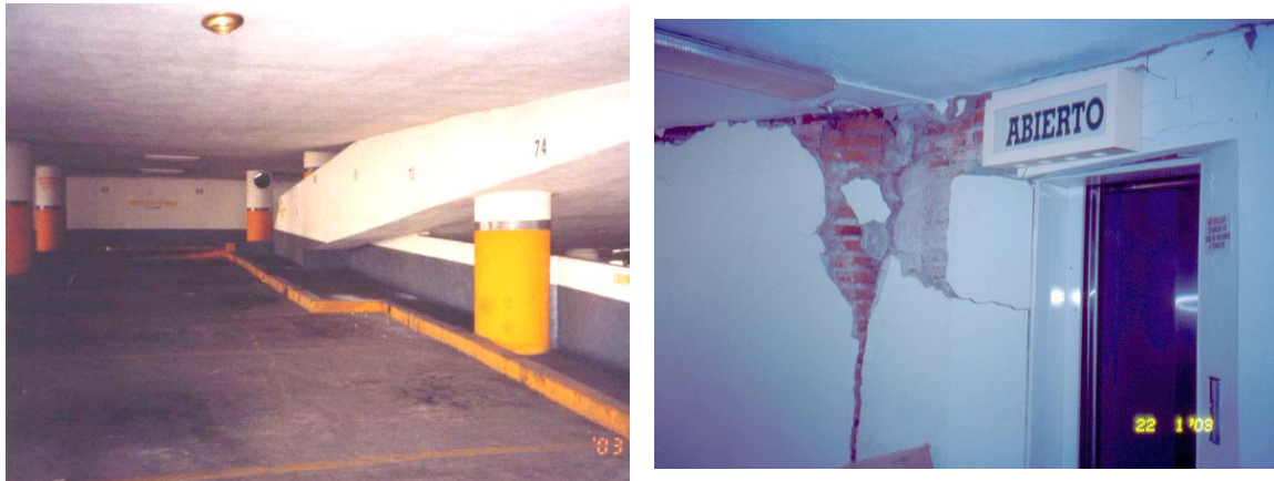
Figura 12.2 Vista interna del edificio y daño en el muro junto al elevador Sur
