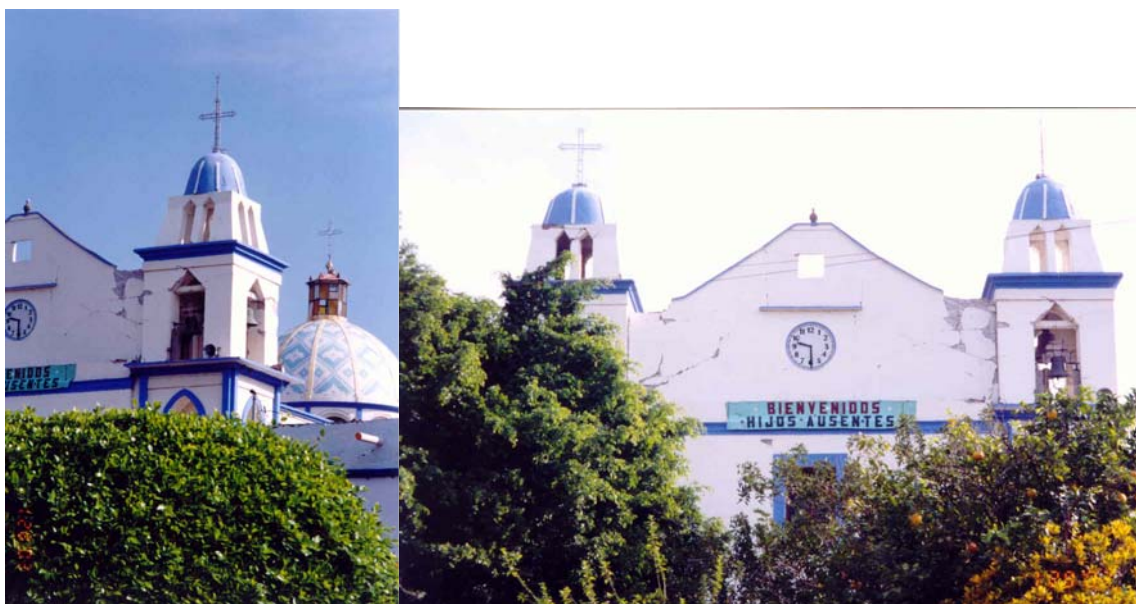
Figura 10.27 Daños severos, agrietamiento entre los cuerpos de torres de campanarios y portón, y en los extremos de las columnas del campanario
