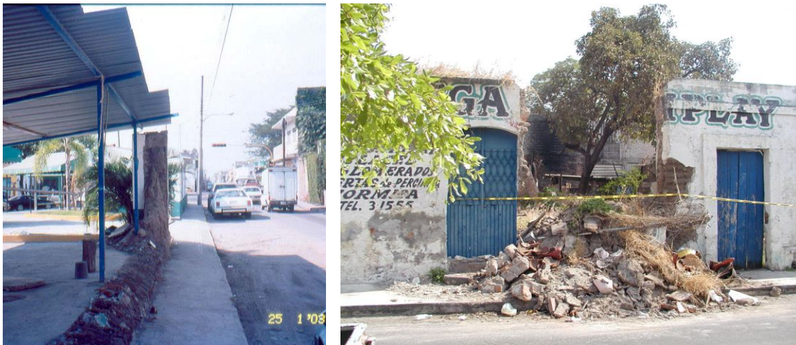
Figura 7.122 Colapso de bardas de adobe
