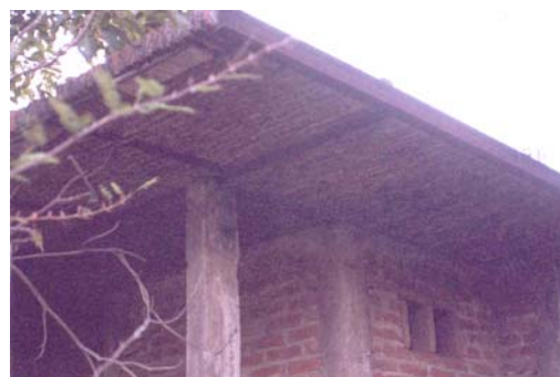
Figura 7.97 Sistema de techo resuelto con bóveda catalana
