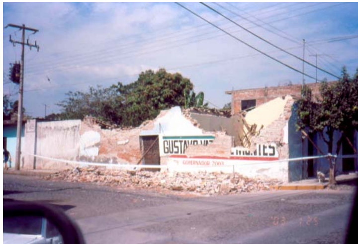
Figura 7.38 Daño en construcción de mampostería sin confinar
