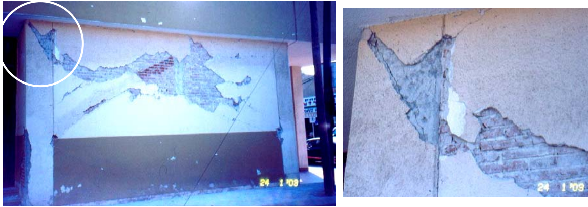
Figura 11.21 Daño en muro diafragma y penetración de la grieta inclinada en el extremo superior de una columna
