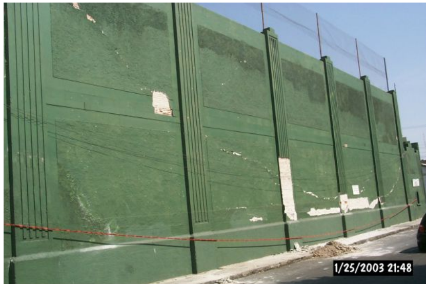
Figura 7.125 Agrietamiento en el muro de un frontón
