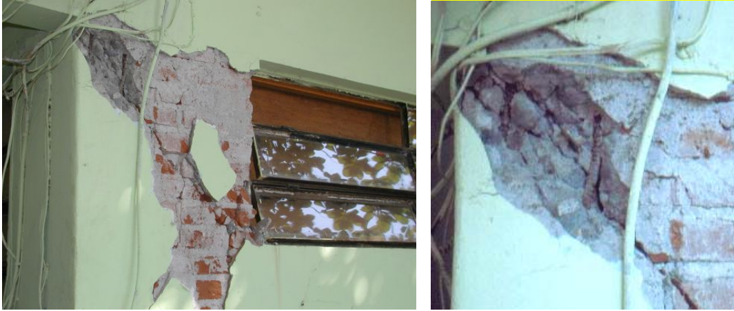
Figura 11.14 Agrietamiento en un segmento de muro con penetración en el castillo
