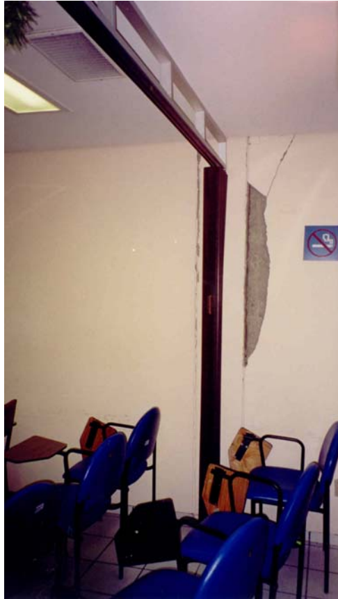
Figura 9.15 Daño en muros divisorios del edificio de investigación y capacitación
