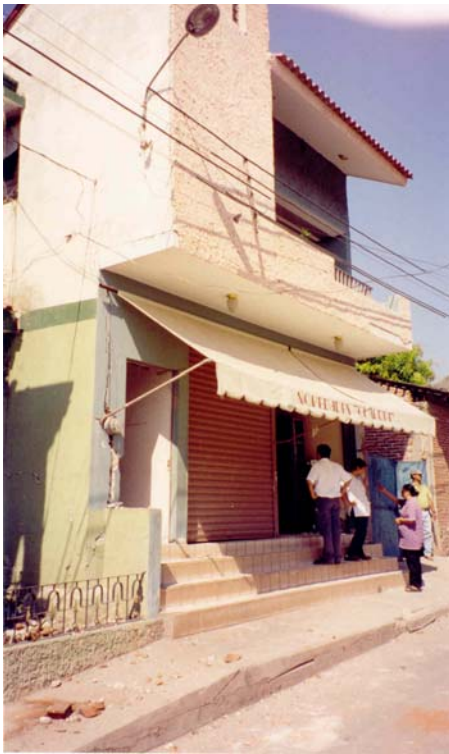
Figura 7.50 Vista exterior de la vivienda 10
