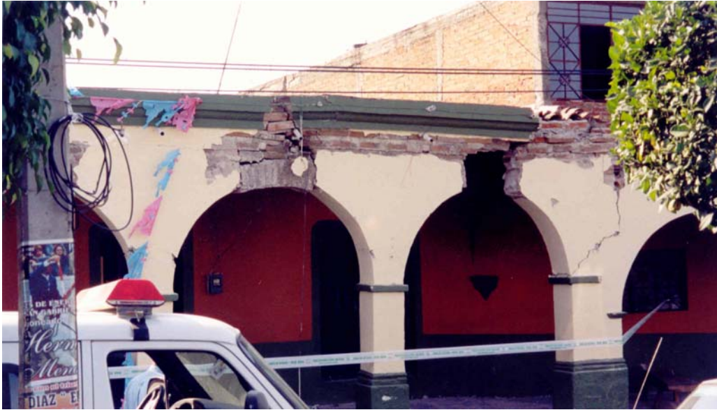
Figura 12.12 Daño en el sistema de arcos de construcciones de uso comercial en Zapotitlán de Vadillo
