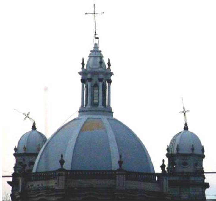
Figura 13.10 Daños a las cruces de la Catedral, Colima
