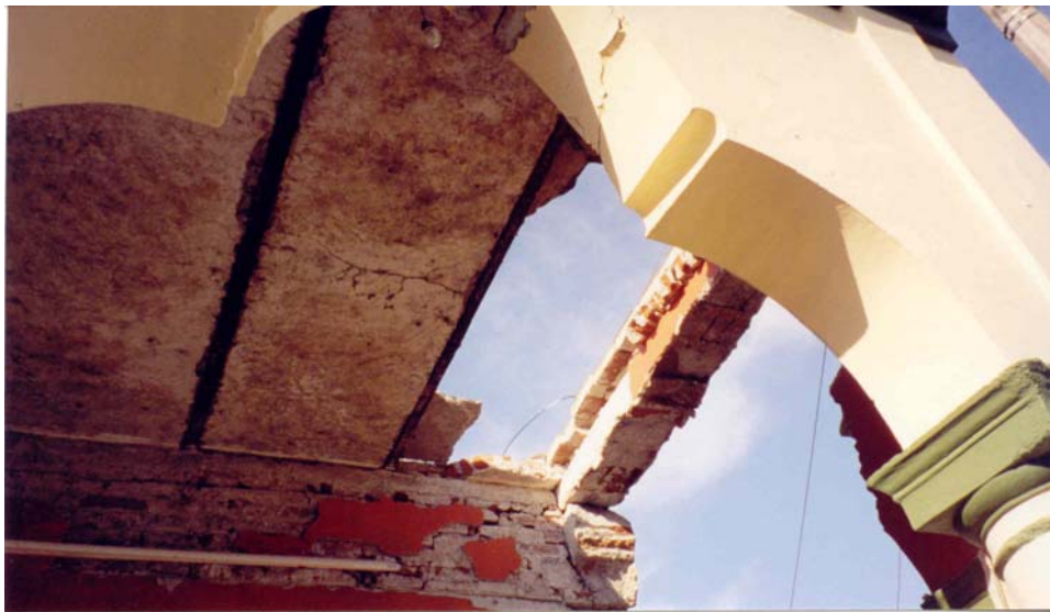
Figura 11.26 Caída de parte del techo de bóveda catalana de la Presidencia Municipal de Zapotitlán de Vadillo
