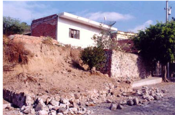
Figura 7.85 Caída de muros de contención (de piedra) sin refuerzo para resistir empuje del suelo
