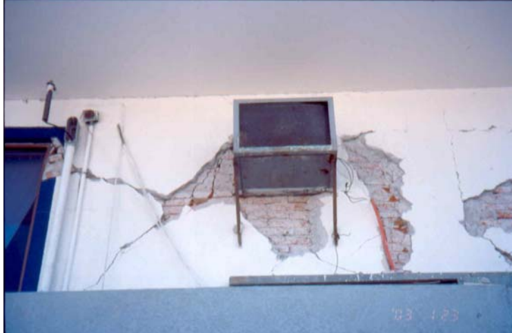
Figura 7.17 Daño en muros de mampostería
