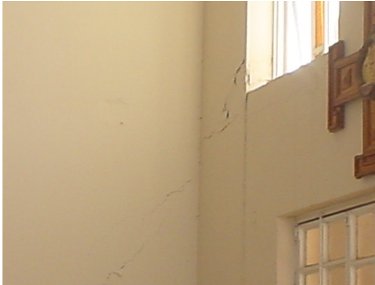
Figura 10.22 Agrietamiento ligero en muros en iglesias del estado de Jalisco, ubicadas en la vecindad del municipio de Guadalajara
