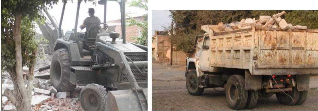
Figura 7.55 Demolición de vivienda severamente dañada o colapsada y retiro de escombros
