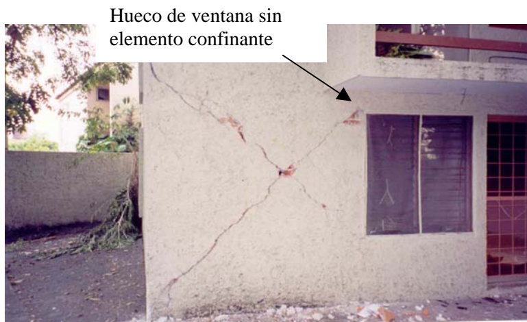
Figura 7.23 Falta de confinamiento en un muro un muro de fachada
