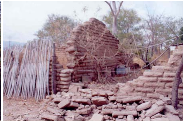
Figura 7.107 Colapso total y parcial de viviendas de adobe y teja de barro
