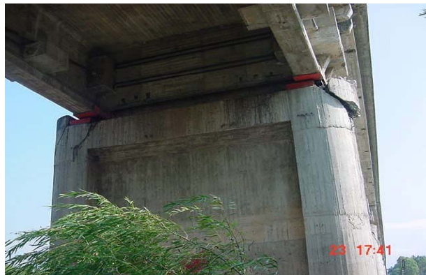
Figura 13.8 En la parte superior de la pila se observa a ambos lados que los topes de los sismos fallaron en los desplazamientos laterales de la losa del puente
