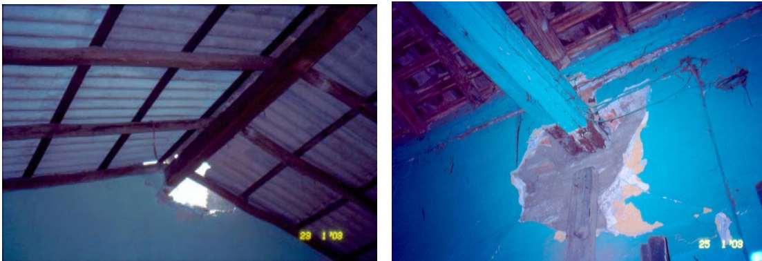
Figura 7.14 Daño local en el apoyo de las vigas del sistema de techo
