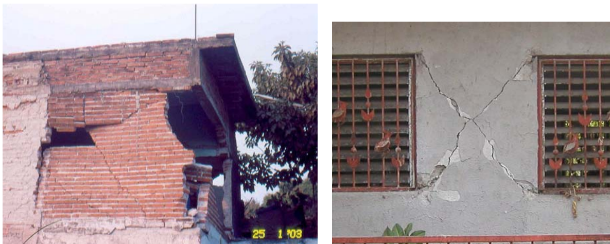
Figura 7.59 a) Daño en muro de mampostería simple; b) Agrietamiento en "X" en un segmento de muro entre ventanas, Villa de Álvarez, Col.
