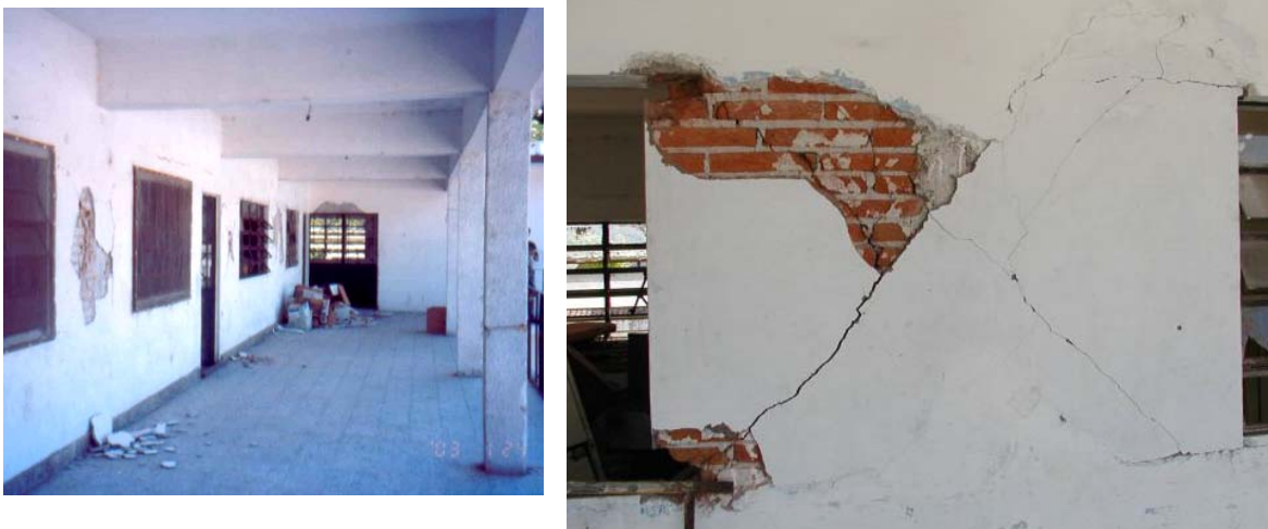
Figura 11.15 Agrietamiento en X en segmentos de muro en la planta alta
