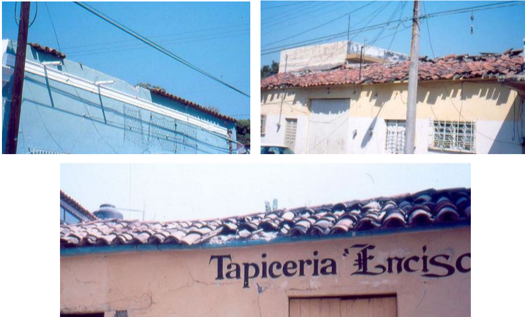
Figura 7.137 Caída de tejas sobre la vía pública
