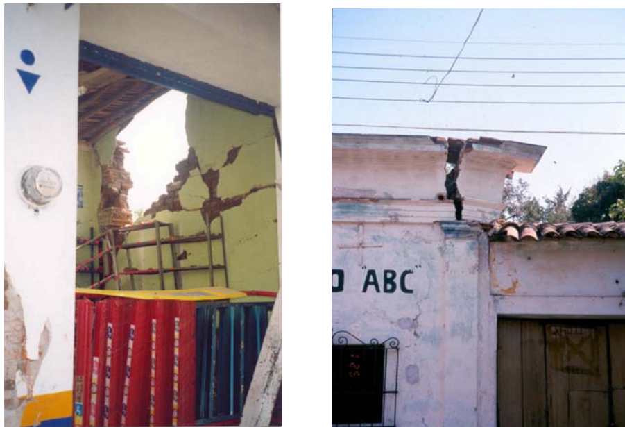
Figura 7.36 Ejemplo de la caída parcial de muros y pretilas
