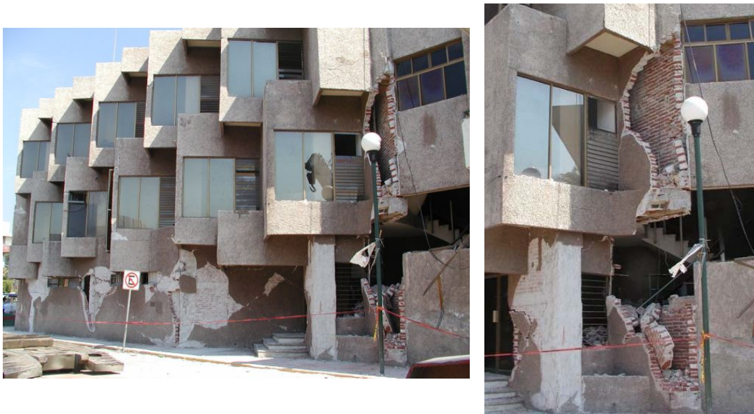
Figura 12.8 Fachada principal y detalle del daño
