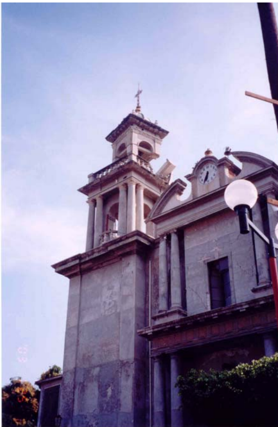
Figura 10.14 Vista del daño en el campanario norte
