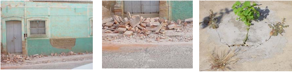
Figura 7.65 Caída de teja en la periferia del sistema de techo, agrietamiento de muros y pérdida de recubrimiento en construcciones relativamente antiguas sin mantenimiento
