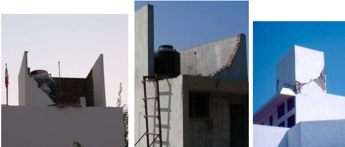
Figura 7.134 Casos típicos de caída de pretilos y bardas que rodeaban a los tinacos, hechas con mampostería no reforzada
