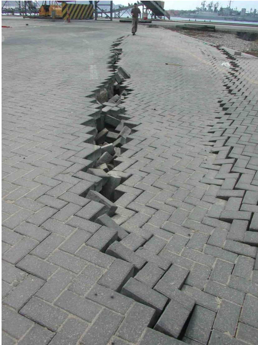
Figura 5.3 Daños por el fenómeno de licuación en las instalaciones del puerto de Manzanillo, Wartman et al., 2003; http://geoinfo.usc.edu/gees
