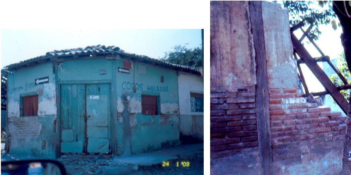
Figura 7.44 Daño en vivienda y bardas reforzadas con madera
