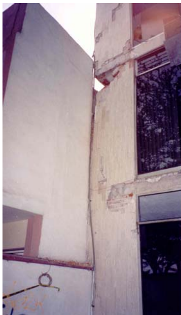
Figura 11.13 Choque del edificio de las oficinas administrativas del ISSSTE con la construcción vecina
