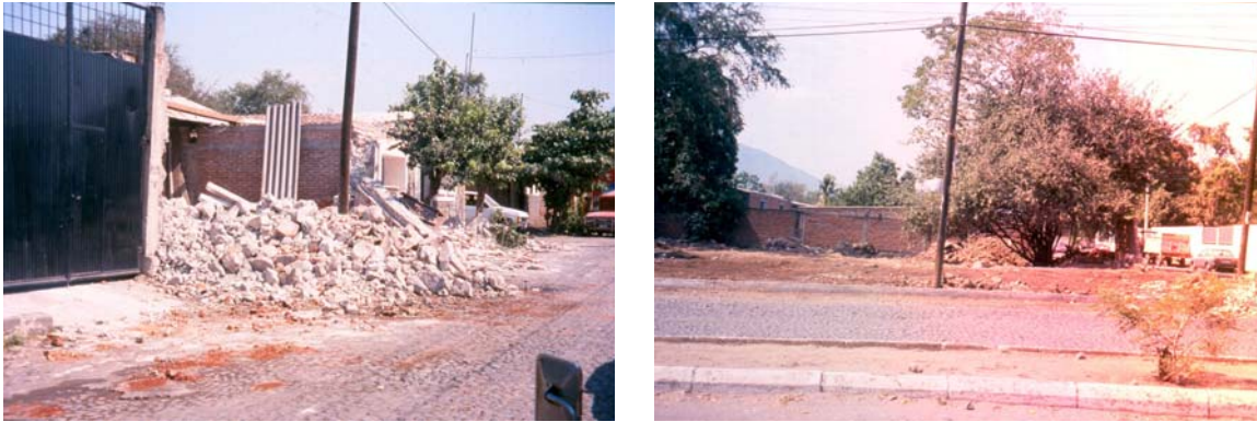
Figura 7.35 Escombros generados por la demolición de las viviendas
