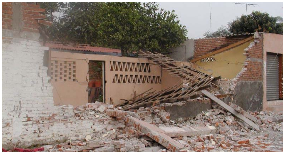
Figura 7.126 Colapso de barda de mampostería confinada (con refuerzo inadecuado)
