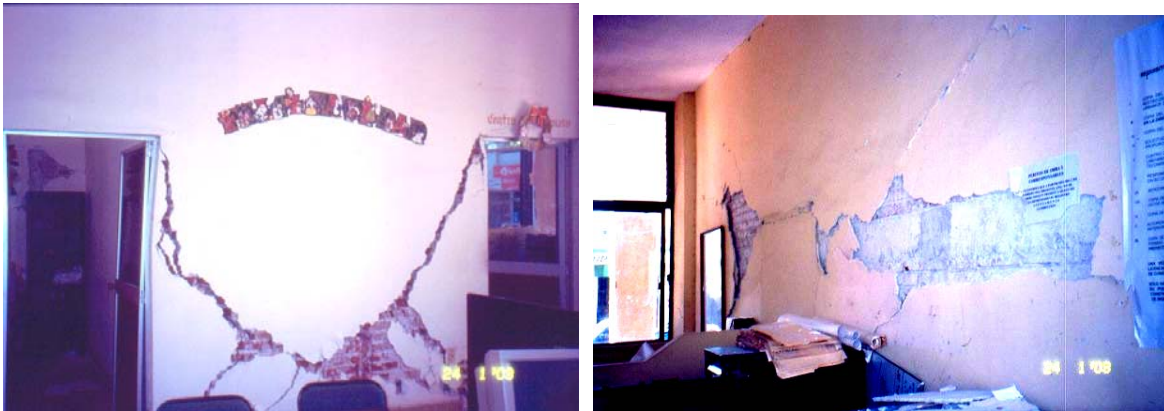
Figura 11.20 Daño en muros divisorios de mampostería
