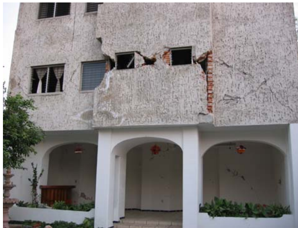
Figura 7.27 Fachada posterior del edificio
