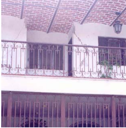
Figura 7.82 Agrietamiento en muros de segundo nivel construidos con mampostería simple de arcilla recocida
