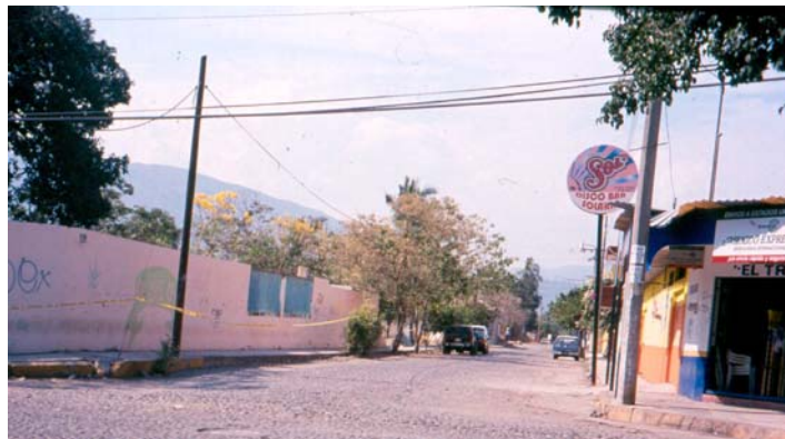
Figura 11.16 Caída de las bardas perimetrales del plantel educativo
