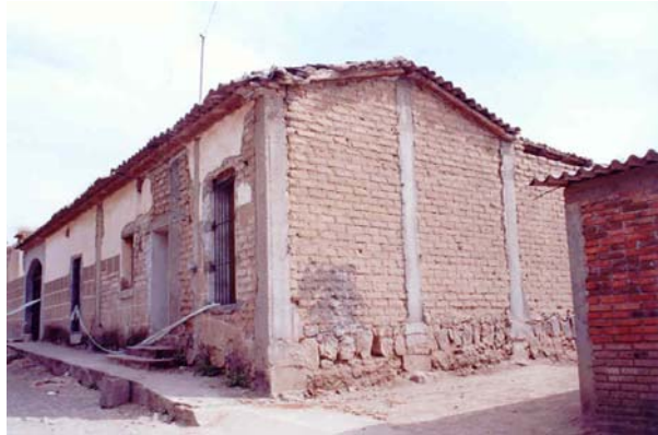
Figura 7.108 Vivienda de muros de adobe reforzados con elementos de concreto reforzado (castillos) sin daño
