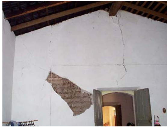
Figura 7.90 Agrietamiento vertical que nace en el apoyo de la viga principal del sistema de techo en muros cabeceros
