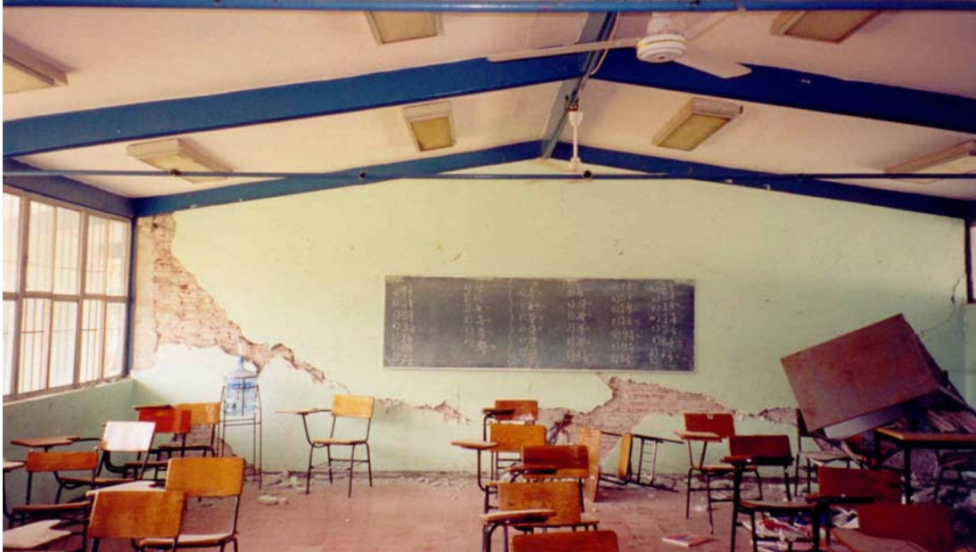
Figura 8.13 Vista interior del daño observado en los muros divisorios de una escuela secundaria de Ixtlahuacán
