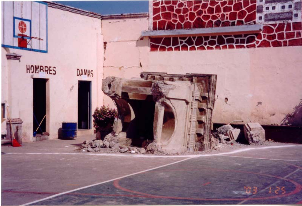
Figura 10.13 Caída del segundo nivel del campanario sur
