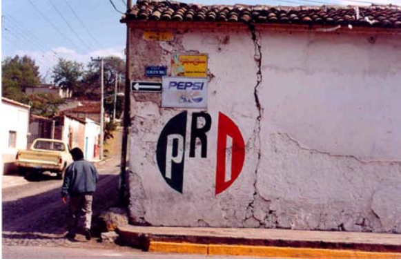
Figura 7.69 Agrietamiento de muros por asentamientos del terreno (asentamiento diferencial)
