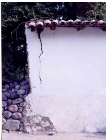
Figura 7.80 Agrietamiento vertical en muros de esquina y su consecuente separación de muros en vivienda con muros de adobe y piedra
