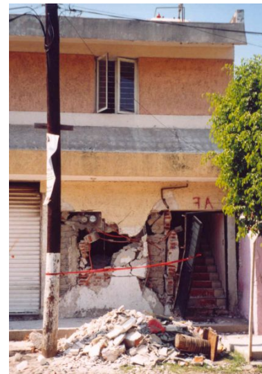
Figura 7.45 Colapso de muro de mampostería y daño en otra edificación, Tecomán, Colima
