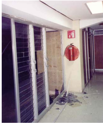
Figura 9.7 Rotura de vidrios en el interior del edificio de hospitalización
