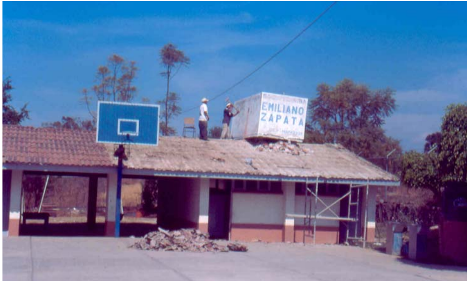
Figura 8.17 Falla de la estructura soporte del tinaco en una escuela primaria en Zapotitlán de Vadillo
