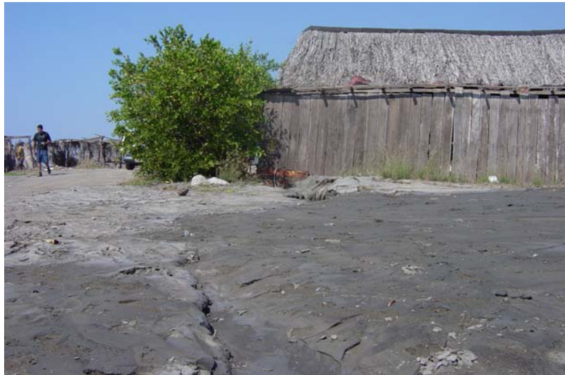
Figura 5.5 Suelo expulsado a la superficie del terreno a través de las grietas formadas por el fenómeno de licuación, Foto cortesía del Ing. Germán Espitia
