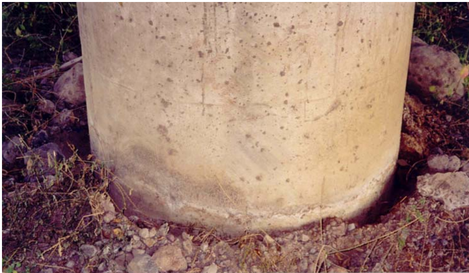
Figura 6.8 Evidencia del movimiento de los apoyos del puente “Manzanillo”
