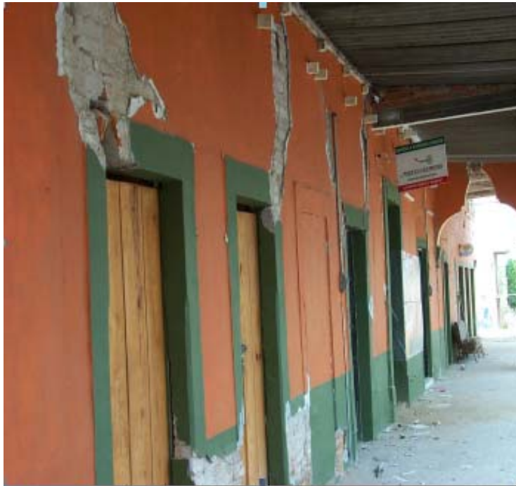
Figura 11.25 Agrietamiento diagonal de los muros de carga de la Presidencia Municipal de Zapotitlán de Vadillo
