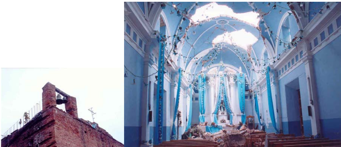
Figura 10.26 Daños severos, colapso de las bóvedas de iglesia en Tetapán, municipio de Zapotoitlán de Vadillo
