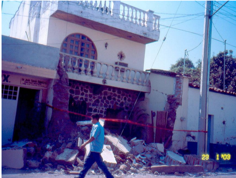
Figura 7.123 Colapso de antigua barda de adobe, nótese la construcción moderna en el interior
