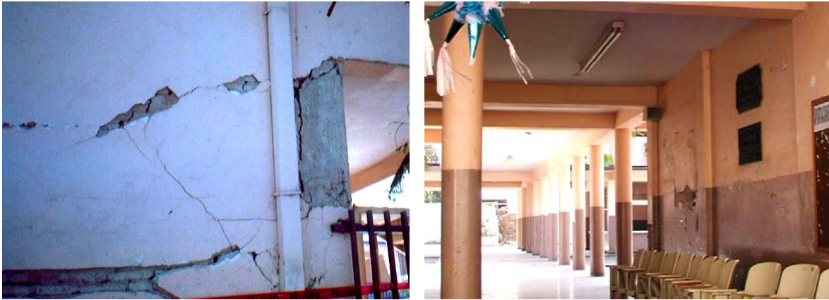
Figura 8.4 Daño en muros diafragma de mampostería
