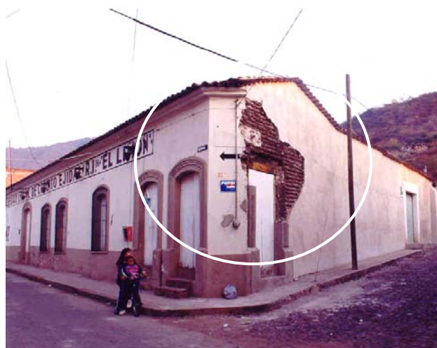
Figura 7.101 Agrietamiento de muros de mampostería simple y caída de recubrimiento
