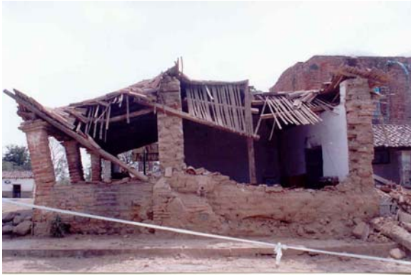
Figura 7.105 Colapso de muros y techos
