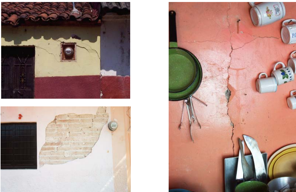
Figura 7.77 Agrietamiento diagonal de muros
