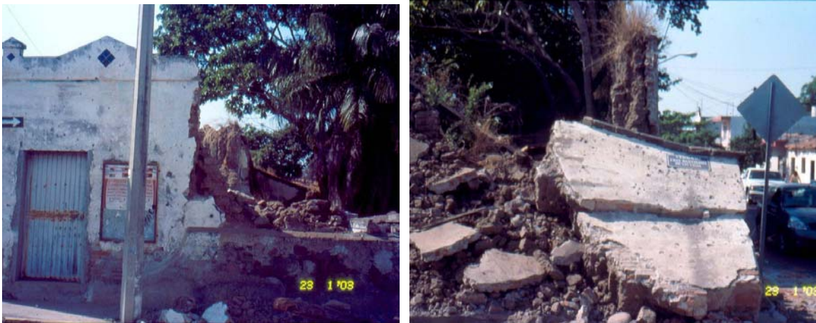
Figura 7.121 Bardas de adobe colapsadas
