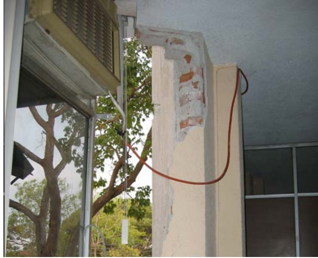
Figura 11.6 Ejemplo del daño en los ventanales de la fachada
