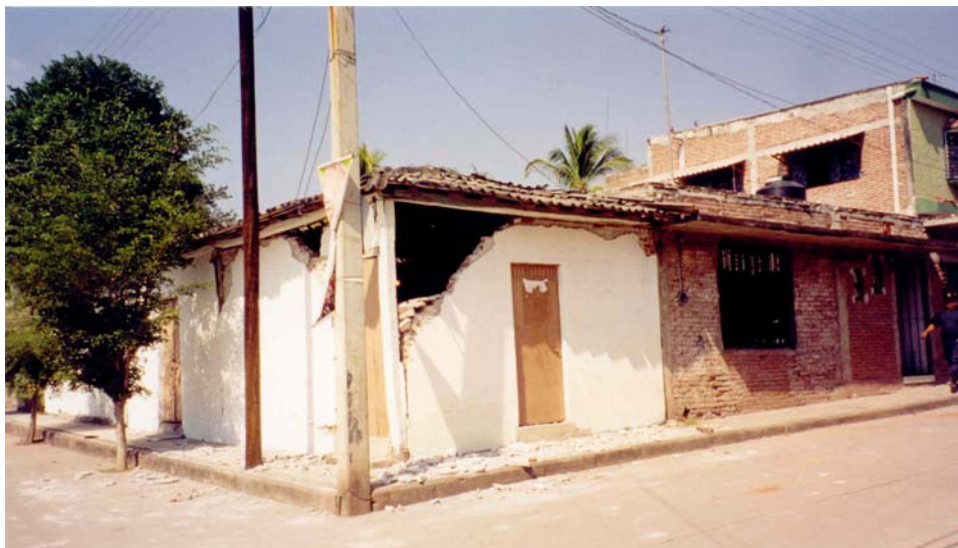
Figura 7.53 Vivienda número 13 con daño tipo III
