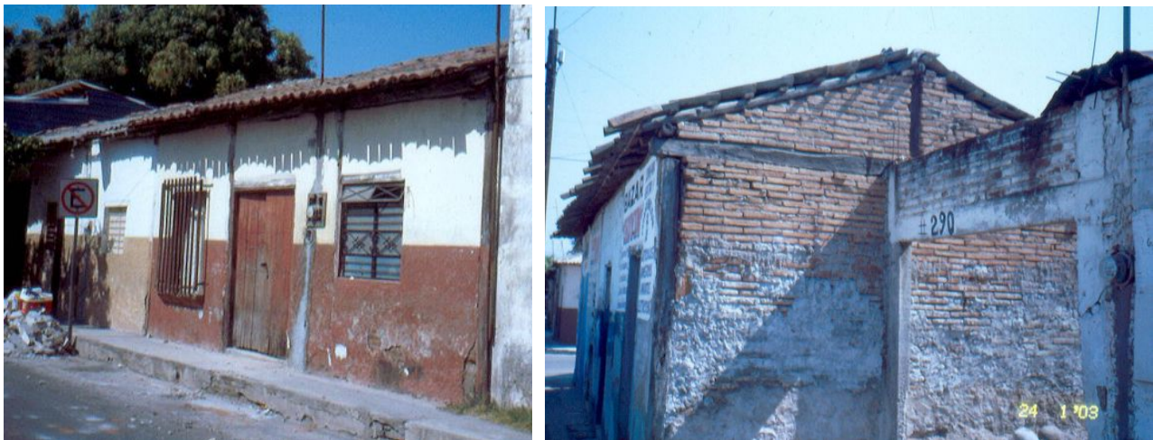
Figura 7.43 Vivienda con postes y vigas de madera y paneles de mampostería de tabique
