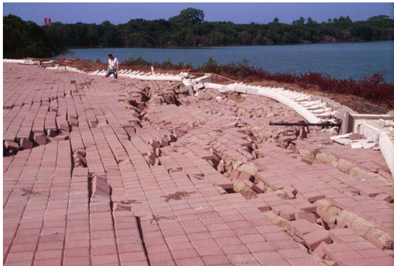
Figura 5.6 Desplazamiento lateral del terreno debido al fenómeno de licuación en Manzanillo, Wartman et al., 2003; http://geoinfo.usc.edu/gees/
