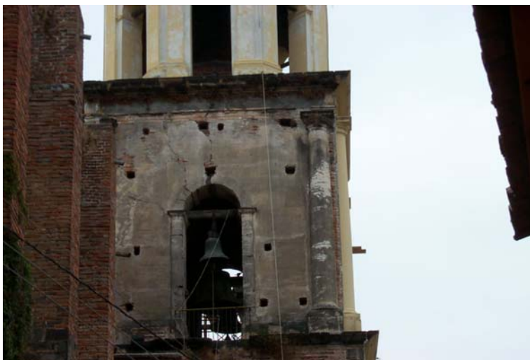
Figura 10.23 Daños medios, agrietamiento en los arcos de las estructuras de campanarios
