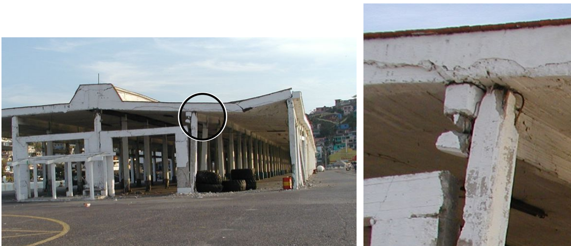
Figura 6.3 Vista desde el extremo del muelle, falla de la conexión viga-columna
