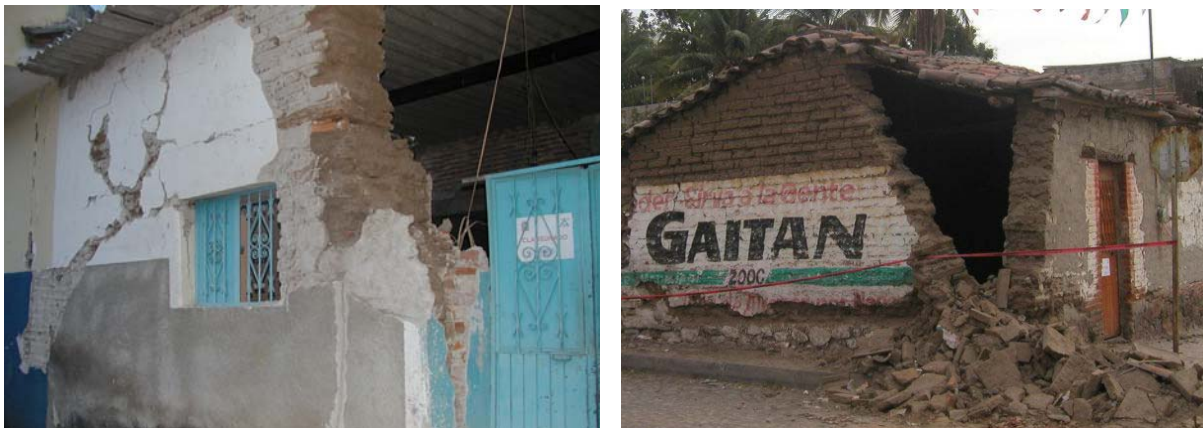
Figura 7.58 a) Daño severo con colapso parcial, b) Colapso de esquina en vivienda de adobe
