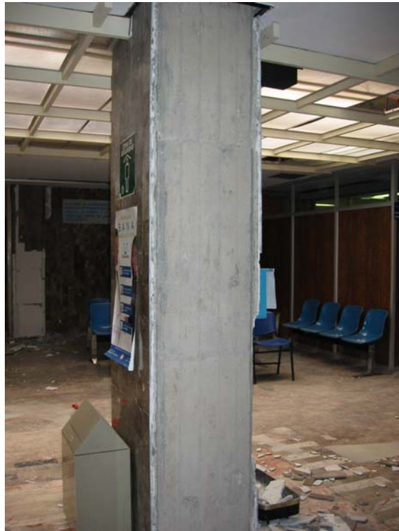
Figura 9.4 Ejemplo de la caída del acabado en columnas
