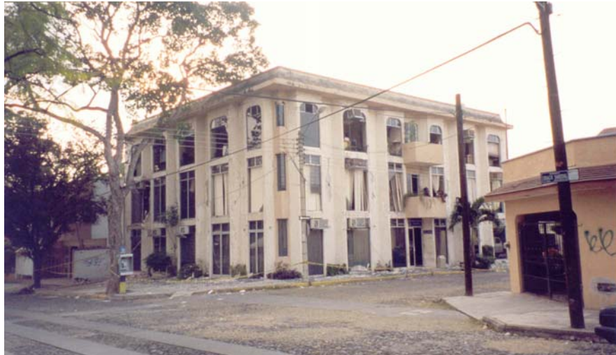
Figura 11.4 Vista exterior del edificio de las oficinas administrativas del ISSSTE
