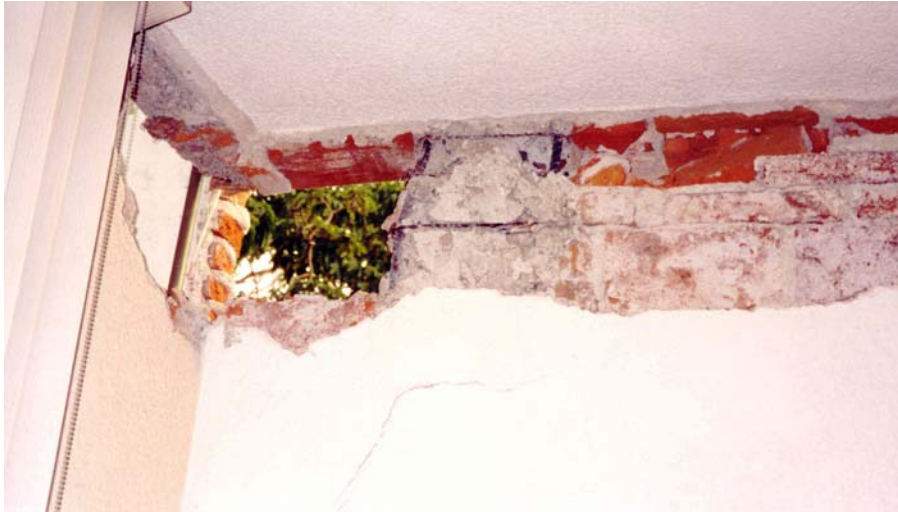
Figura 11.12 Daño en una columna de esquina del edificio de oficinas administrativas del ISSSTE
