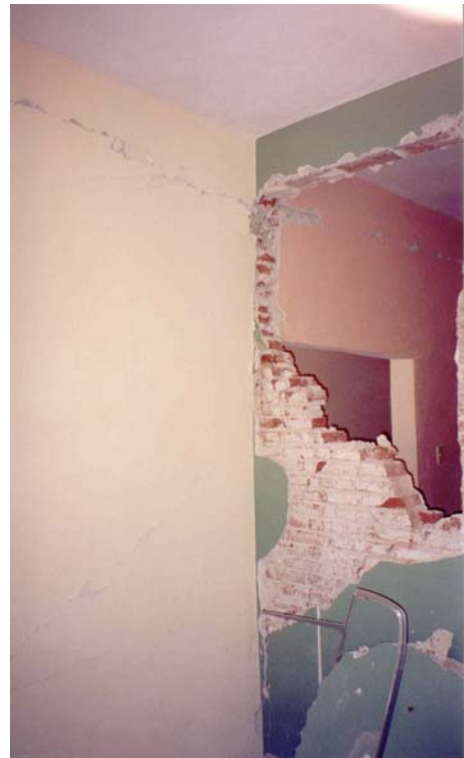
Figura 7.51 Daño en muros interiores de la vivienda 10
