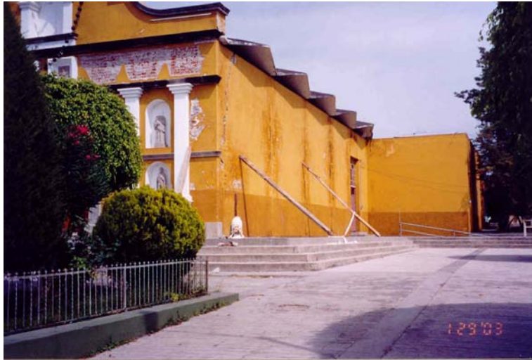
Figura 10.28 Daños severos, falla de muros laterales e inestabilidad fuera del plano
