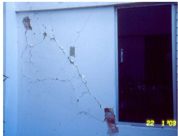
Figura 11.2 Fachada del edificio y muros agrietados
