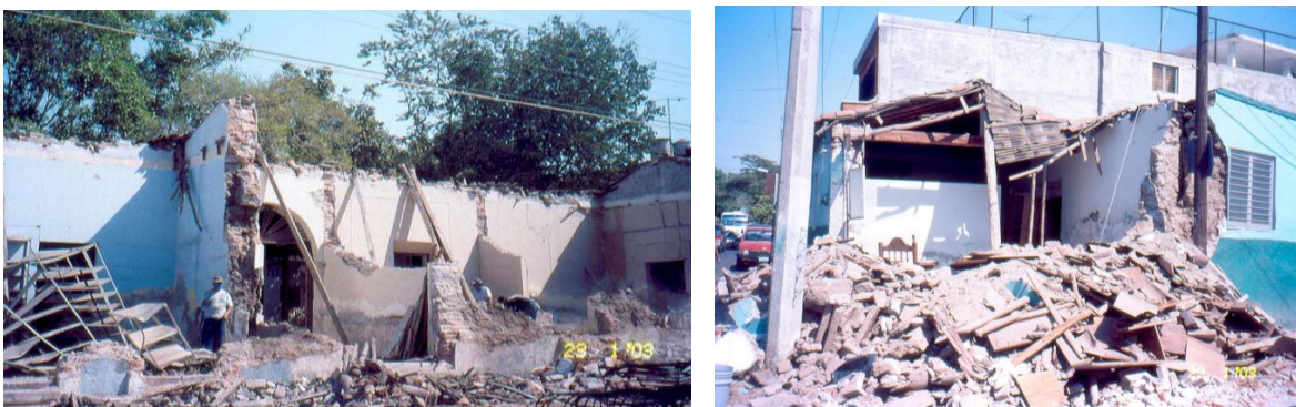
Figura 7.11 Colapso de viviendas de adobe
