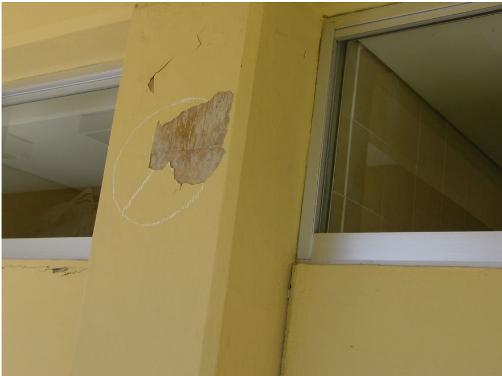
Figura 9.18 Daño ligero en una columna del Hospital del IMSS en Coalcomán
