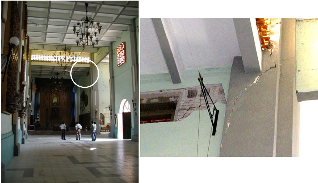
Figura 10.19 Vista de la nave principal y detalle de daño en la parte superior de una columna
