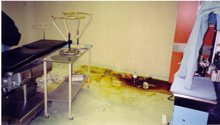
Figura 9.8 Evidencia de la caída de mobiliario y equipo en el área de quirófanos
