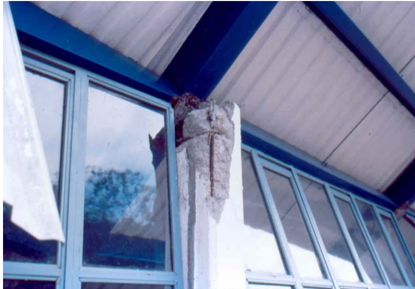
Figura 8.21 Detalle de una conexión deficiente del sistema de techo de un edificio escolar
