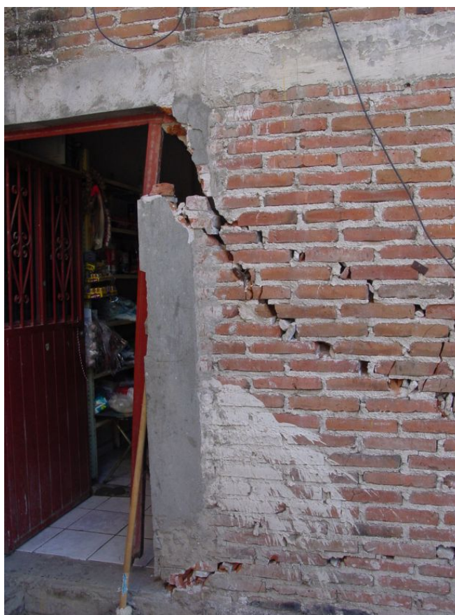
Figura 7.118 Daño severo en viviendas de mampostería no confinada (el aparente castillo de la foto está simulado con pasta de cemento)
