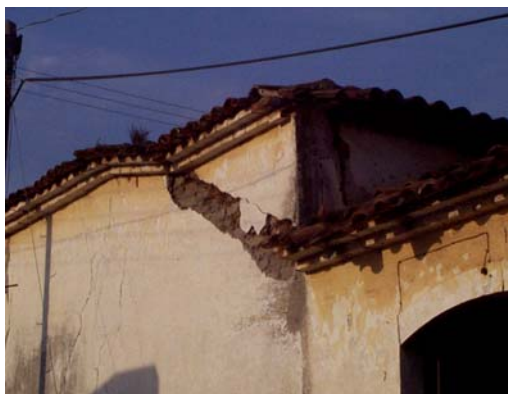
Figura 7.87 Movimiento relativo entre dos construcciones y falla de la parte superior de la construcción de mayor altura
