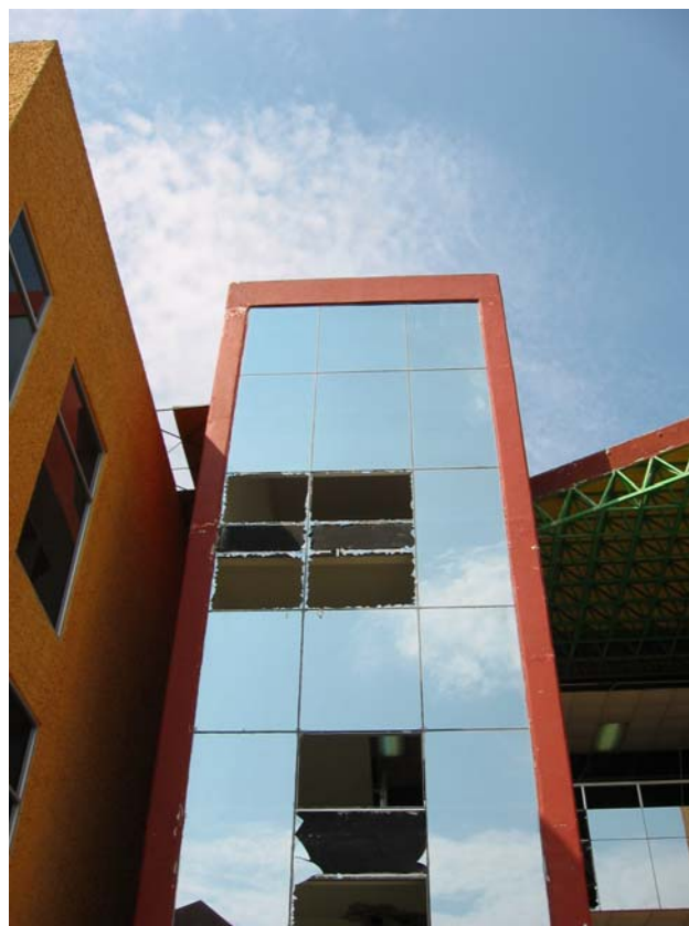
Figura 8.8 Detalle de la fachada de cristal del cubo de escaleras del edificio de la Biblioteca de Ciencias de la Universidad Autónoma de Colima
