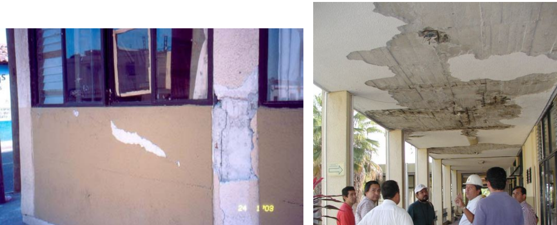
Figura 11.22 a) Daño por flexión en columna restringida por pretil; b) Deterioro en la losa y su acero
