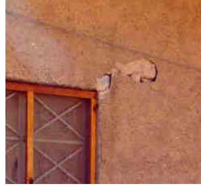
Figura 7.70 Desprendimiento del recubrimiento o enjarre en muros de adobe
