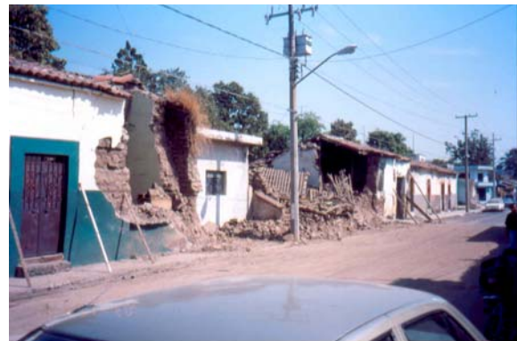
Figura 7.10 Caída parcial de muros y apuntalamiento de los muros
