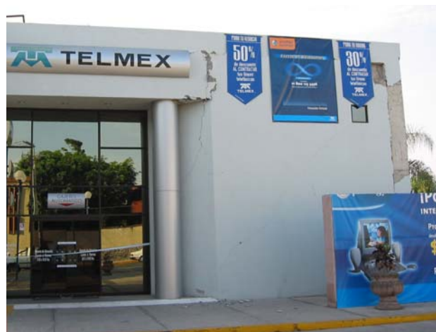
Figura 12.3 Fachada frontal del edificio
