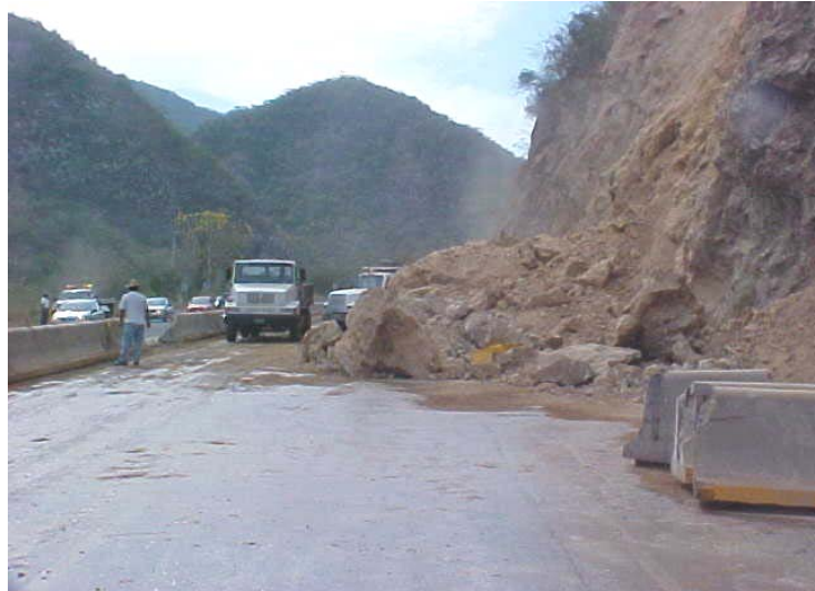
Figura 13.7 Derrumbes en el tramo de La Salada que se ubica en la carretera Colima–Tecomán
