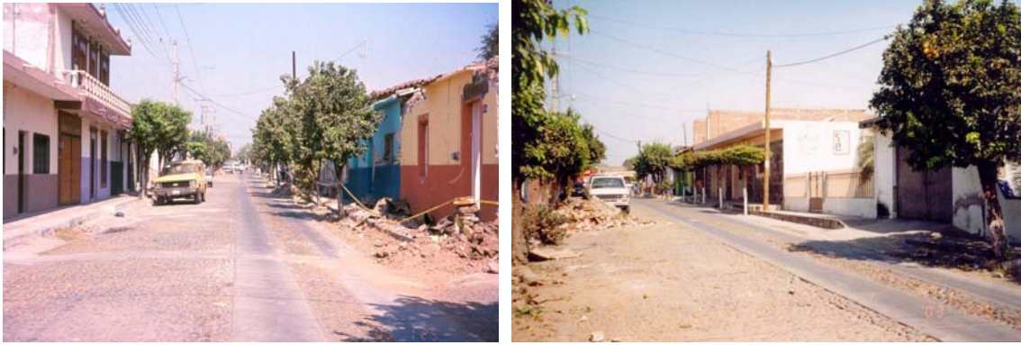
Figura 7.39 Ausencia de daño en construcciones de mampostería confinada
