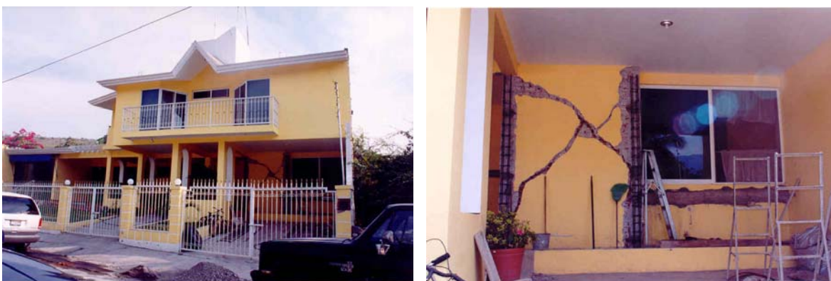
Figura 7.81 Vivienda de mampostería confinada con escasa cuantía de muros en planta baja (piso blando), en reparación con elementos de concreto (castillos y dalas)
