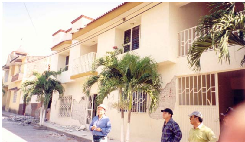
Figura 7.48 Vivienda número 11 con nivel de daño tipo II
