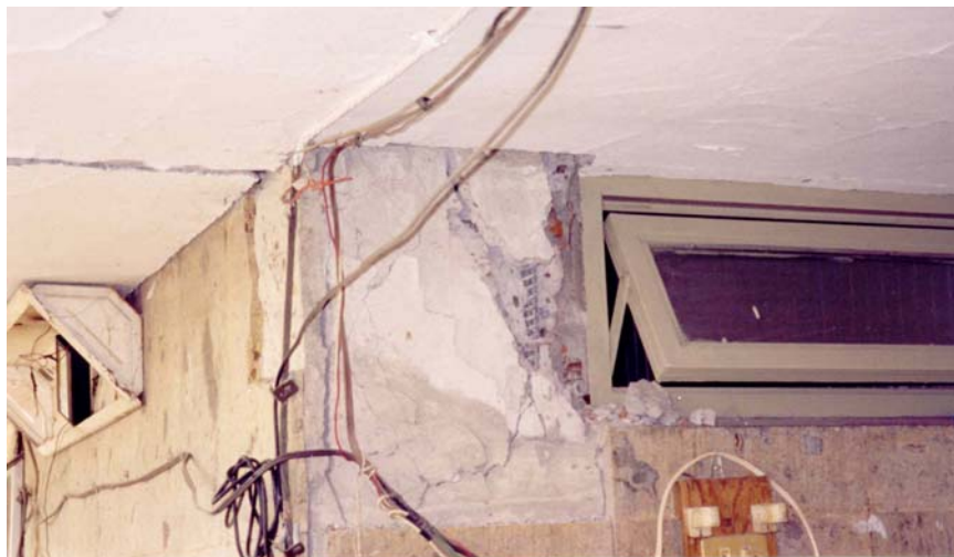
Figura 9.14 Daño en columnas del cuarto de control por efecto de columna corta
