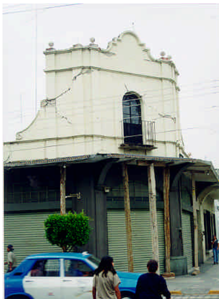
Figuras 8.22 y 8.23 - Daño en apéndice y en impostas de arcos
