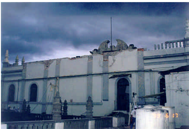
Figuras 5.65 y 5.66 - Almenas y balaustrada desplomadas; colapso de la losa del segundo nivel
