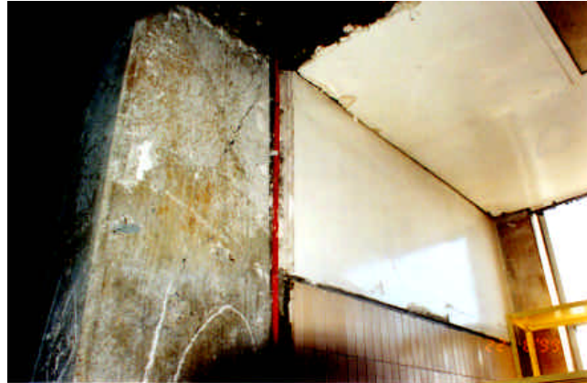
Figura 4.10 - Agrietamiento inclinado en columnas del primer nivel del edificio C
