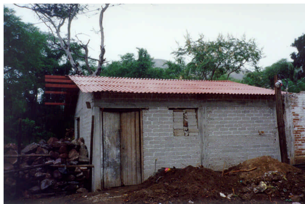
Figura 9.2 - Vivienda de bloque ligero que repone a una totalmente destruida en el estado de Oaxaca
