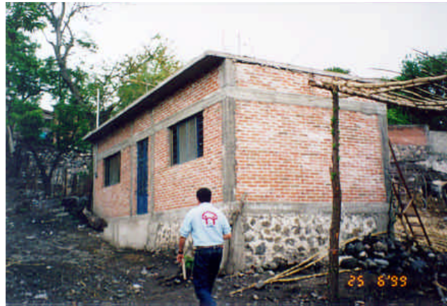
Figura 6.46 - Vivienda vecina de mampostería confinada, sin daño
