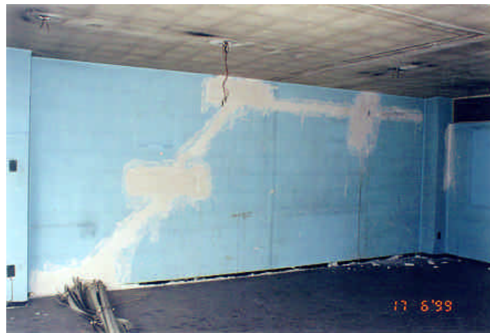
Figura 8.10 - Muros de mampostería resanados con yeso
