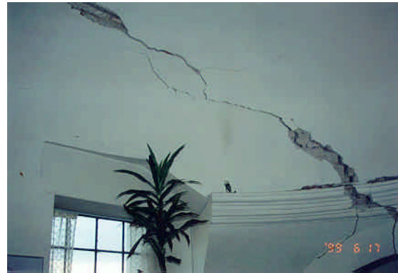
Figuras 5.58 y 5.59 - Daño en cúpulas por la formación de arcos cortos
