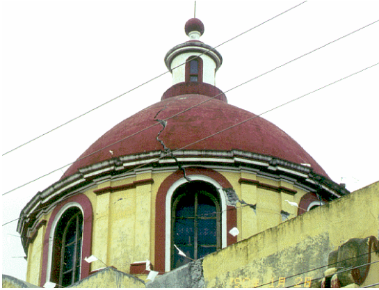
Figuras 5.40 y 5.41 - Daño en la cúpula y cuerpo de la torre
