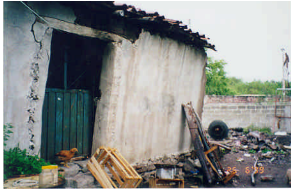
Figuras 6.21 y 6.22 - Daño en la intersección de muros y por movimientos fuera de su plano
