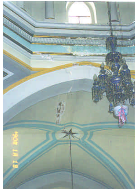
Figuras 5.15 y 5.16 - Daño en la base del segundo nivel del campanario y en el arco soporte de la cúpula central
