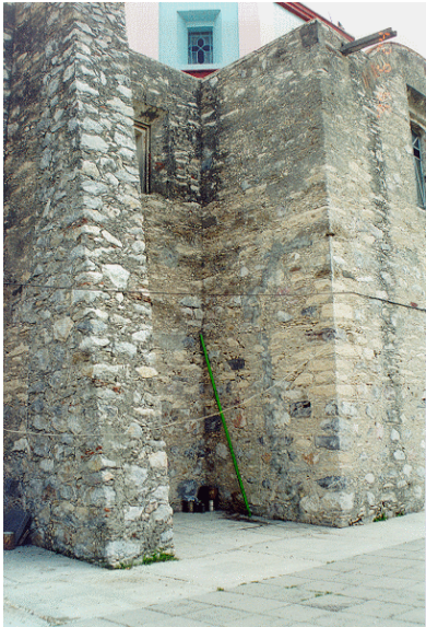
Figuras 5.115 y 5.116 - Agrietamientos previos en los contrafuertes y detalle del daño en la torre
