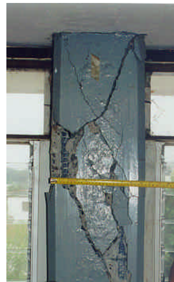
Figuras 7.17 y 7.18 - Detalle del daño en una columna del cuerpo C (fachada sur)
