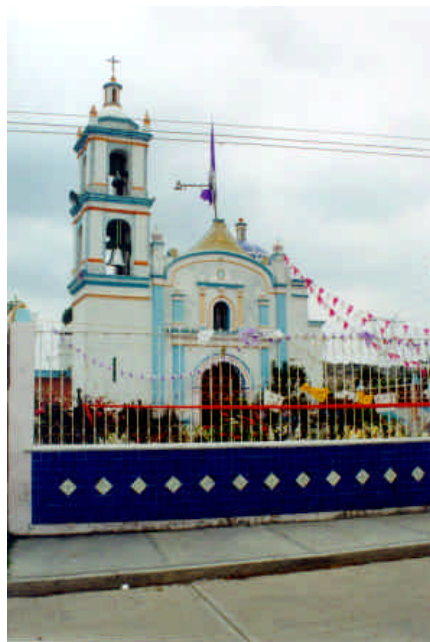
Figura 5.12 - Fachada de la Iglesia de Santa Cruz Calera
