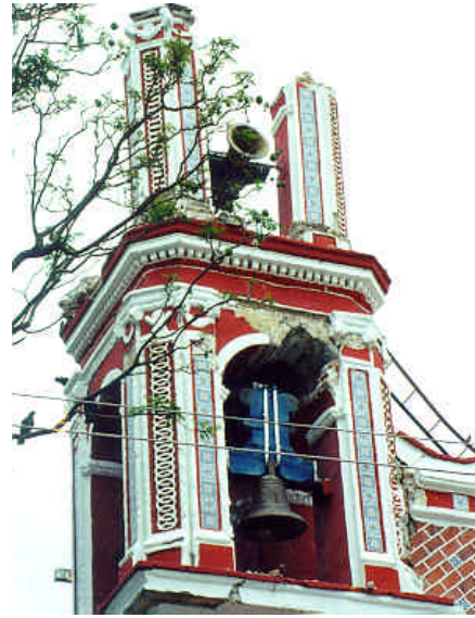
Figuras 5.7 y 5.8 - Daño en la bóveda (zona de colapso del campanario) y detalle de la falla y daño en la torre frontal izquierda
