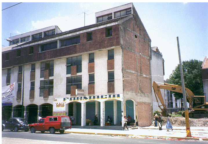
Figura 6.32 - Vista de la fachada oeste del edificio F
