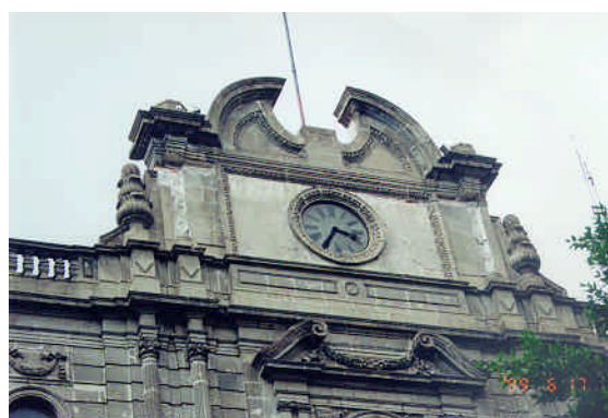
Figuras 5.69 y 5.70 - Estado de almenas y detalle del daño en el frontón del reloj
