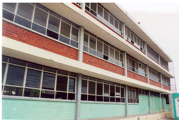
Figura 7.12 - Fachada sur del edificio C
