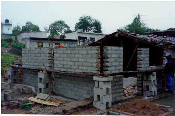
Figura 9.3 - Vivienda de adobloque que repone a una totalmente destruida en el estado de Oaxaca
