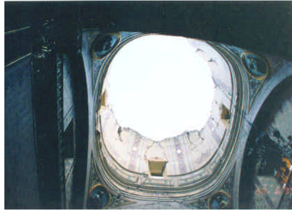
Figuras 5.84 y 5.85 - Agrietamiento de una de las torres de fachada y colapso de una de las cúpulas
