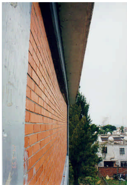
Figura 7.7 - Detalle del movimiento fuera del plano del muro extremo del edificio C
