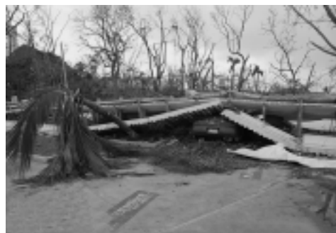
Figura 19 Los vientos intensos de un ciclón tropical pueden generar daños estructurales a las edificaciones
