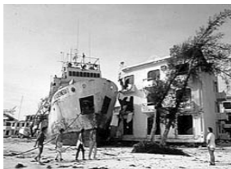
Figura 10 Efectos del huracán Gilbert, 1988 en Cancún, Q. Roo
