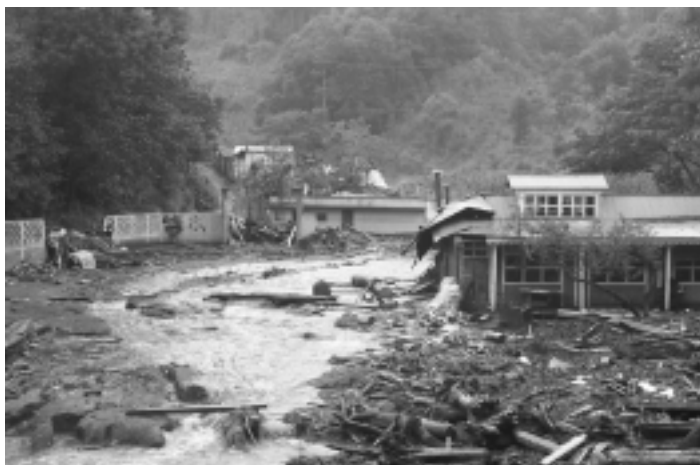
Figura 37 Casas afectadas por una corriente de agua
