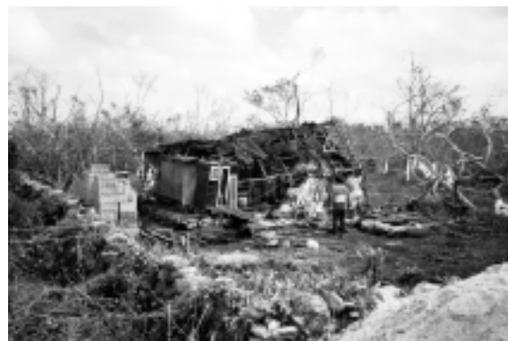
Figura 23 Efectos del viento generados por el huracán Isidore en Yucatán
