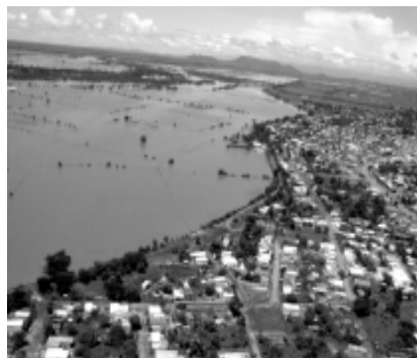
Fig. 43. Bordo longitudinal sobre el río Santiago, Nay.
