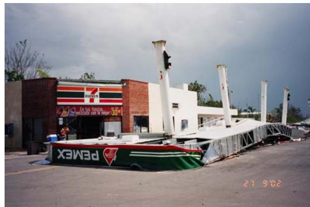
Figura 4.3 Daño en una estación de abastecimiento de gasolina en la salida Este de Mérida
