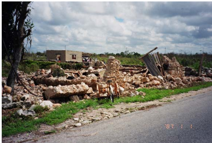
Figura 4.8 Daño en la techumbre de edificación de vivienda con material precario en techos y mampostería confinada en los muros
