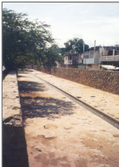
Figura 3.22 Sección del arroyo Aguas Blancas
