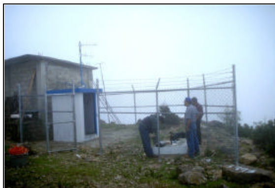
Figura 5.12 Vista de la estación repetidora en Mozotal
