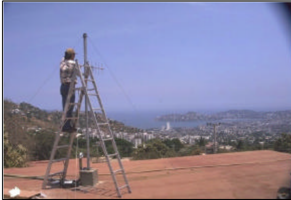
Figura 3.3 Instalación y alineación de la antena de radio dirigida hacia el Puesto Central de Registro de la CNA
