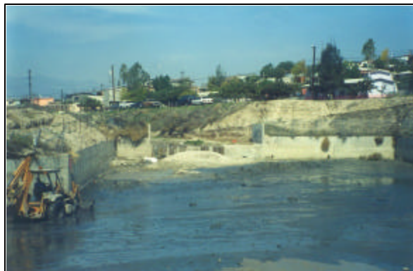
Figura 4.30 Canal de llamada del desarenador en el cauce del arroyo "El Florido"
