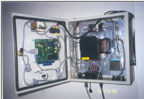
Figura 4.21 Vista interior del gabinete con los módulos de control y comunicación en el Puesto Central de Registro PCR-1
