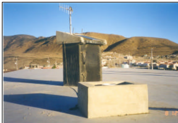
Figura 4.6 Estación Villafontana, VF-04
