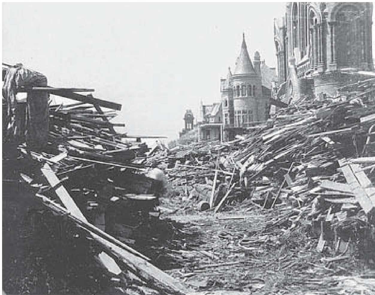
Huracán que atacó el poblado de Galveston, Texas en 1900. La ciudad quedó devastada con una cifra de 6000 muertes y 10 000 personas damnificadas. El principal efecto destructor del huracán fue la marea de tormenta
