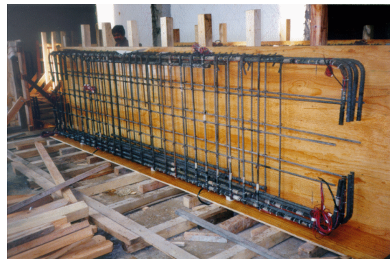
Figura 3.7 – Armado del refuerzo
