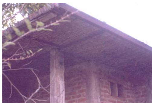
Figura 7.97 Sistema de techo resuelto con bóveda catalana
