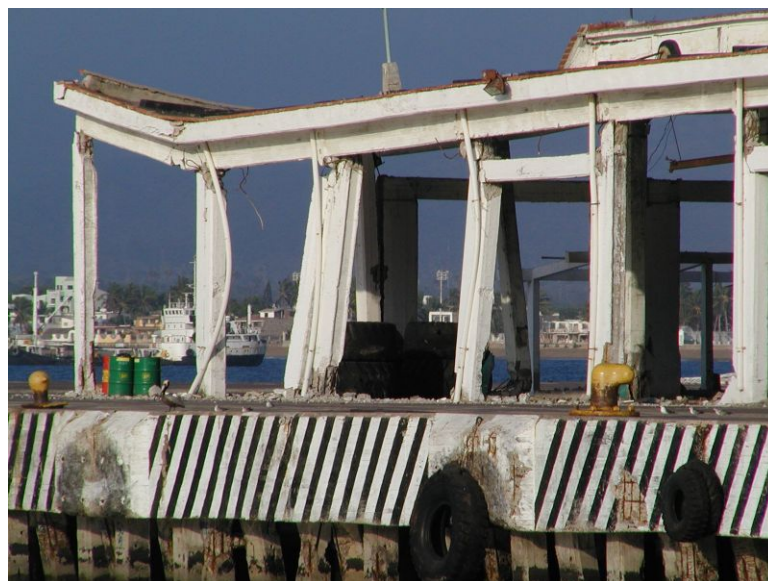
Figura 6.1 Estructura sobre el muelle fiscal
