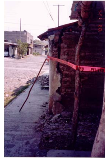
Figura 7.33 Daño en edificaciones de adobe sin liga entre muros ortogonales
