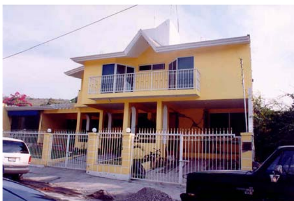
Figura 7.81 Vivienda de mampostería confinada con escasa cuantía de muros en planta baja (piso blando), en reparación con elementos de concreto (castillos y dalas)
