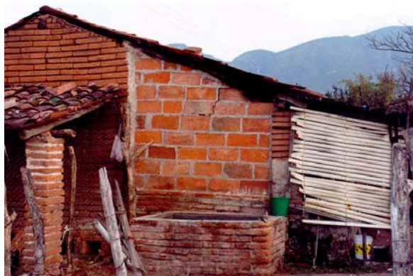
Figura 7.98 Mampostería simple de piezas diferentes
