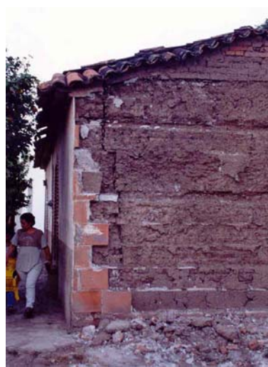
Figura 7.73 Agrietamiento de vertical en muros de esquina
