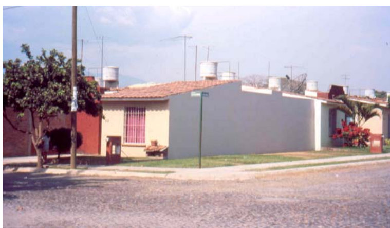
Figura 7.40 Fraccionamiento habitacional con detalle ingenieril
