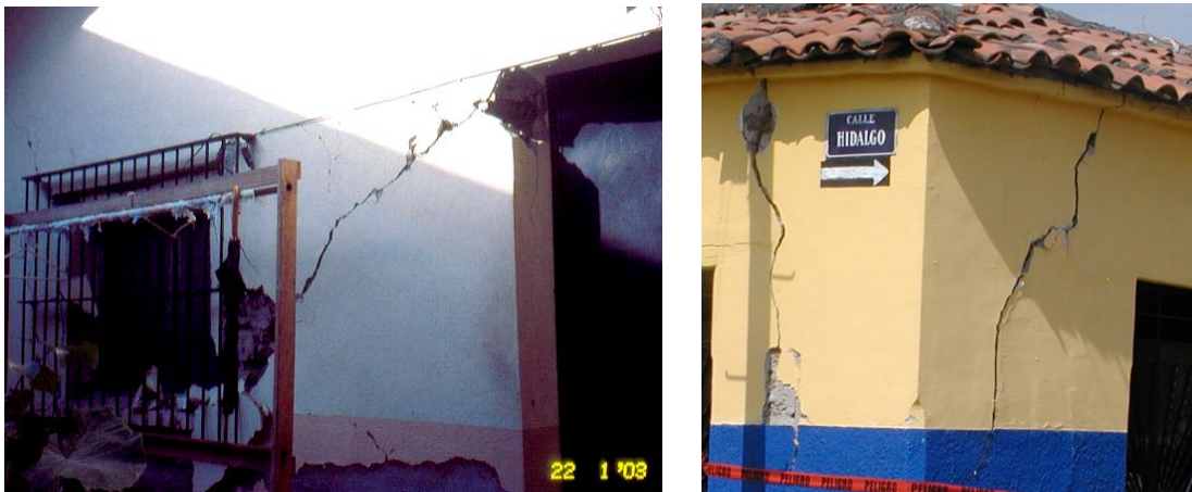
Figura 7.6 Agrietamiento inclinado
