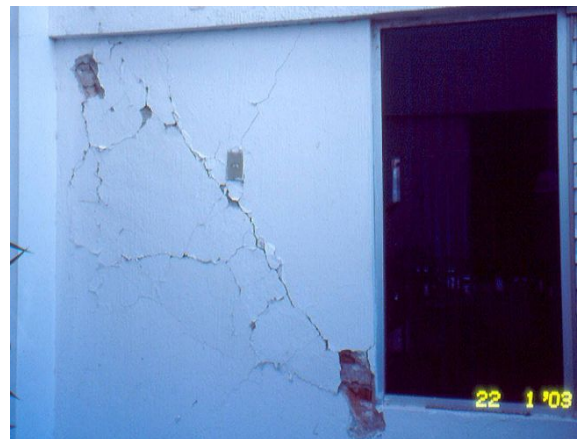
Figura 11.2 Fachada del edificio y muros agrietados
