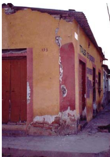
Figura 7.73 Agrietamiento de vertical en muros de esquina
