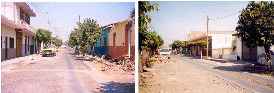
Figura 7.39 Ausencia de daño en construcciones de mampostería confinada
