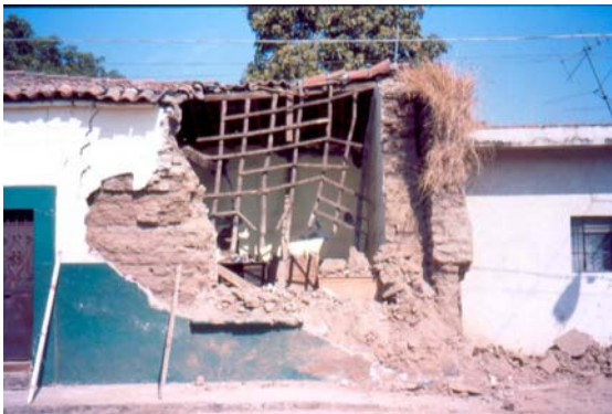
Figura 7.9 Caída parcial y total de muros de adobe
