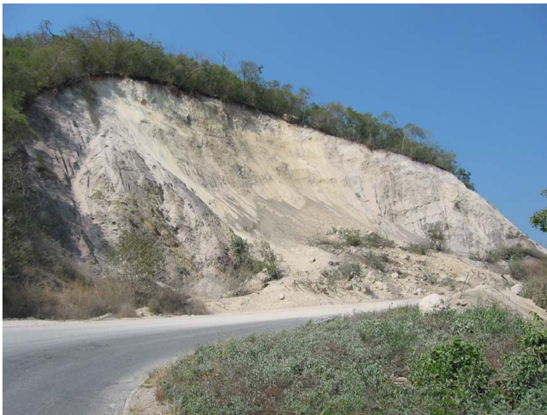
Figura 5.9 Deslizamiento ocurrido en un corte de la carretera Colima-Tecomán
