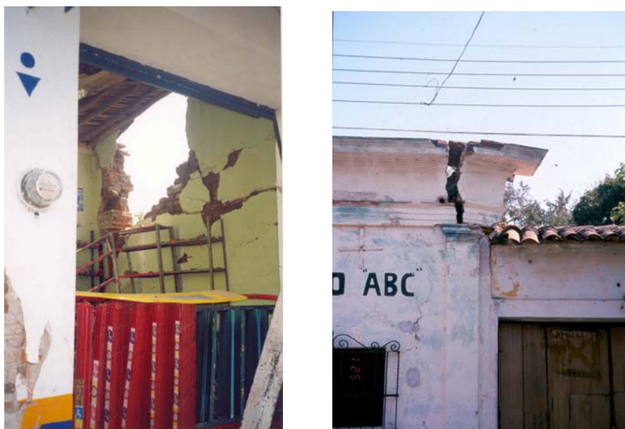
Figura 7.36 Ejemplo de la caída parcial de muros y pretilos
