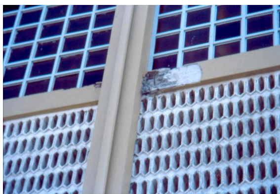
Figura 10.3 Daño en los extremos de traves (articulaciones plásticas)
