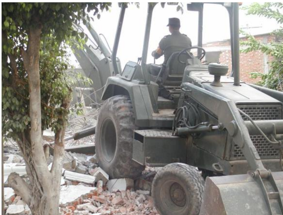
Figura 13.4 Personal militar en operaciones de demolición
