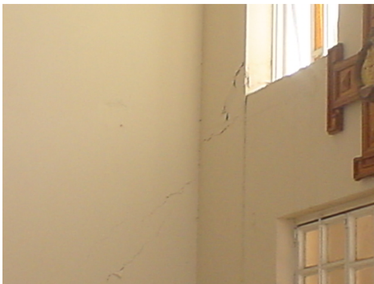
Figura 10.22 Agrietamiento ligero en muros en iglesias del estado de Jalisco, ubicadas en la vecindad del municipio de Guadalajara
