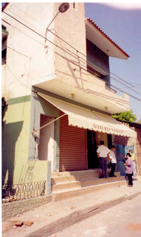
Figura 7.50 Vista exterior de la vivienda 10
