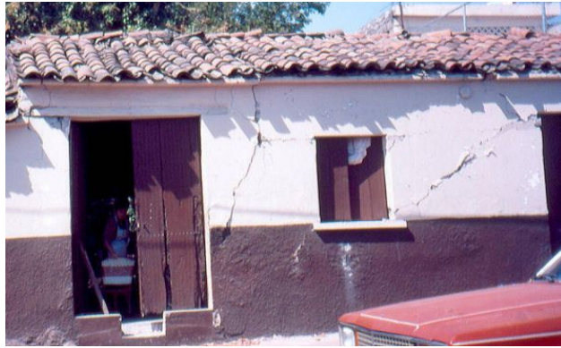
Figura 7.7 Agrietamiento inclinado
