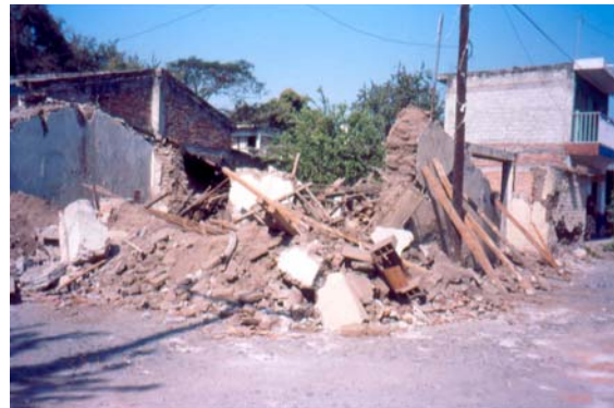
Figura 7.9 Caída parcial y total de muros de adobe
