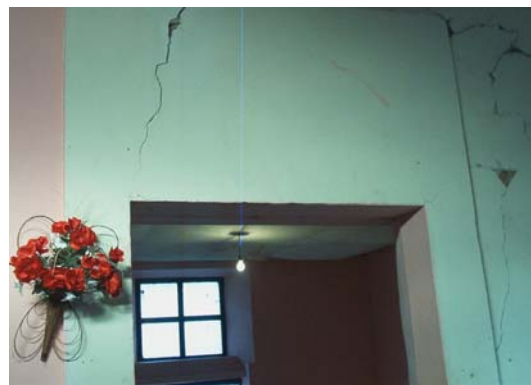
Figura 7.88 Agrietamiento en aberturas de muros de mampostería simple
