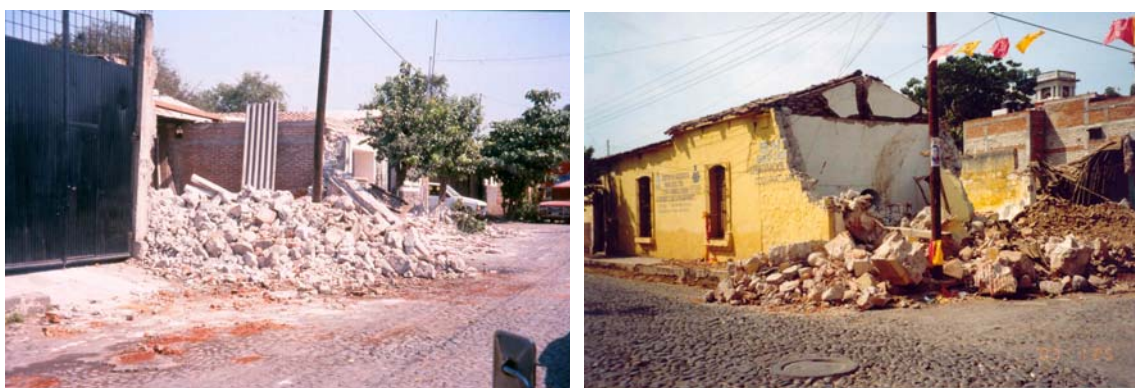
Figura 7.41 Construcciones con materiales combinados y falla de los muros
