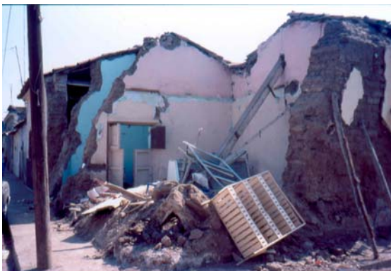
Figura 7.10 Caída parcial de muros y apuntalamiento de los muros
