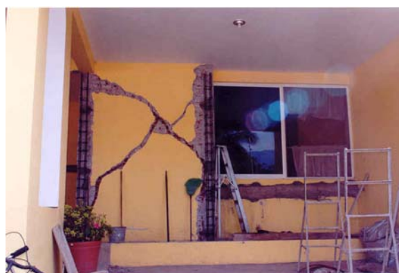
Figura 7.81 Vivienda de mampostería confinada con escasa cuantía de muros en planta baja (piso blando), en reparación con elementos de concreto (castillos y dalas)
