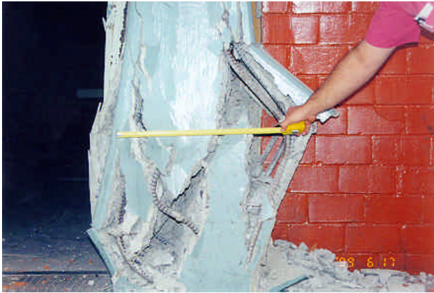
Figura 7.26 y 7.27 - Articulaciones plásticas y falla por corte de las columnas de planta baja
