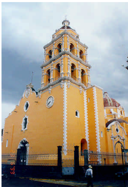
Figuras 5.27 y 5.28 - Vista panorámica y detalle del daño en la torre del campanario de la Iglesia de Santa María de la Natividad
