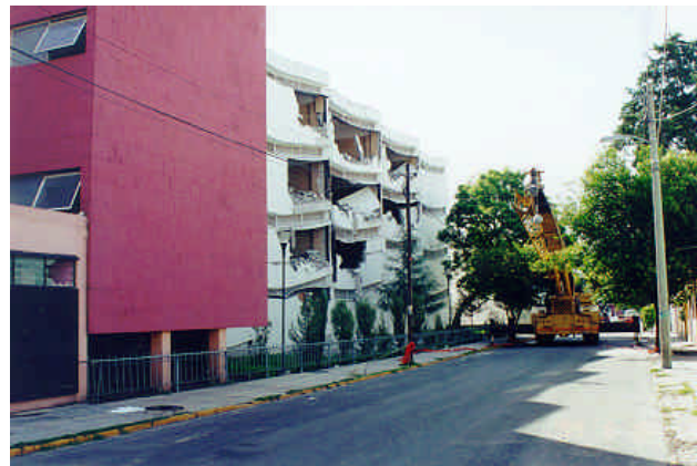
Figuras 7.28 y 7.29 - Agrietamiento de losas por flexión y demolición de muros de fachada
