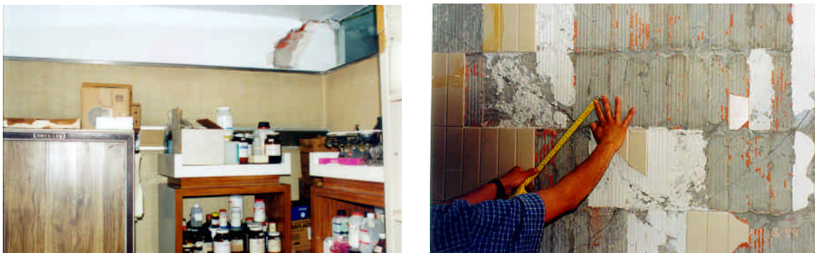
Figuras 4.4 y 4.5 - Agrietamiento en muros divisorios y muros de la junta constructiva entre cuerpos
