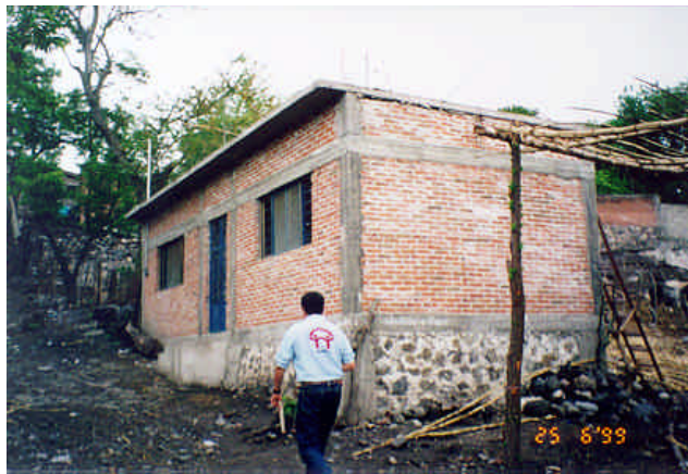
Figura 6.46 - Vivienda vecina de mampostería confinada, sin daño
