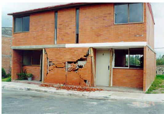
Figuras 6.17y 6.18 - Daño típico en el muro del eje 3 de la fachada y castillo interno donde no llegó la mezcla de concreto
