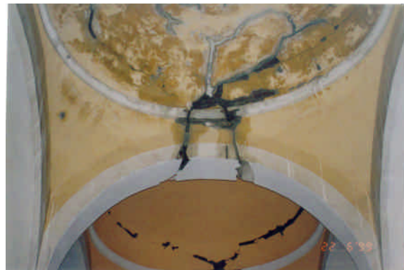
Figuras 5.32 y 5.33 - Vista panorámica de la Capilla Real y reparaciones en cúpulas mediante relleno de grietas
