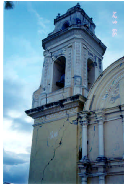
Figuras 5.94 y 5.95 - Vista general y detalle del daño en la torre izquierda de fachada
