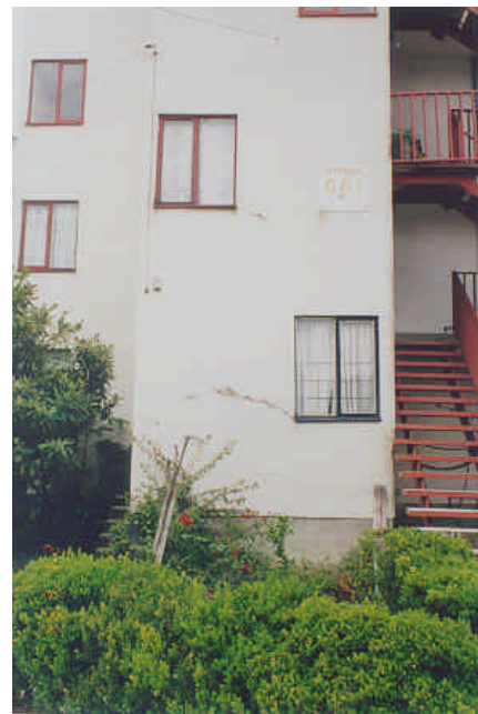
Figuras 6.6 y 6.7 - Daño en la planta baja y muros de fachada del edificio 001
