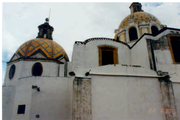
Figura 5.82 - Parte posterior de la iglesia, sin daño
