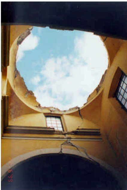
Figuras 5.34 y 5.35 - Colapso de una de las bóvedas y agrietamiento de otras en crujías interiores
