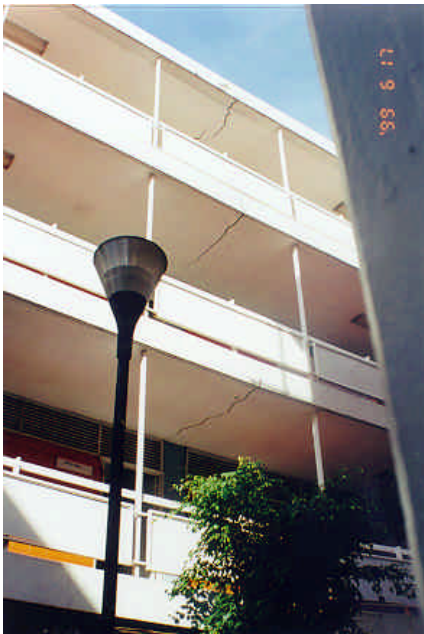
Figuras 7.28 y 7.29 - Agrietamiento de losas por flexión y demolición de muros de fachada
