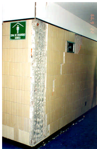
Figuras 4.2 y 4.3 - Vista general del Hospital San José y columna de segundo nivel, sin recubrimiento
