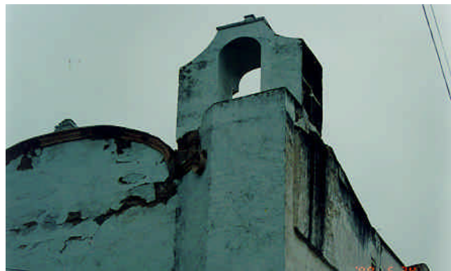
Figuras 5.105 y 5.106 - Vista de la fachada principal y detalle del daño en frontón
