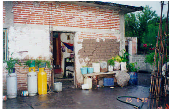
Figuras 6.27 y 6.28 - Cambio de material de construcción en otras viviendas y agrietamiento inclinado cercano a aberturas en muros de adobe
