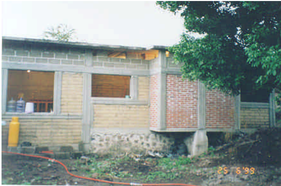
Figuras 6.27 y 6.28 - Cambio de material de construcción en otras viviendas y agrietamiento inclinado cercano a aberturas en muros de adobe
