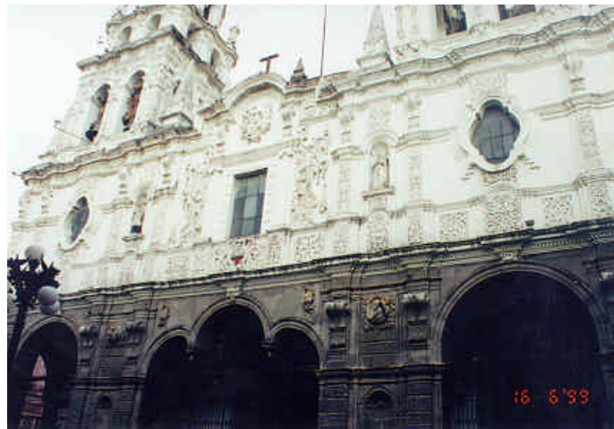
Figura 5.61 - Portal de la Iglesia de la Compañía
