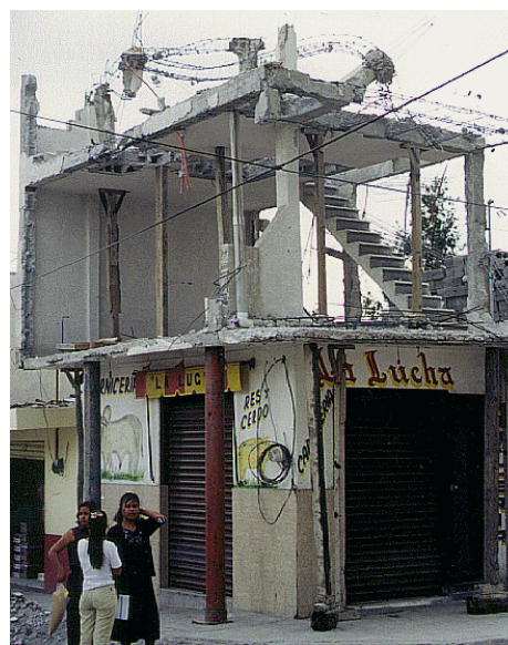
Figuras 8.11 y 8.12 - Estructura de vigueta y bovedilla antes y después de iniciar la demolición
