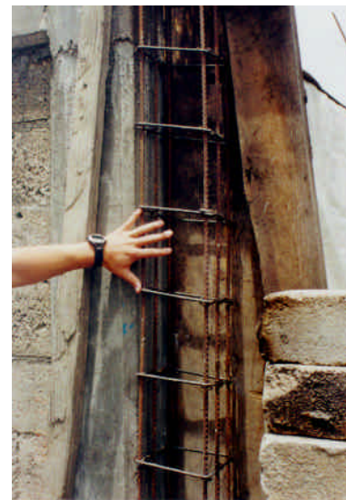
Figuras 6.51 y 6.52 - Detalle de cimentación y del refuerzo de castillos en una construcción en proceso
