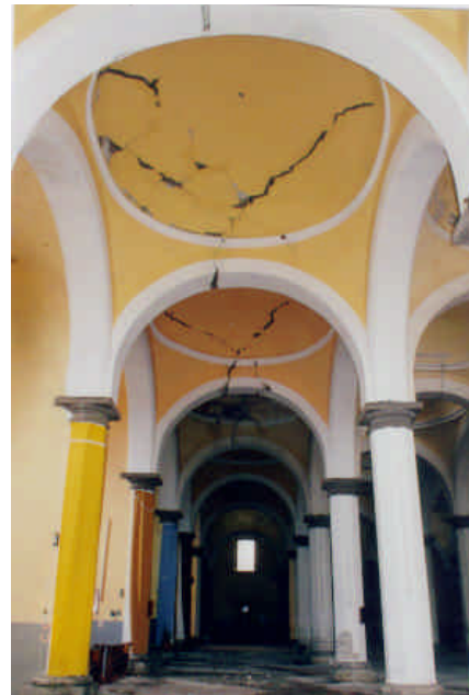
Figuras 5.34 y 5.35 - Colapso de una de las bóvedas y agrietamiento de otras en crujías interiores
