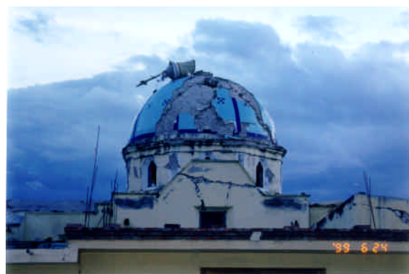
Figuras 5.96 y 5.97 - Daño severo en el muro del ábside y de la cúpula central
