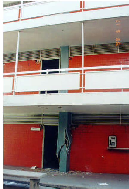
Figura 7.26 y 7.27 - Articulaciones plásticas y falla por corte de las columnas de planta baja
