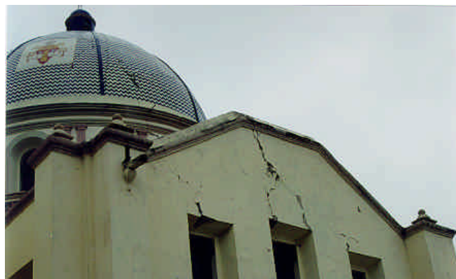
Figuras 5.110 y 5.111 - Agrietamientos en el lado oriente del campanario y en el lado poniente de los muros del contrafuerte de crucero
