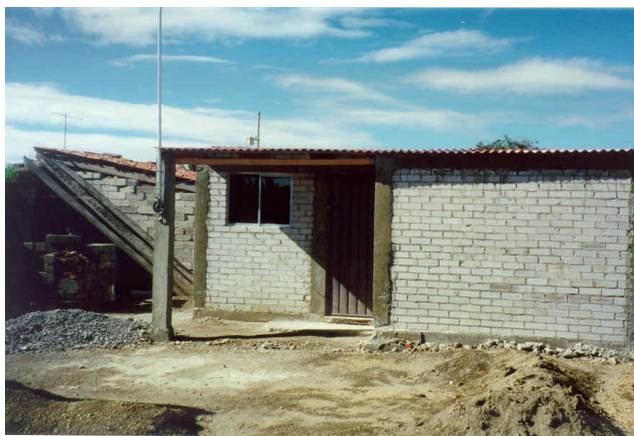
Figura 9.1 - Prototipo de vivienda que repone a una totalmente destruida
