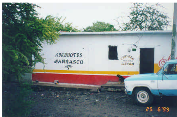
Figura 6.24 - Vivienda de adobe y mampostería de tabique de barro
