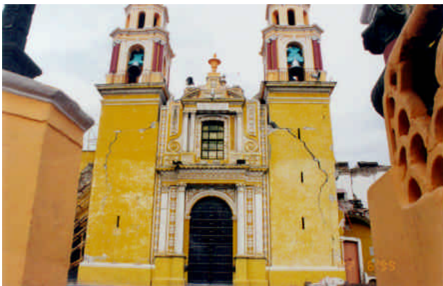
Figuras 5.78 y 5.79 - Agrietamiento inclinado y horizontal en torres de fachada
