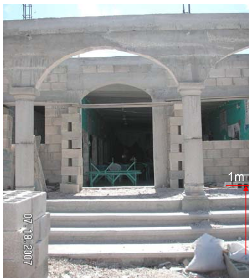
Figura 4.1. Nuevas viviendas construidas con materiales resistentes
