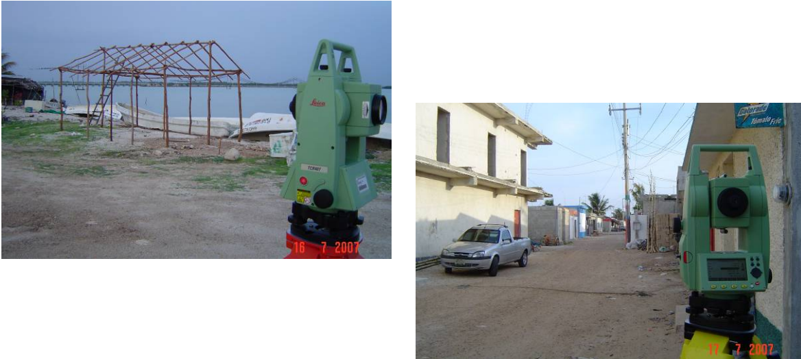
Figura 3.1 Levantamiento topográfico con “estación total”
