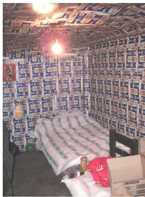
a) Uso adecuado de calentones, debido a que existe ventilación en la habitación b) Cómo utilizar el cartón en paredes y techos
