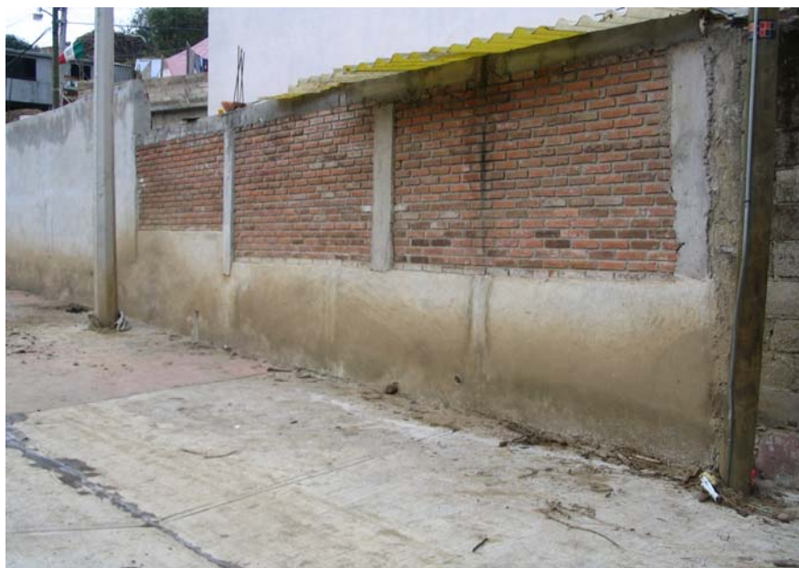
Figura 2.10 Barda construida en vivienda afectada en el 2001
