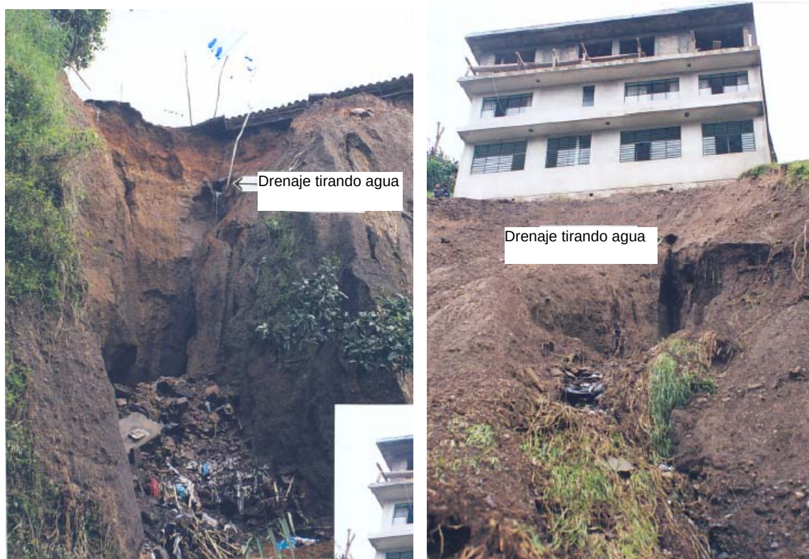
Figura 5.19 Deslizamientos de tierra provocados por fugas en los sistemas de drenaje
