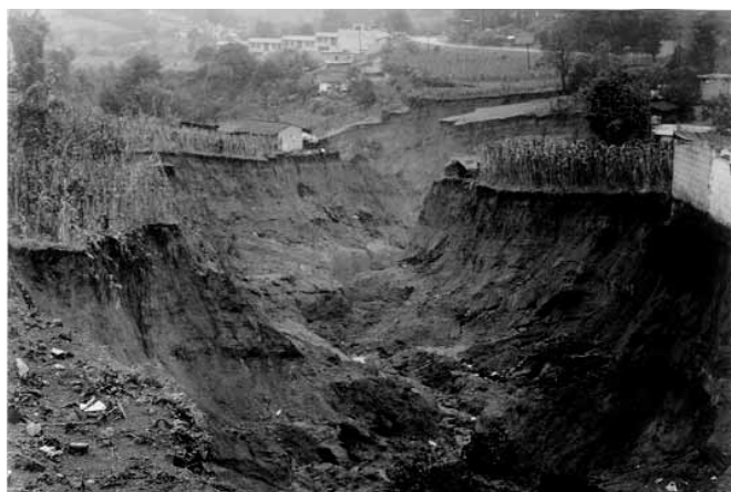
Figura 15 - Formación de cárcavas que afectaron construcciones y terrenos de cultivo
