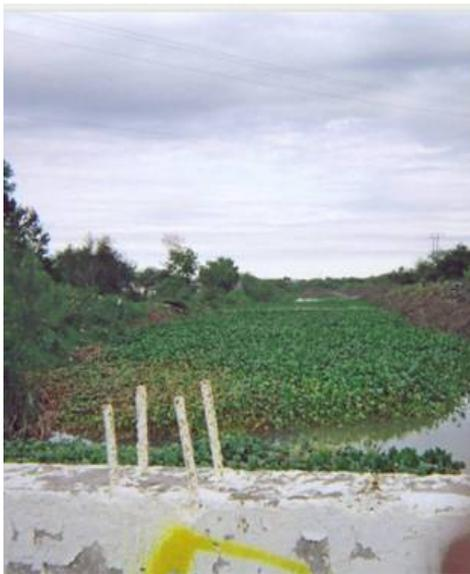
**Figura 2.23 Dren azolvado por falta de mantenimiento**
