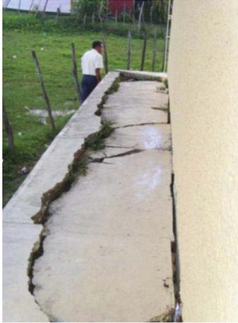
**Figura 2.157** Telesecundaria con daño de tipo estructural a causa de la inundación en Bitzal
