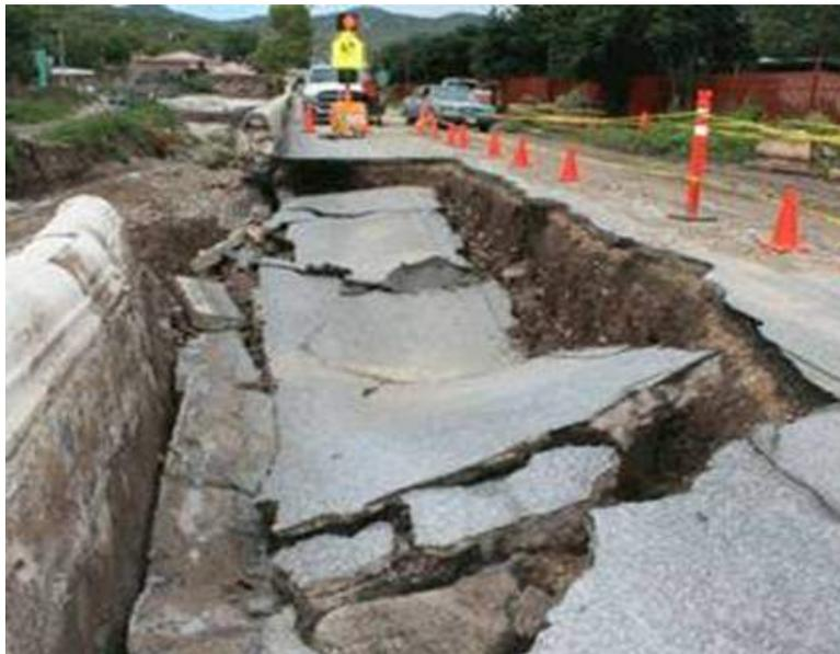
**Figura 2.70 Derrumbe de pavimento en la carretera a Santa Eulalia**
