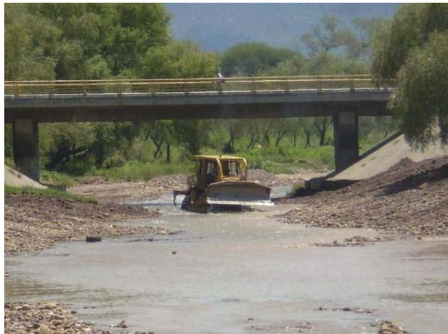
**Figura 2.46** Dragado de sedimento dentro del arroyo El Jaloco
