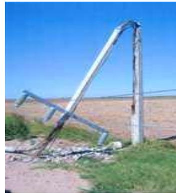
**Figura 2.223 Postes afectados a causa de los vientos por Norbert**
