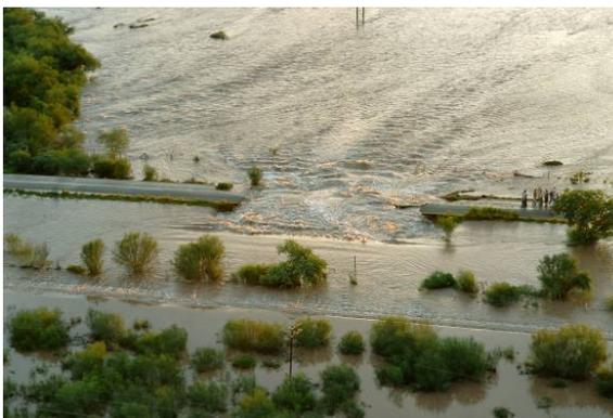
**E. Ruptura de un tramo de la carretera por el flujo de agua sobre ella**
