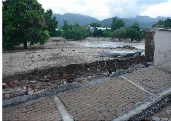
**B. Volteo de una barda por el empuje de la avenida y falla de su anclaje en su cimentación**
