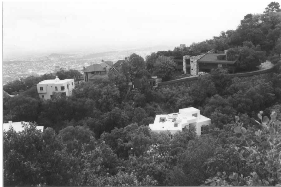
A.14 Viviendas ubicadas ladera abajo del sitio donde está la roca por desprenderse. Estas serían las casas potencialmente afectadas.
