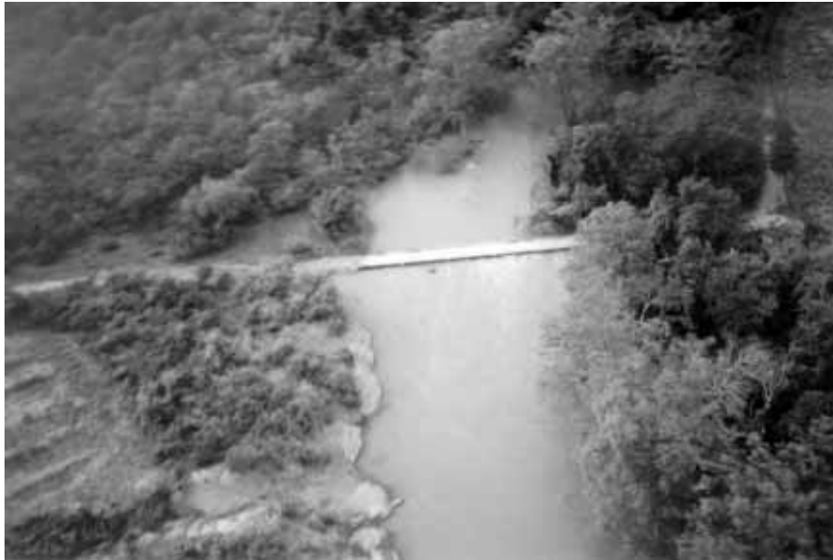
A.21 Puente sobre el río Sabinas
