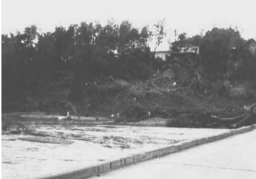
A.17 Puente en el río Guayalejo. Vista hacia aguas abajo en la margen derecha. Se observan las marcas del nivel de agua que la creciente dejó a su paso (aproximadamente 8 m, de altura)
