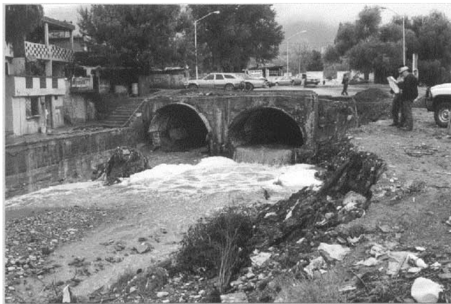
A.2 Alcantarillas a la salida de la confluencia del arroyo El Seco, a la altura del cerro La Campana.
