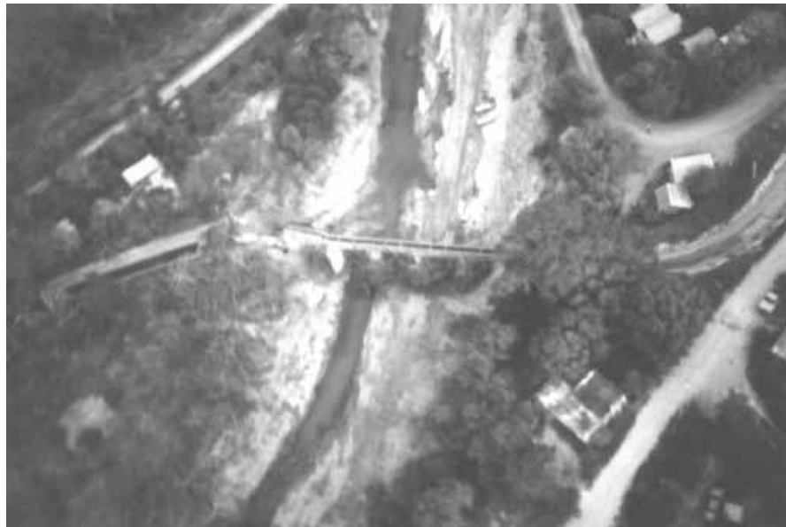
A.16 Vista aérea de un acueducto cercano a San Manuel. Se observa la acumulación de ramas y troncos en las pilas que lo sostienen. El nivel de agua seguramente sobrepasó los 4 m, y el ancho del cauce fue cinco veces su tamaño actual.
