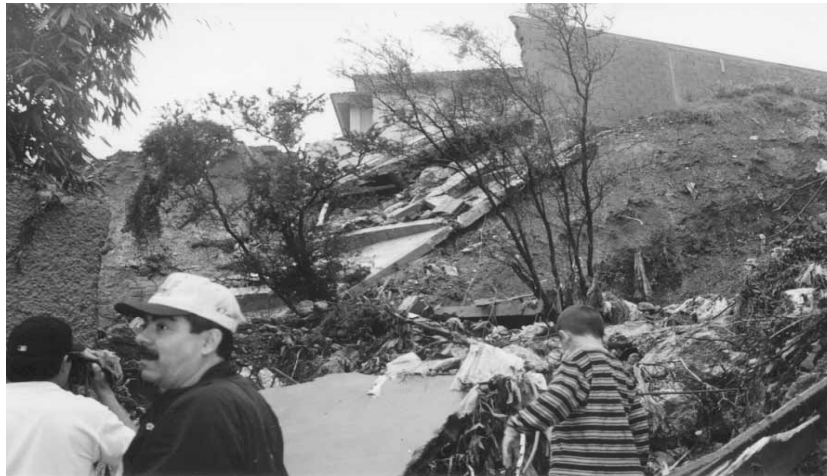
Fotografía 1.3 Daños en vivienda de clase media-alta
