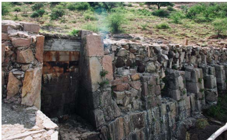
Figura 2.22 Vista de los vertedores clausurados con mampostería y compuertas de madera para elevar el nivel del embalse
