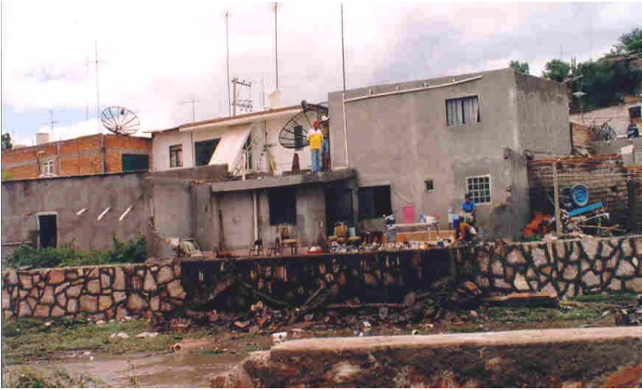
Figura 2.42 El nivel de agua alcanzó más de dos metros por arriba de los muros que encausan el río que cruza el municipio de Villa García
