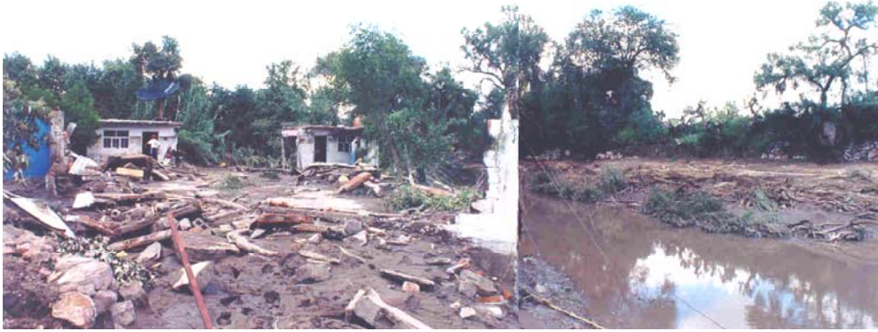
Figura 2.40 Casas ubicadas en las inmediaciones del cauce aguas abajo de la presa
