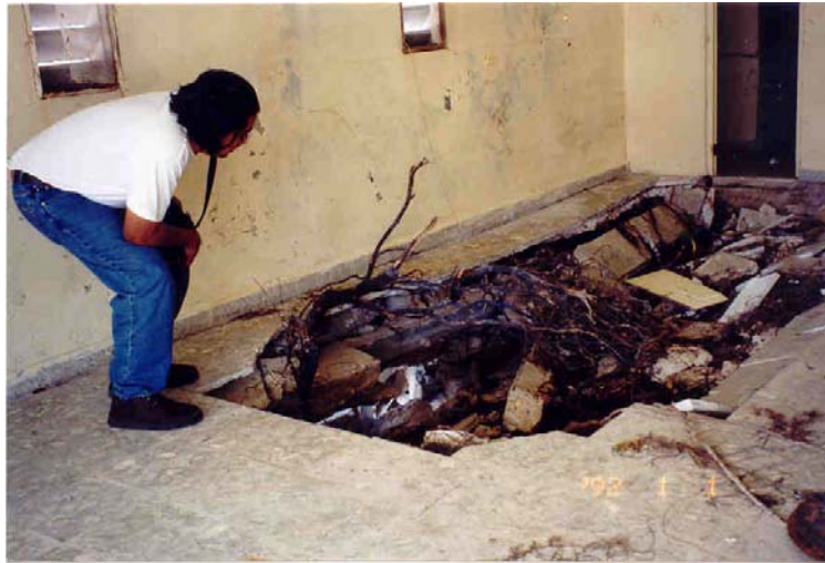
Figura 2.71 Socavación de cimientos en una vivienda en Telchac Puerto
