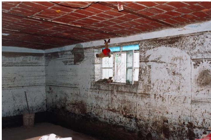
Figura 2.44 El nivel de agua subió más de 2 metros en algunas zonas de Villa García
