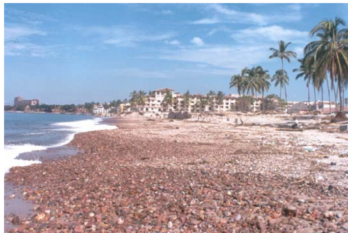
Figura 2.93 La erosión de más de 2 m ocasionó la falla de los muros de contención
