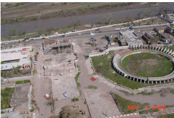
Figura 2.113 Daños en bardas y techos en la zona de un estadio de Béisbol en el puerto de San Blas, Nayarit
