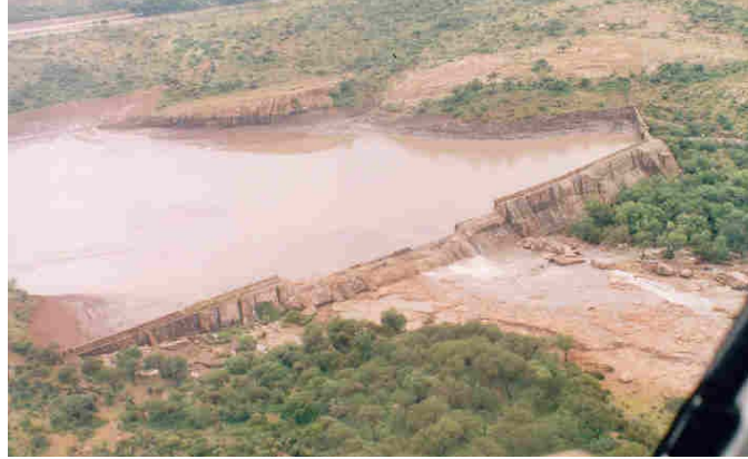
Figura 2.15 Vista aérea de la presa y su cortina de mampostería
