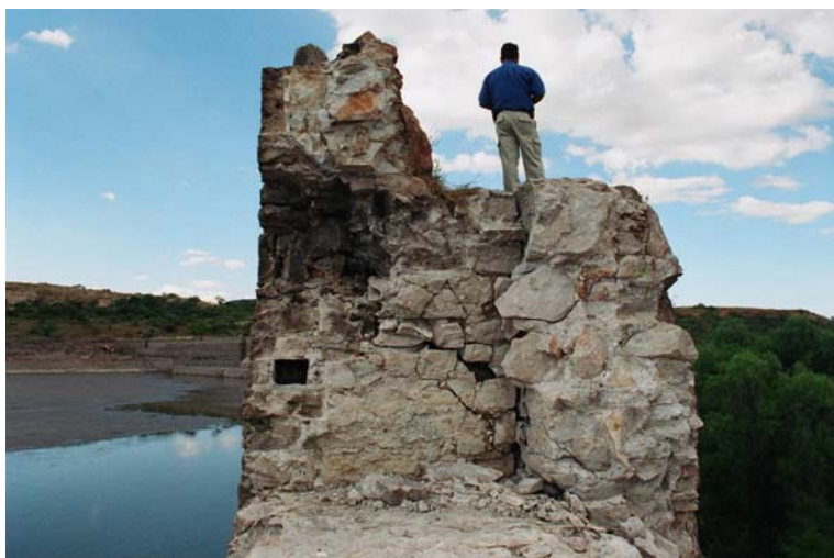
Figura 2.23 Vista de la sección transversal de la cortina después de la falla
