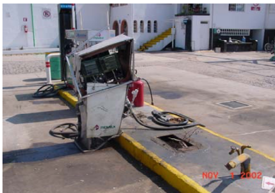
Figura 2.114 Daños en gasolineras
