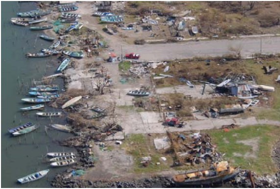
Figura 2.109 Daños en el puerto de San Blas, Nayarit
