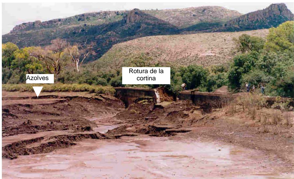
Figura 2.41 Azolves en el vaso de la presa El Capulín
