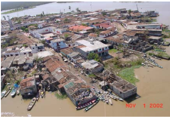
Figura 2.116 Desprendimiento de techos en viviendas
