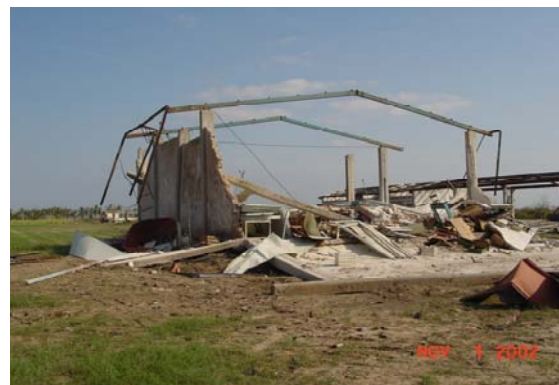
Figura 2.119 Colapso parcial de un edificio escolar
