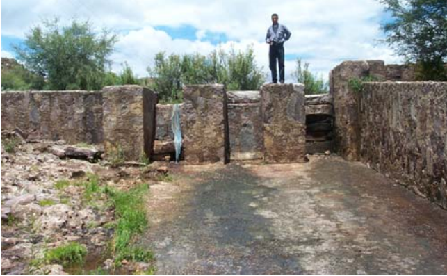
Figura 2.36 Los vertedores de la presa El Capulín se encontraban sellados con mampostería y agujas de madera
