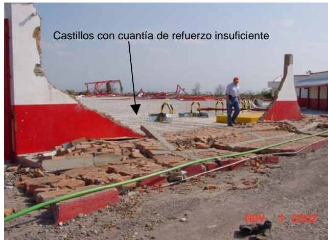
Figura 2.120 Daños observados en edificios escolares
