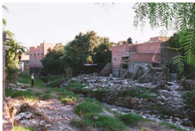
Figura 2.47 Las casas más afectadas fueron aquellas ubicadas a la orilla del cauce y sobre los puentes vehiculares utilizados para cruzar el río
