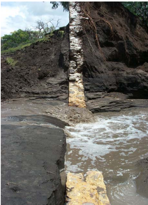
Figura 2.37 Debido a la acumulación de azolves las obras de toma se encontraban fuera de servicio
