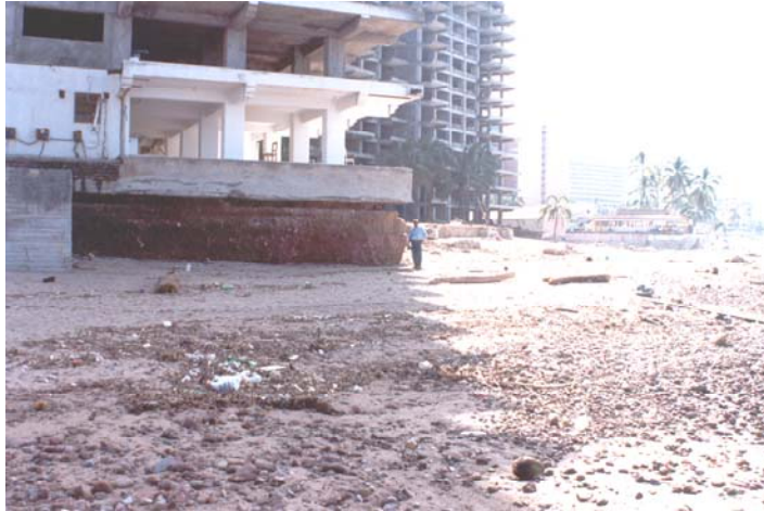
Figura 2.92 Erosión de la playa junto al edificio
