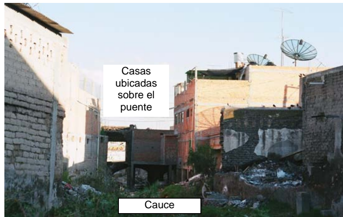
Fig. 2.43 Casas ubicadas transversalmente al cauce del río, sobre los puentes vehiculares
