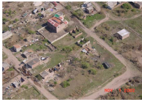
Figura 2.112 Daños en edificaciones al interior del puerto de San Blas, Nayarit
