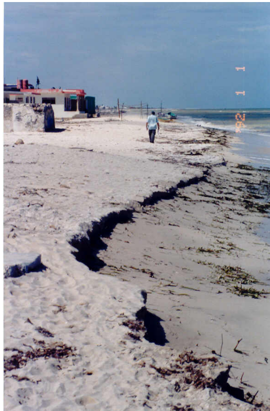
Figura 2.73 Problema de erosión en playa de Telchac Puerto
