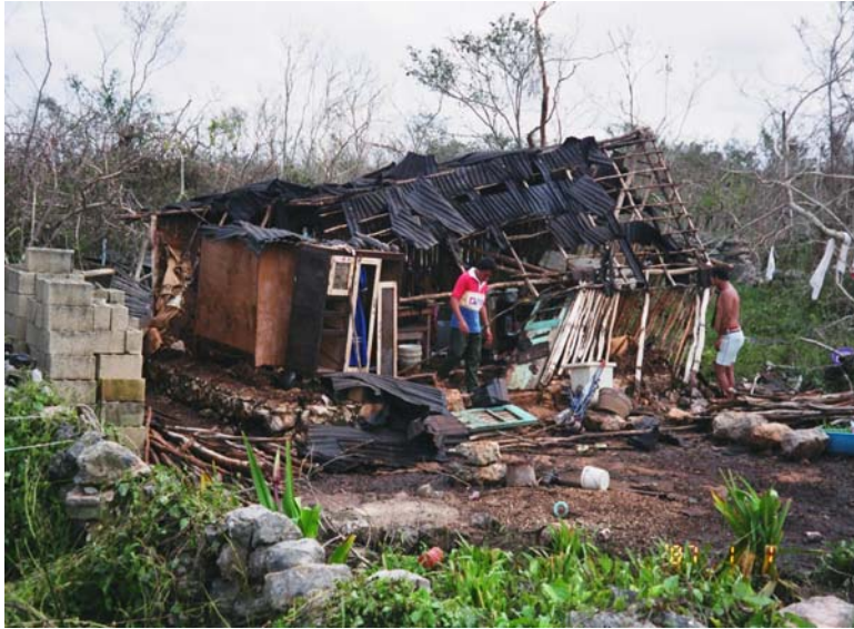
Figura 2.69 Falla de vivienda tipo en la región, constituida a base de material precario en muros y techos
