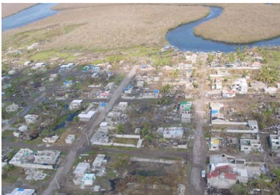
Figura 2.111 Daños en edificaciones al interior del puerto de San Blas, Nayarit
