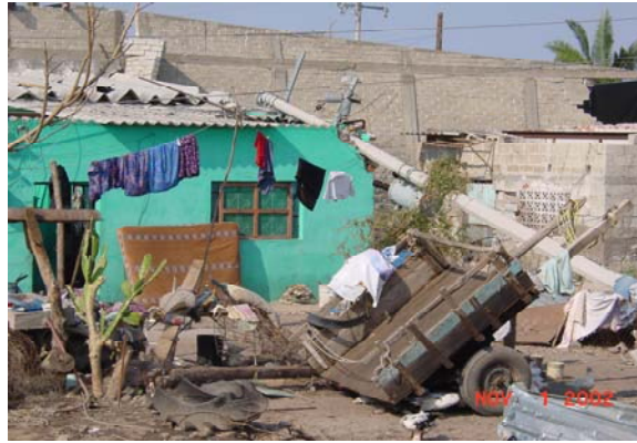
Figura 2.115 Daños en postes eléctricos
