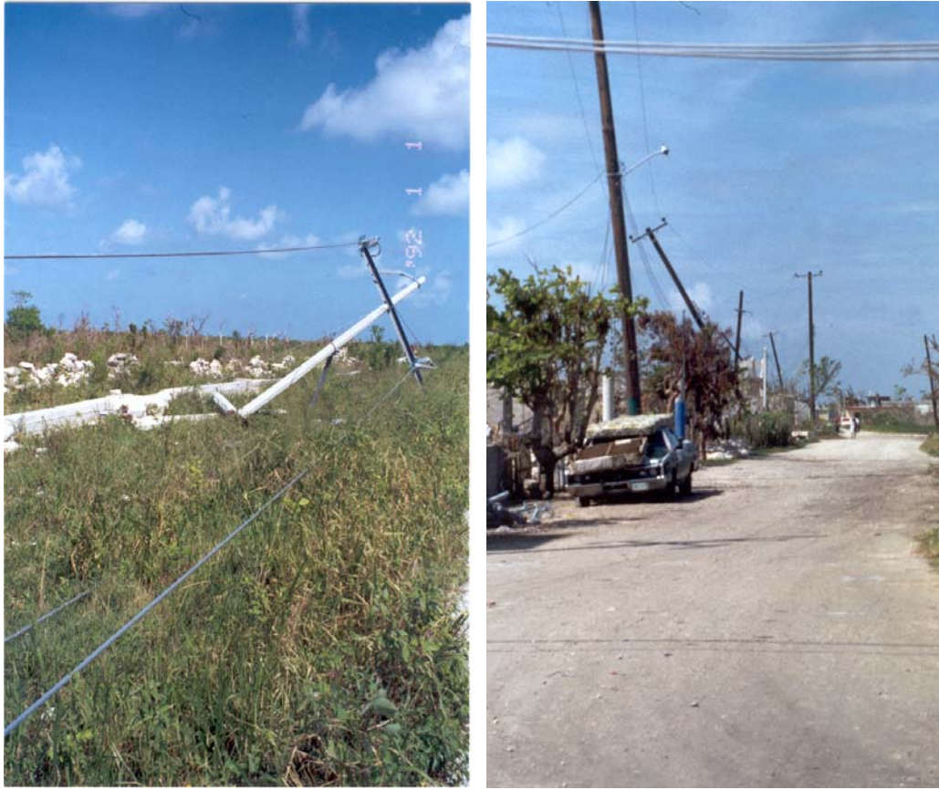
Figura 2.67 Postes de energía eléctrica derribados por la fuerza del viento de Isidore
