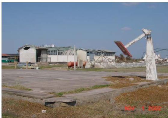
Figura 2.118 Daños observados en edificios escolares
