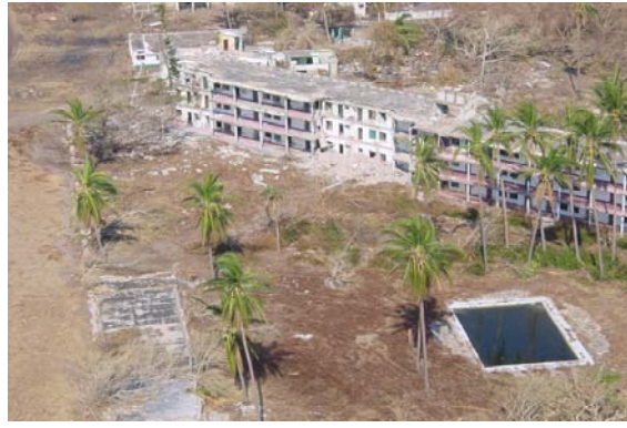
Figura 2.110 Daños en edificaciones del puerto de San Blas, Nayarit
