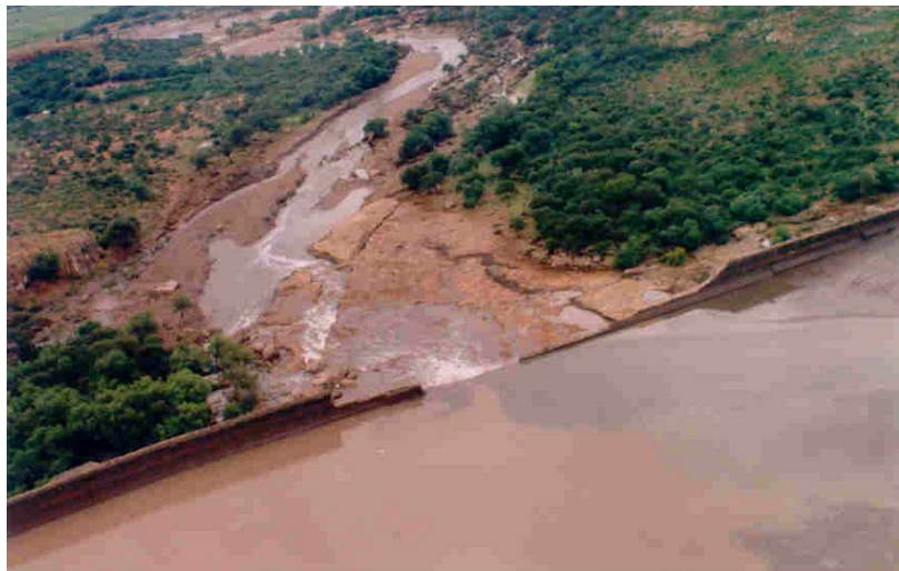
Figura 2.20 Abertura de doble escotadura dejada por falla de la cortina
