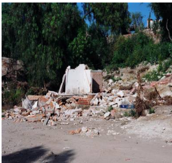
Figura 2.30 Vista de una vivienda con destrucción total en la localidad de la Ventilla en el municipio de Villa de Reyes, San Luis Potosí. En ella ocurrieron los nueve decesos reseñados anteriormente
