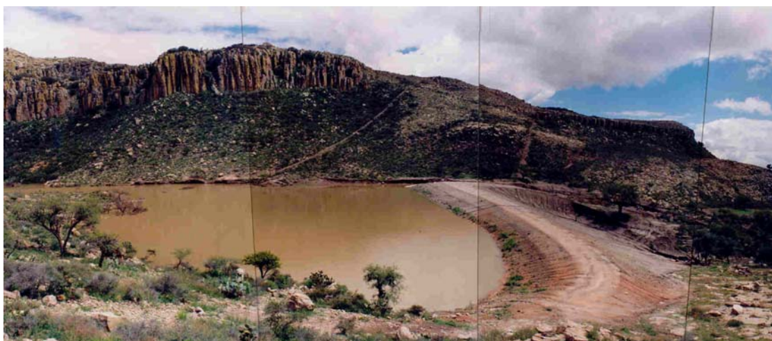
Figura 2.39 Bordo de tierra ubicado aguas arriba de la presa El Capulín
