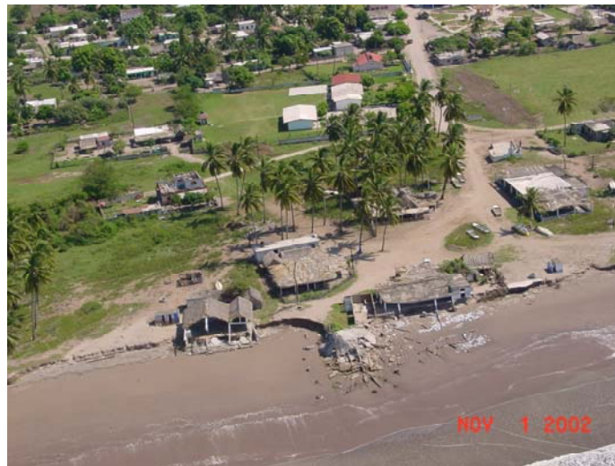
Figura 2.121 Daños observados en construcciones cercanas a la línea de playa
