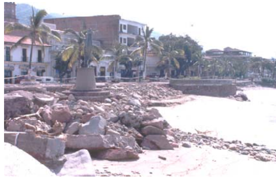
Figura 2.104 Aspecto del malecón después del paso del huracán
