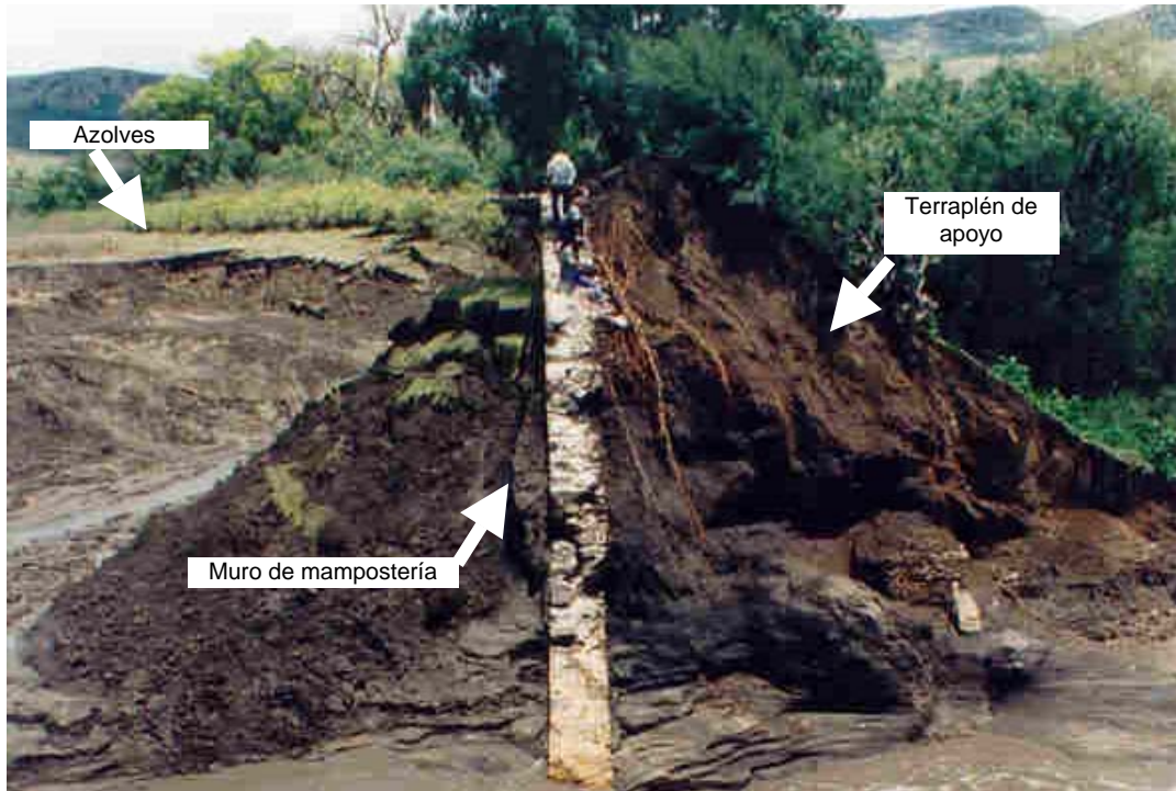
Figura 2.33 Muro de mampostería y terraplén de apoyo en el paramento agua abajo de la cortina
