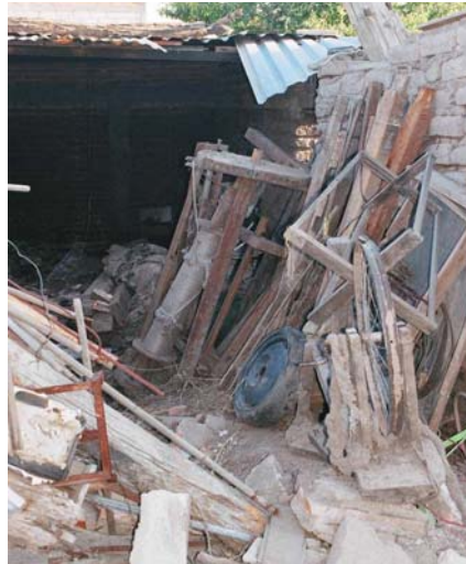
Figura 2.45 Pequeños talleres artesanales fueron destruidos por la ola en Villa García
