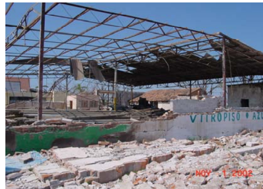
Figura 2.117 Desprendimiento del techo de una nave industrial
