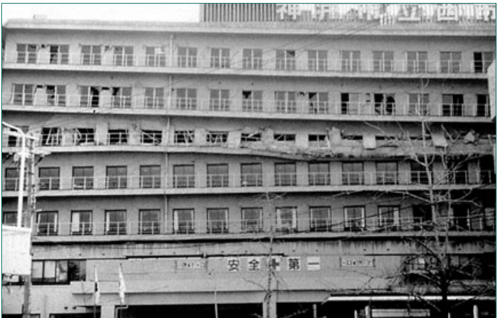
Fotografía 3. Colapso del Quinto Piso, Hospital Municipal de Kobe, 1995
