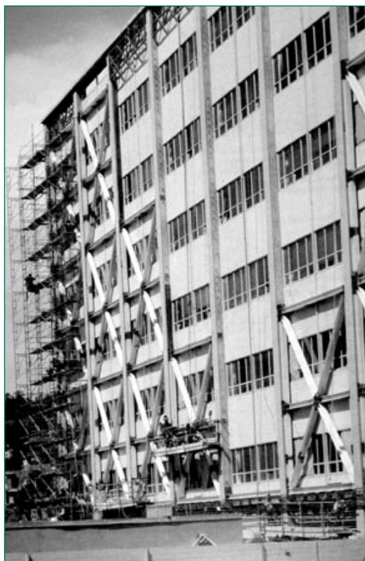
Fotografía 13. Refuerzo con diagonales
