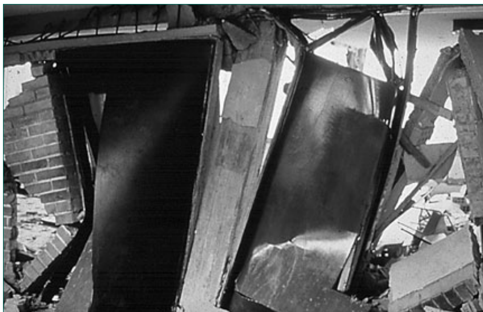
Fotografía 5. Falla de columnas por falta de sismorresistencia
