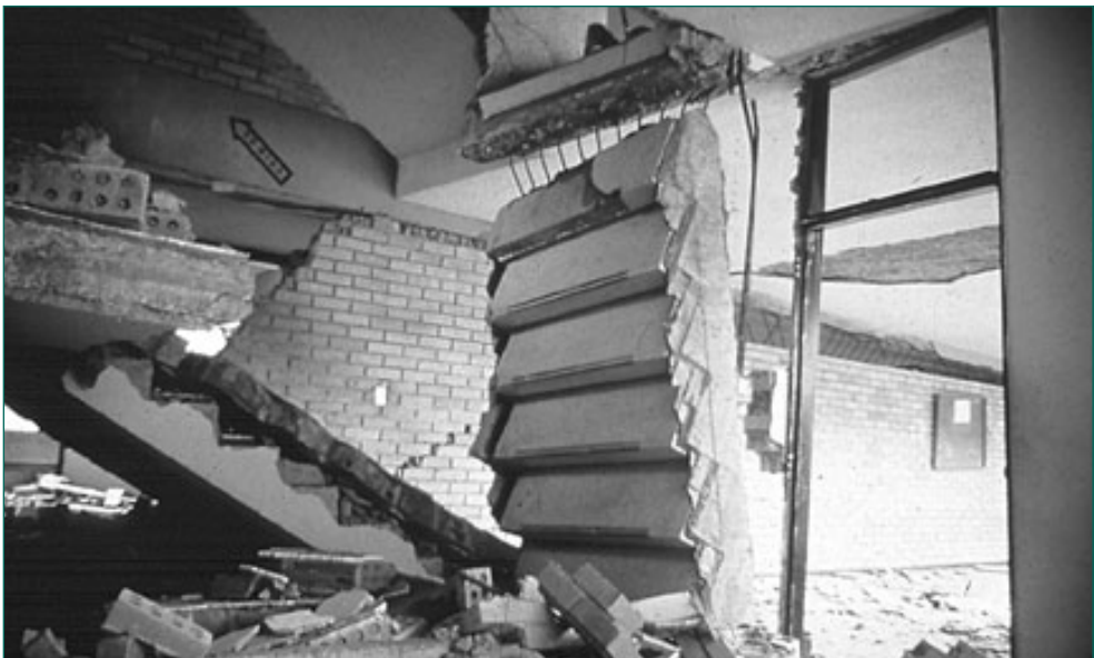
Fotografía 6. Colapso de escalera por falta de sismorresistencia
