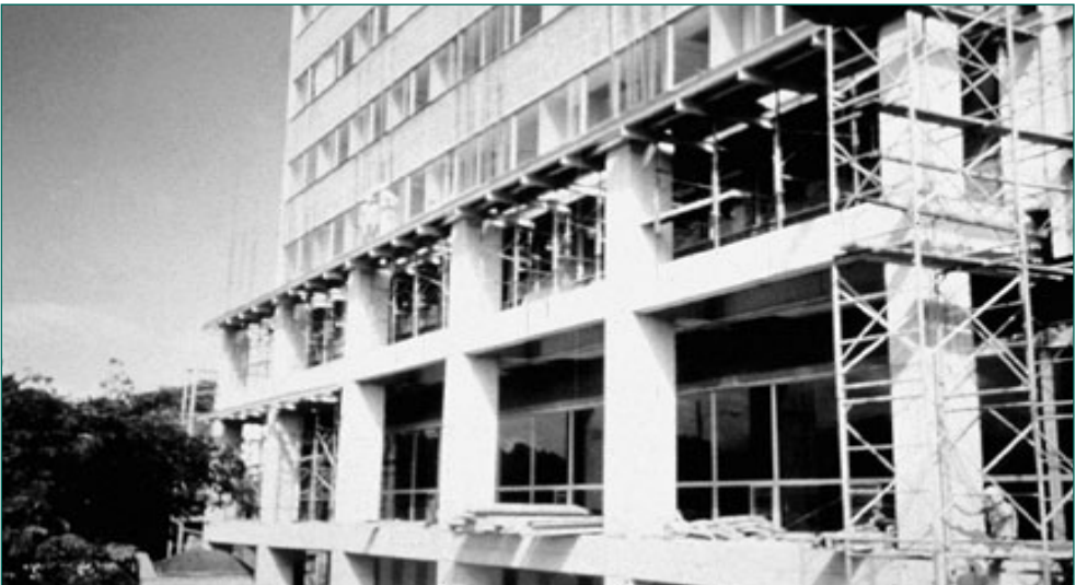
Fotografía 14. Refuerzo del Hospital México
