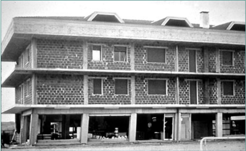
Fotografía 9. Falla en planta baja por piso suave
