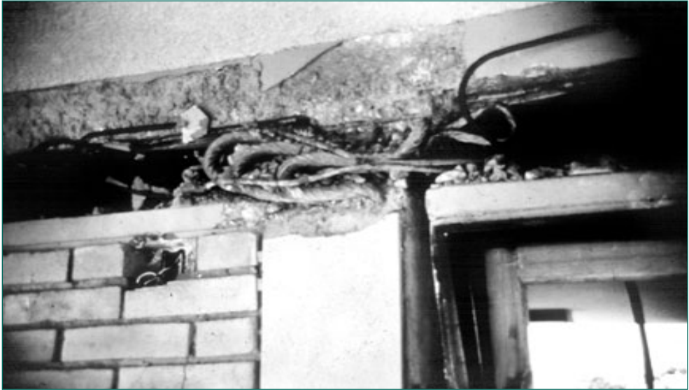
Fotografía 18. Efecto de columna corta
