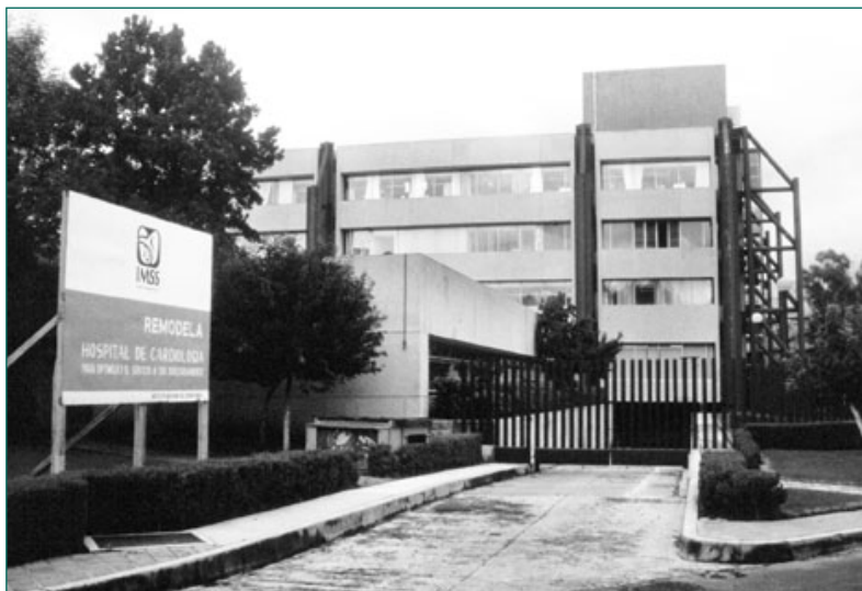
Fotografía 12. Hospital de Cardiología del Instituto Mexicano del Seguro Social que fue reforzado usando pórticos contrafuertes luego del sismo de México 1985.
