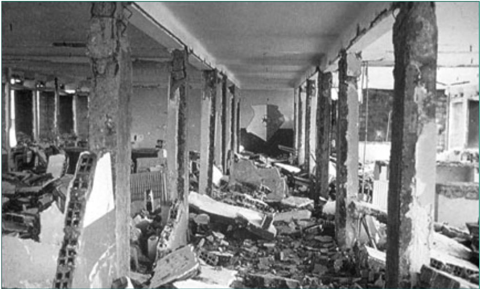
Fotografía 24. Muros destruidos por flexibilidad de la estructura
