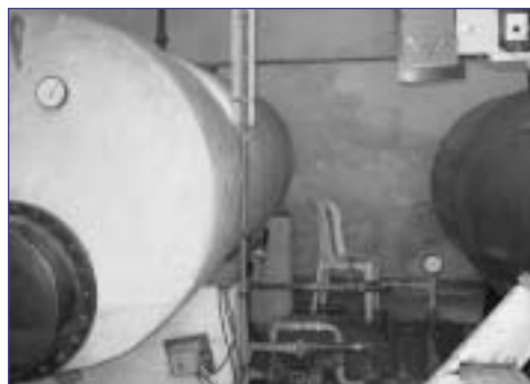
Foto 42. Sala de máquinas del hospital Dr. Carlos Vera Candiotti. Santa Fe, Argentina, 2004.
