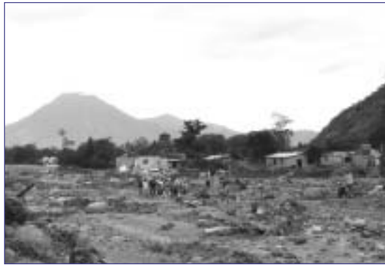
Foto 3. Efecto de las inundaciones súbitas en edificaciones. Panajachel, Departamento Sololá, Guatemala, 2005.
