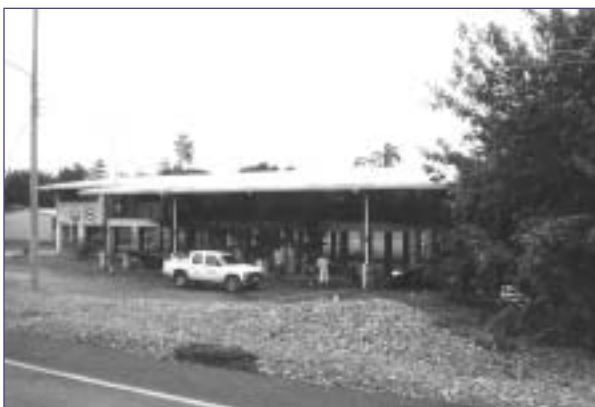
Foto 34. Protección de un edificio mediante pilotes. Sixaola, provincia de Limón. Costa Rica, 2005.
