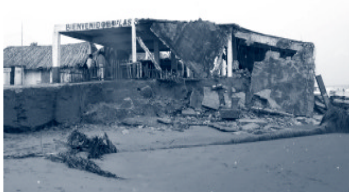
Daños por oleaje en la playa de Palmar de Cuautla, Nayarit
