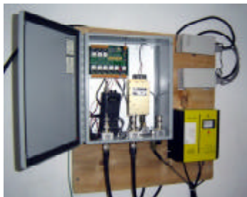
Instalación de Equipos, Mactumatza
