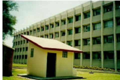
Estación sísmica en el Instituto Mexicano del Petróleo
