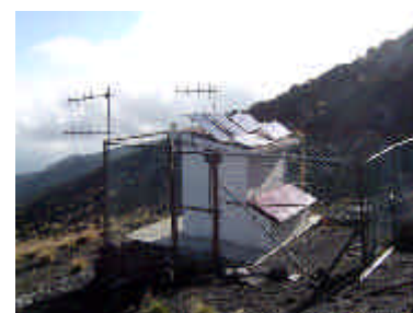
Estación sísmica Canario
