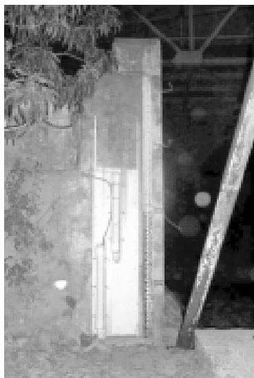
Estación de nivel Malpaso del SAH de Tapachula
