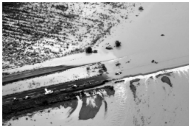
Inundaciones causadas por el huracán "Lane" en la localidad de Quila del municipio de Culiacán y afectaciones de los vientos causados por el mismo huracán en Culiacán, Sinaloa.
