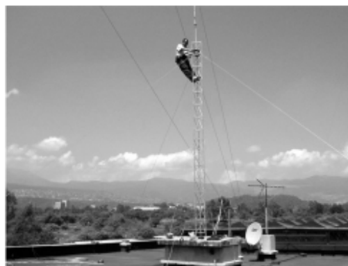
Instalación antenas de comunicación
