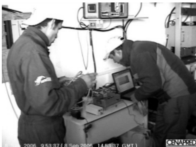
Instalación cámara térmica
