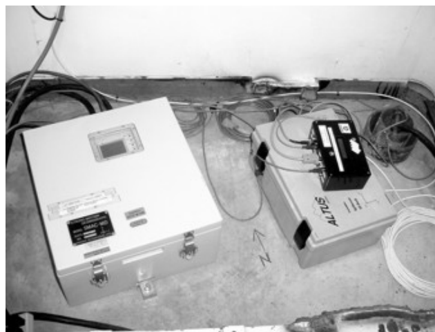
Instalación de circuito de sincronización K2-SMAC
