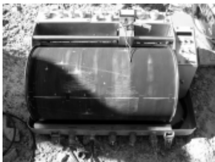
Instalación de equipos en Bahía de Asunción, BCS
