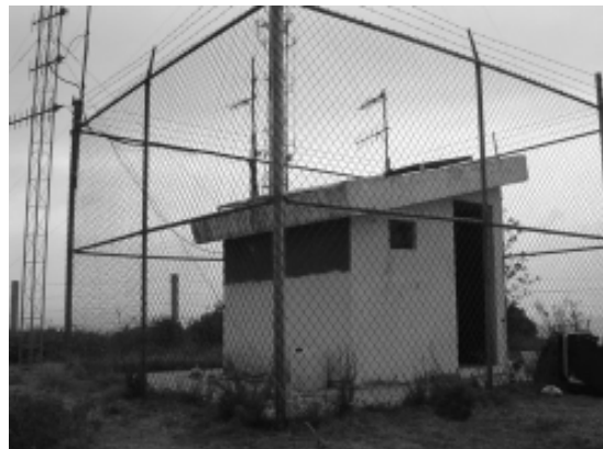
Estación repetidora de comunicación, Caló
