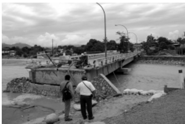
Vista del puente de libramiento de la carretera federal Tapachula - Arriaga
