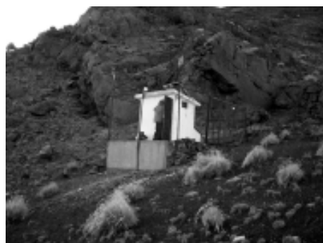
Estación sísmica Canario
