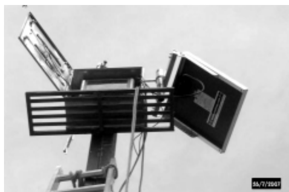
Aspectos de la reinstalación de la estación de nivel Campestre, del SAH del río Sabinal
