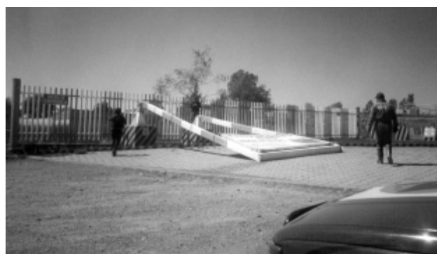
Anuncio dañado por los fuertes vientos en Huamantla, Tlaxcala.
