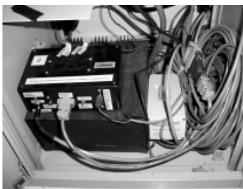
Instalación de circuitos de sincronización
