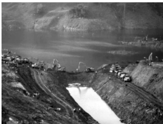
Reapertura del río Grijalva por medio de un canal que libra el deslizamiento del 4 de noviembre de 2007
