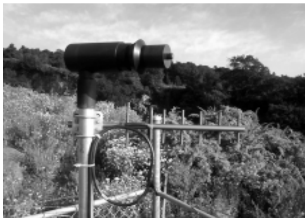
Modernización de enlaces de comunicación
