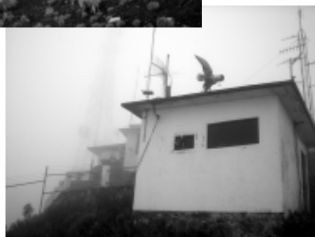
Estación repetidora y sísmica de Altzomoni
